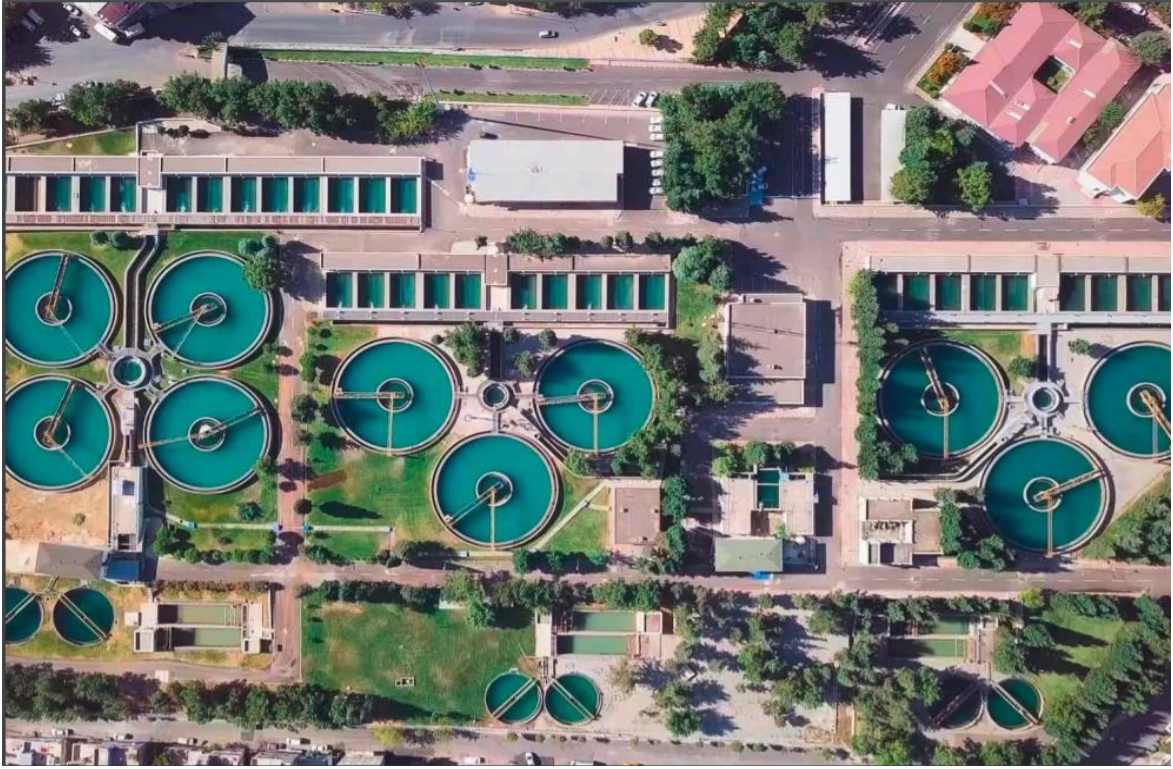
Fotoğraf 9. Hacibaba İçme Suyu Arıtma Tesisi (GASKİ, 2021c).
