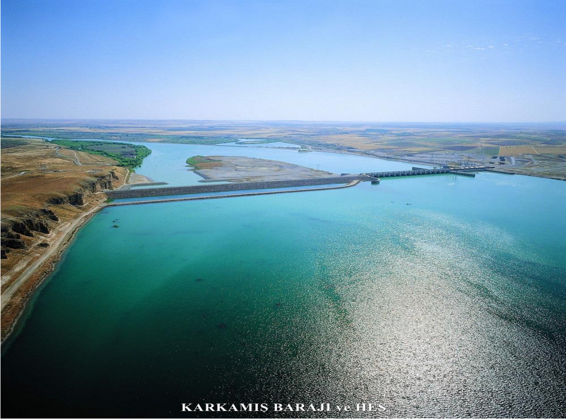
Fotoğraf 2. Karkamış Barajı ve Hidroelektrik Santrali (temelsu, 2022).
