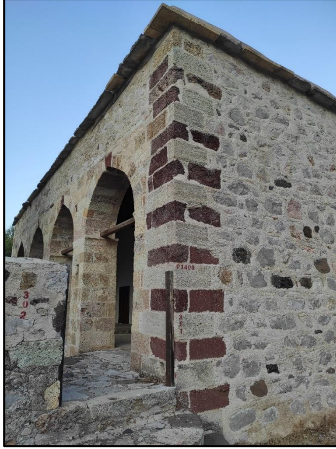
Fotoğraf 2. 34: Restorasyon Sonrası Çullu Camii
