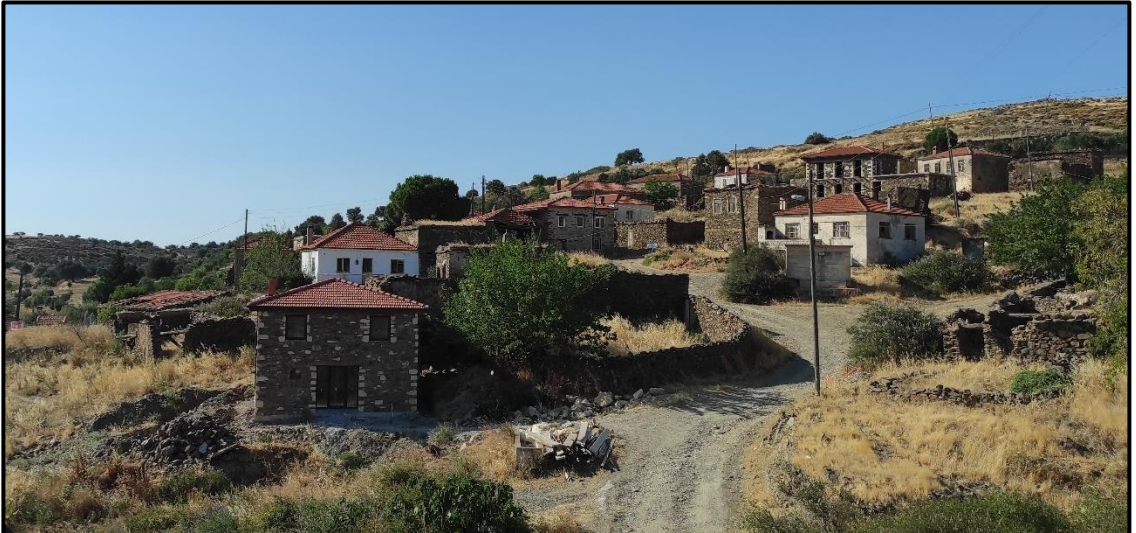
Fotoğraf 2. 18: Salman Köyünde İç İçe Geçmiş Eski ve Yeni Yapılar
