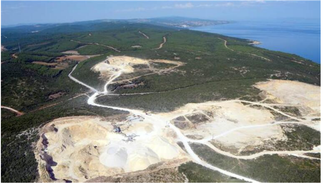
Fotoğraf 34. Mecidiye’de Taş Ocakları Kaynaklı Tahribat
