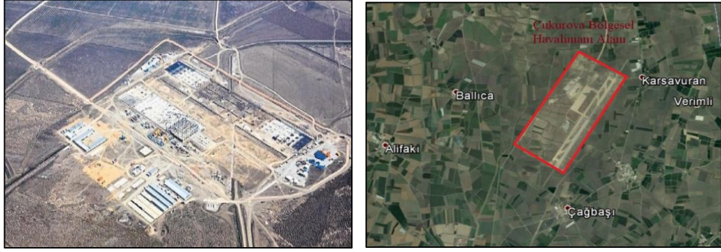
Şekil 58: Çukurova Bölgesel Havalimanı inşaat alanı.
