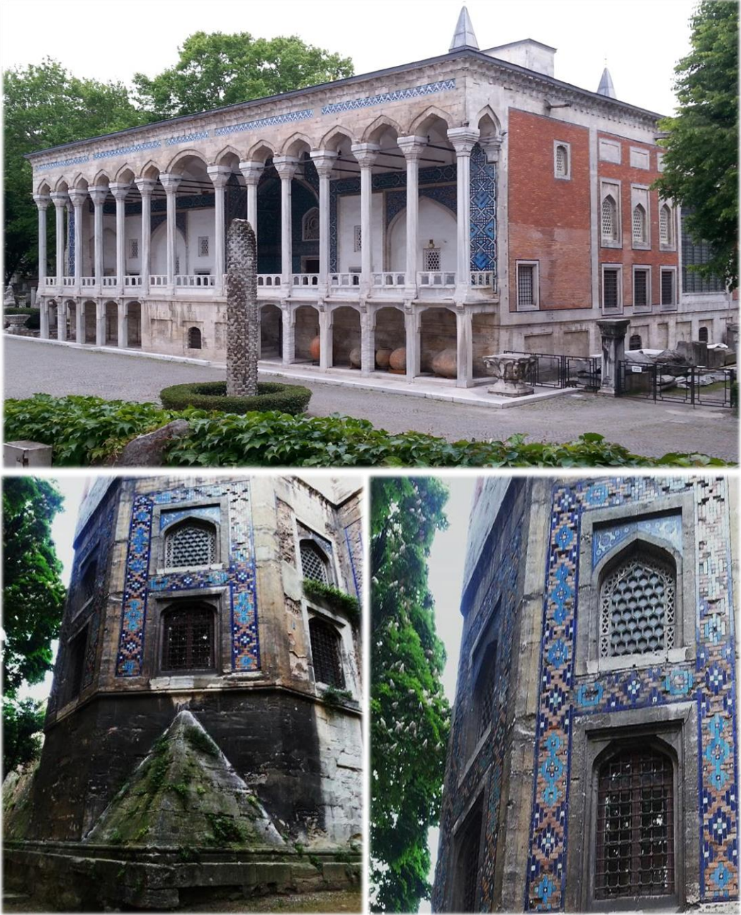
Foto 3.30. Çinili Köşk ve yapının Gülhane Parkı'na bakan cephesindeki mozaik çini süslemeler.
