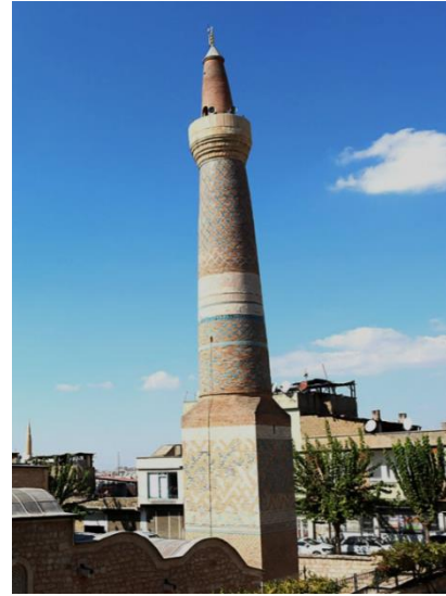
Foto 1.36. Siirt Ulu Camii minaresinin restorasyonun ardından görünümü.
