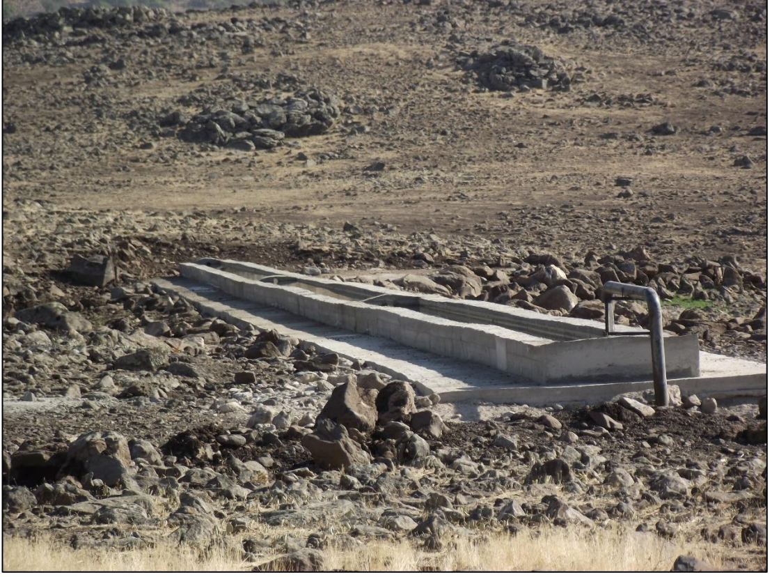
Foto 4. 21: Betondan Yapılan Hayvan Sulama Suvatı (Varto)
