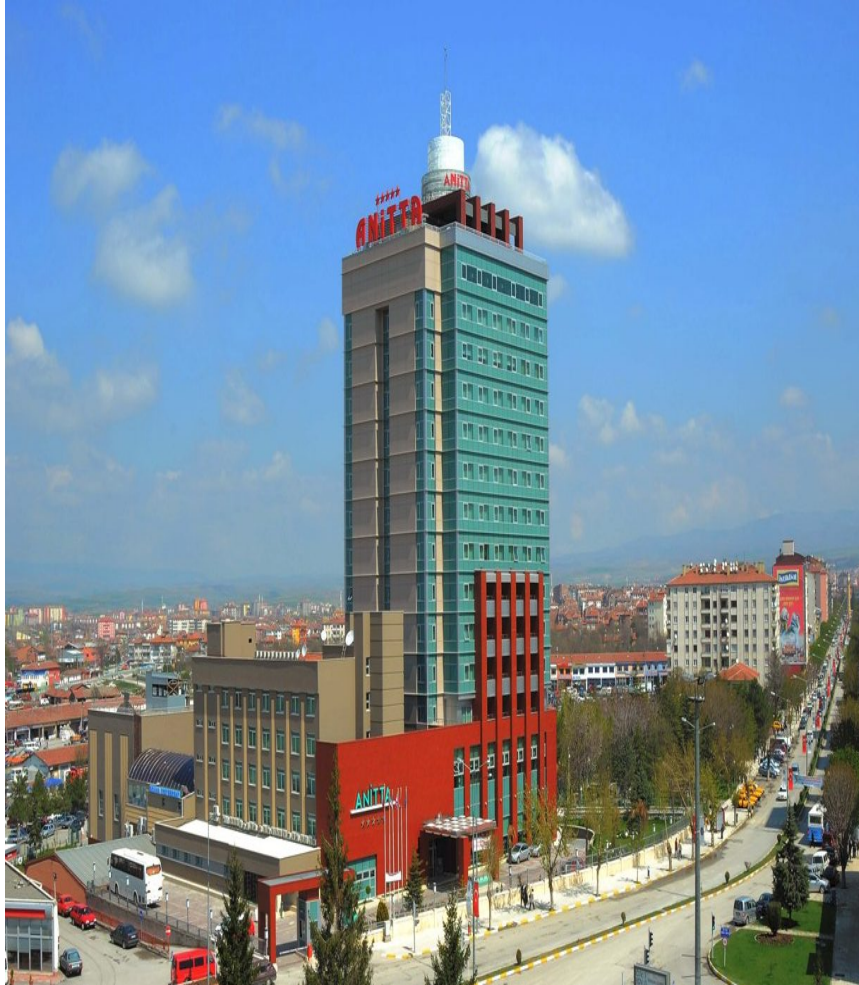
Foto 69: Anitta Otel (Çepni Mahallesi)
