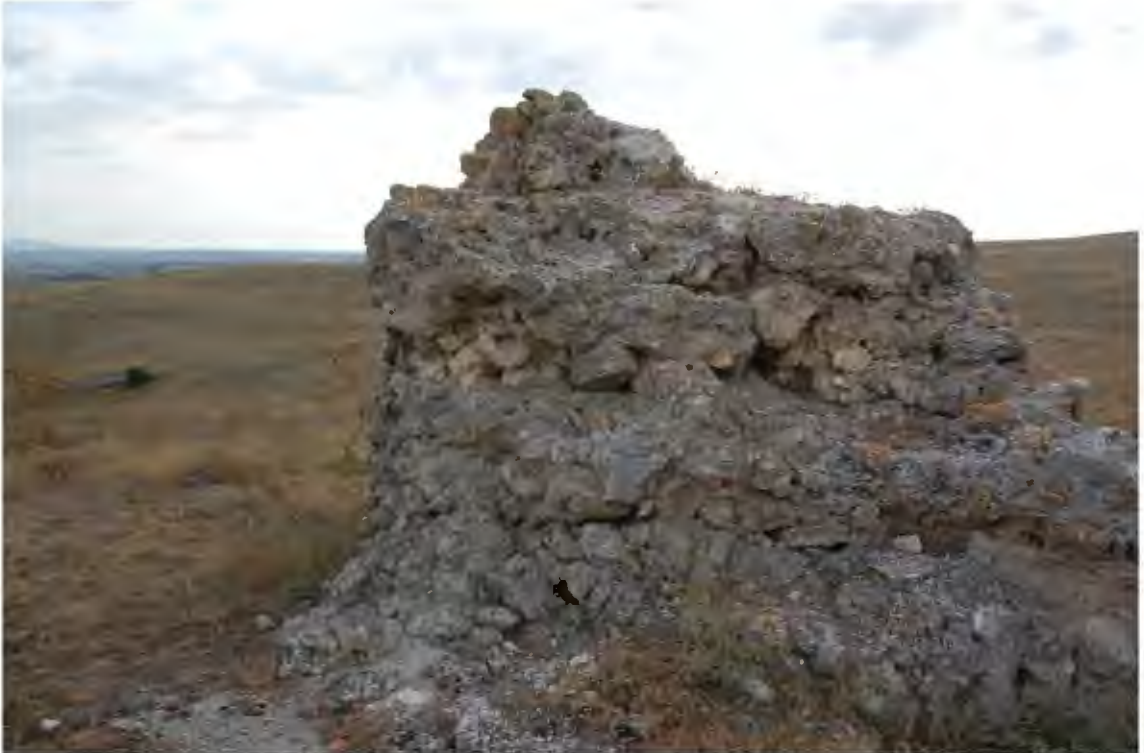
Res. 173. G neydoęu k şedeki sur kalıntısının moloz taş duvar  rg s  ve beyaz har  kullanımı ( .H. Kurtuluş, 2018).
