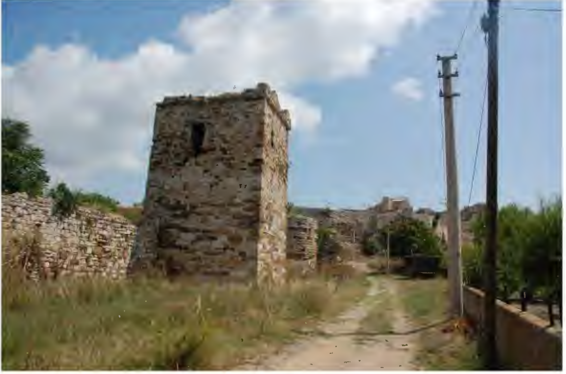
Res. 523. Liman güney duvarının ve kulelerin kale yönünde genel görünümü (İ.H. Kurtuluş, 2018).
