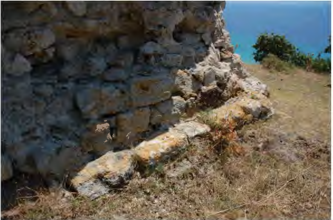
Res. 496. Karaincirli kulenin batı cephesinin güney köşesinde çıkma yapan temel kısmı (İ.H. Kurtuluş, 2018).
