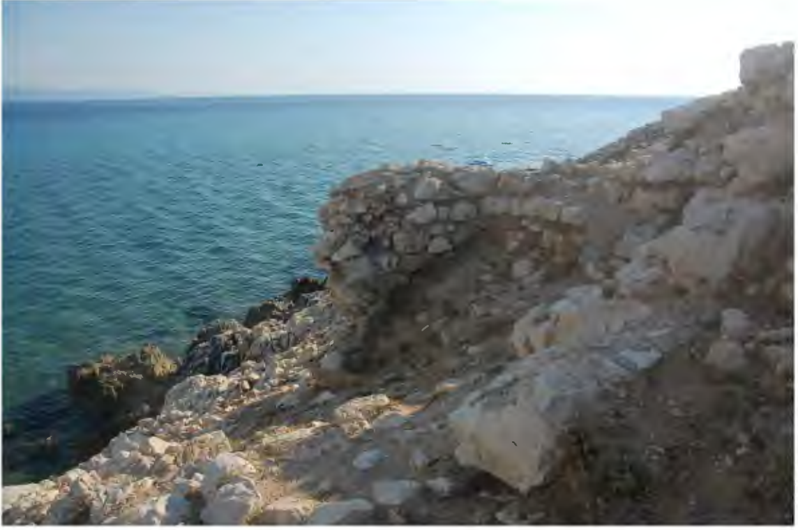
Res. 403. Güneydoğu burcun doğu iç cephesi (İ.H. Kurtuluş, 2018)
