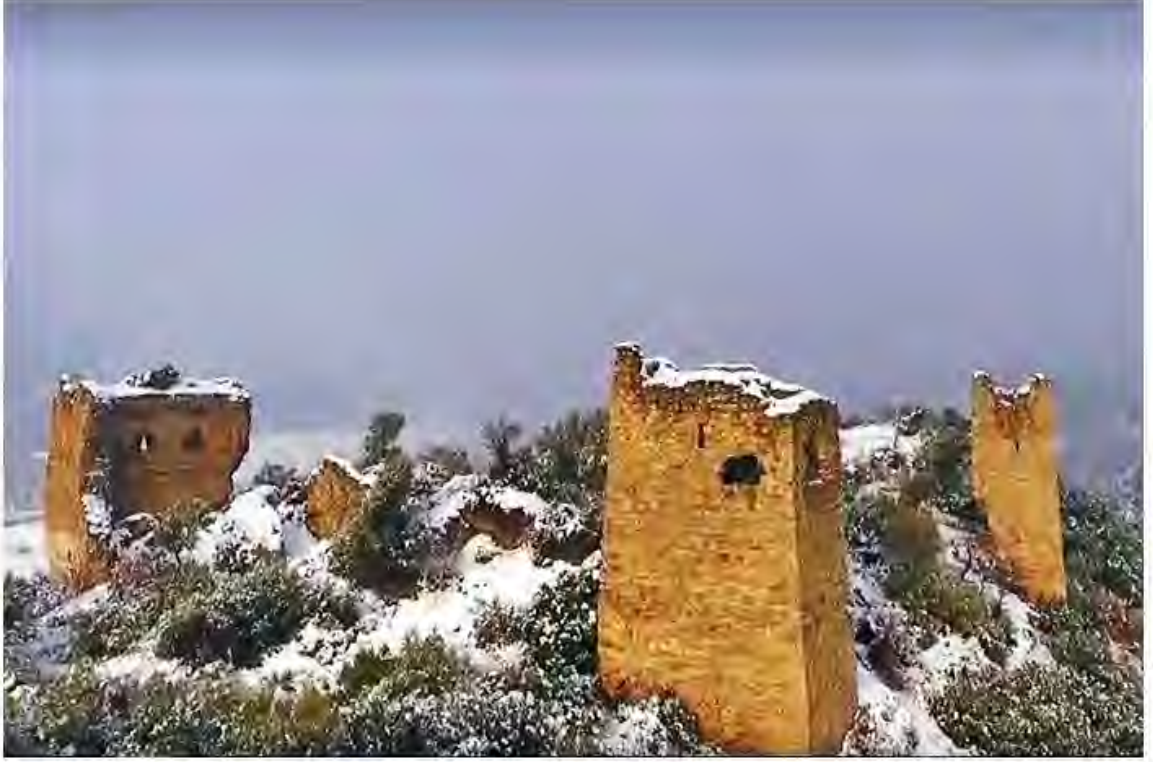
Res. 707. Avantas (Potamos) kalesinden kalan burç ve duvarların genel görünümü ( https://www.kastra.eu/castle.php?kastro=potamo ).
