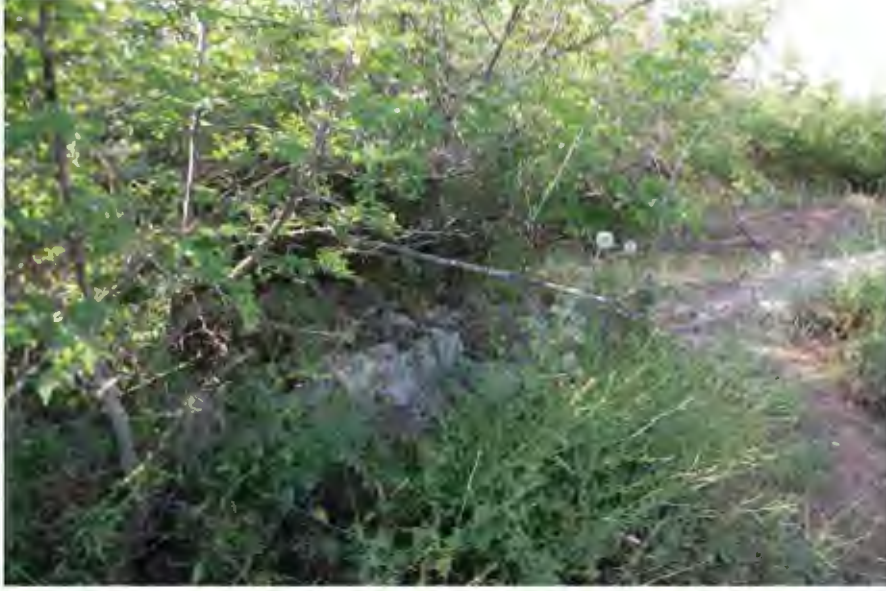
Res. 135. Burcun güneyinde bulunan temel seviyesindeki duvarın, burcun yanında bitişen kısmı (İ.H. Kurtuluş, 2018).
