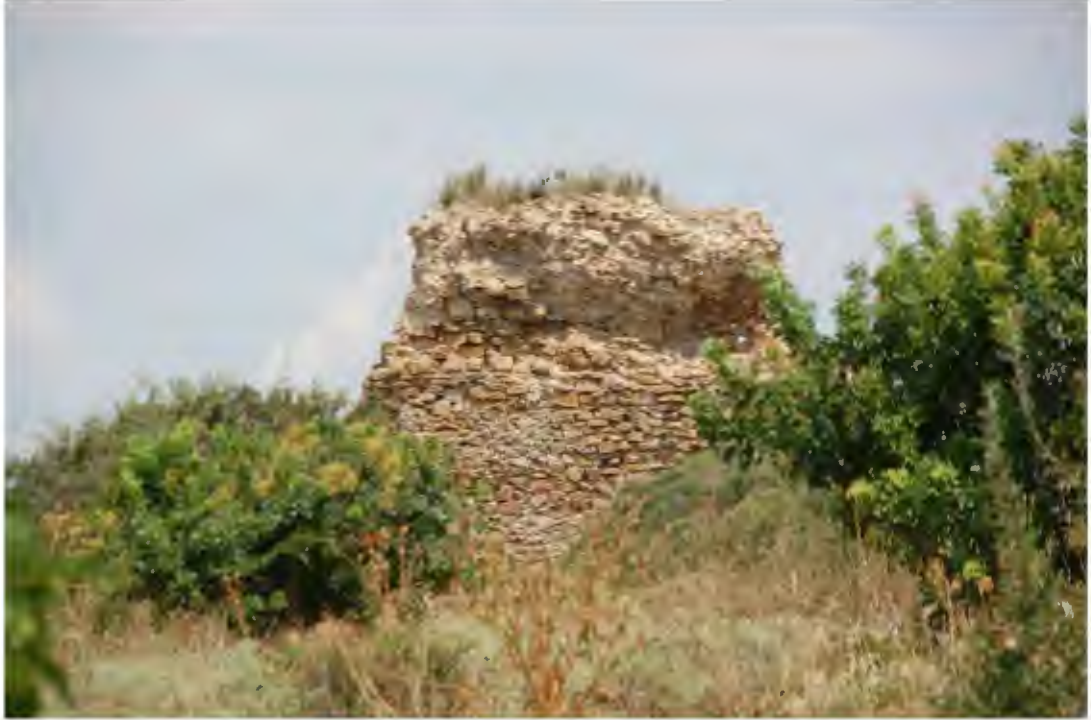
Res. 327. Burcun güney cephesinin genel görünümü (İ.H. Kurtuluş, 2018).
