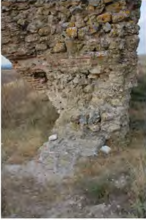
Res. 166. Güney sur kalıntısının doğu yönünde temel seviyesinde izlenebilen kısmı (İ.H. Kurtuluş, 2018).
