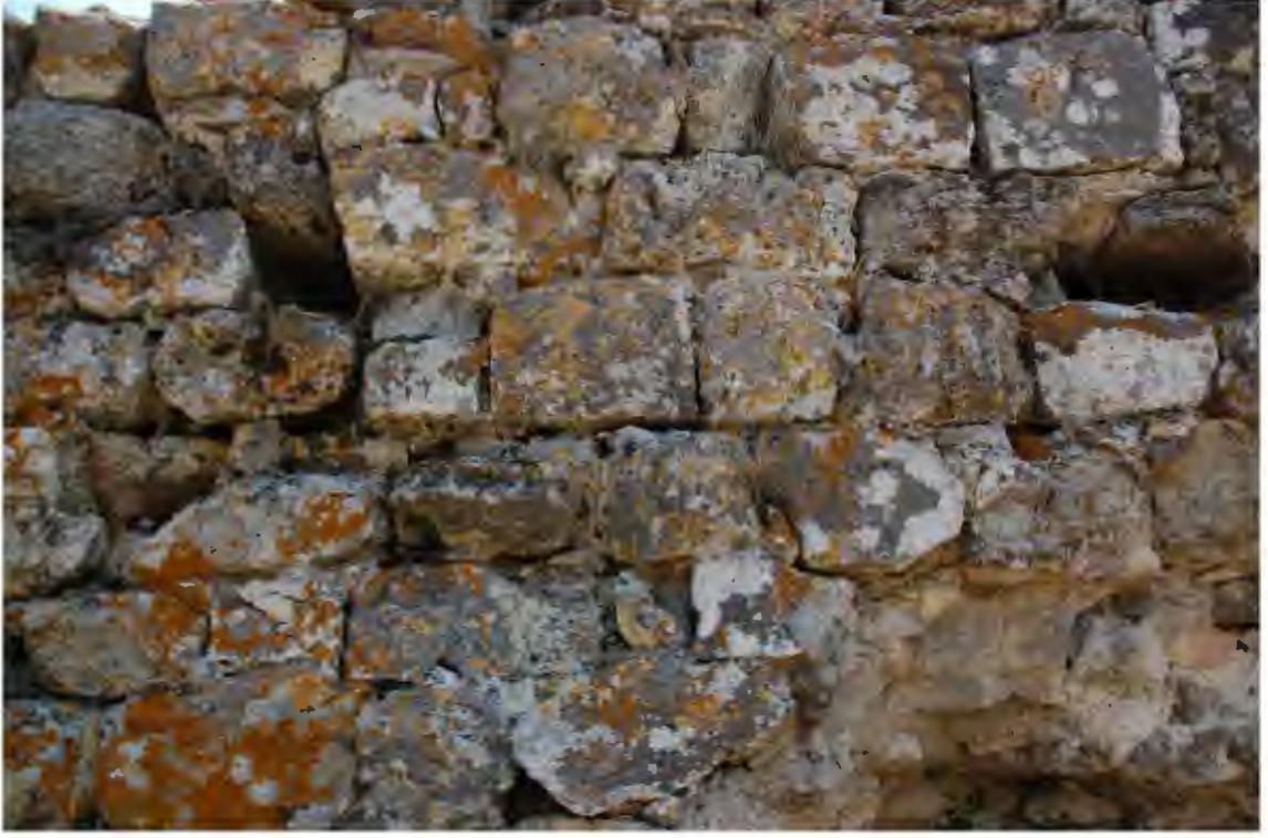
Res. 493. Kule cephesinde çok sayıda hatıl delikleri bulunmaktadır (İ.H. Kurtuluş, 2018)
