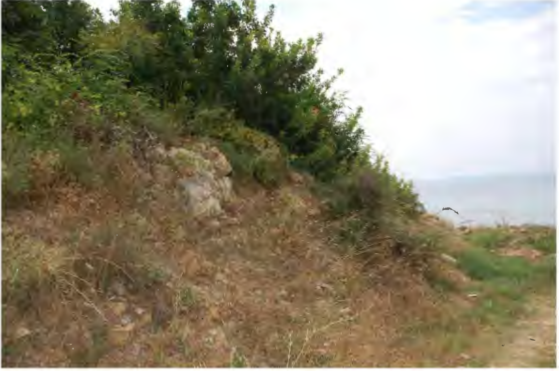
Res. 369. Kalenin dış batı cephesinde bulunan harçlı duvar kalıntısı (İ.H. Kurtuluş, 2018)
