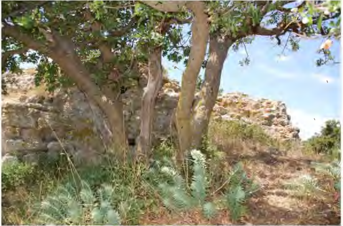
Res. 502. Karaincirli Kule'nin doğu cephesi (İ.H. Kurtuluş, 2018).
