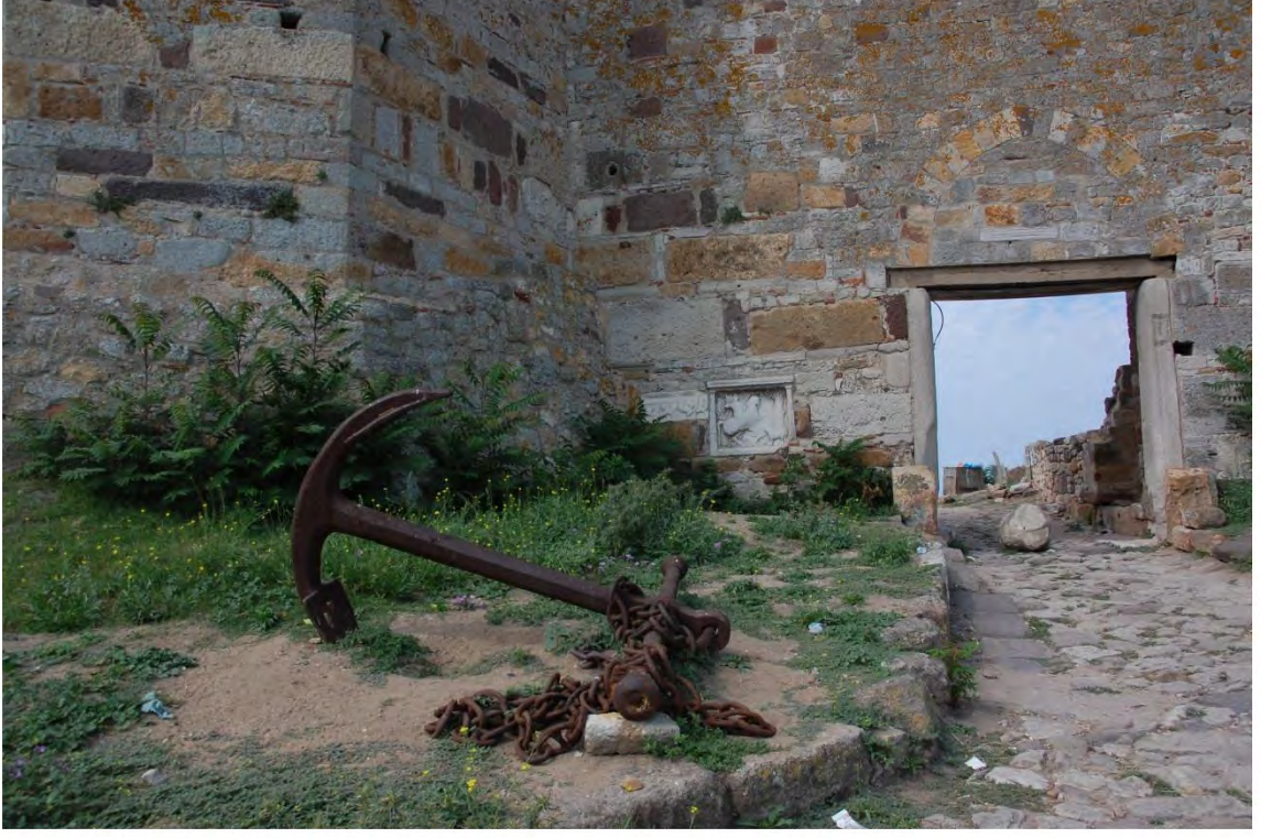
Res. 517. Enez Kalesi giriş kapısı üzerinde Osmanlı dönemi sivri kemer uygulaması (İ.H. Kurtuluş, 2018).
