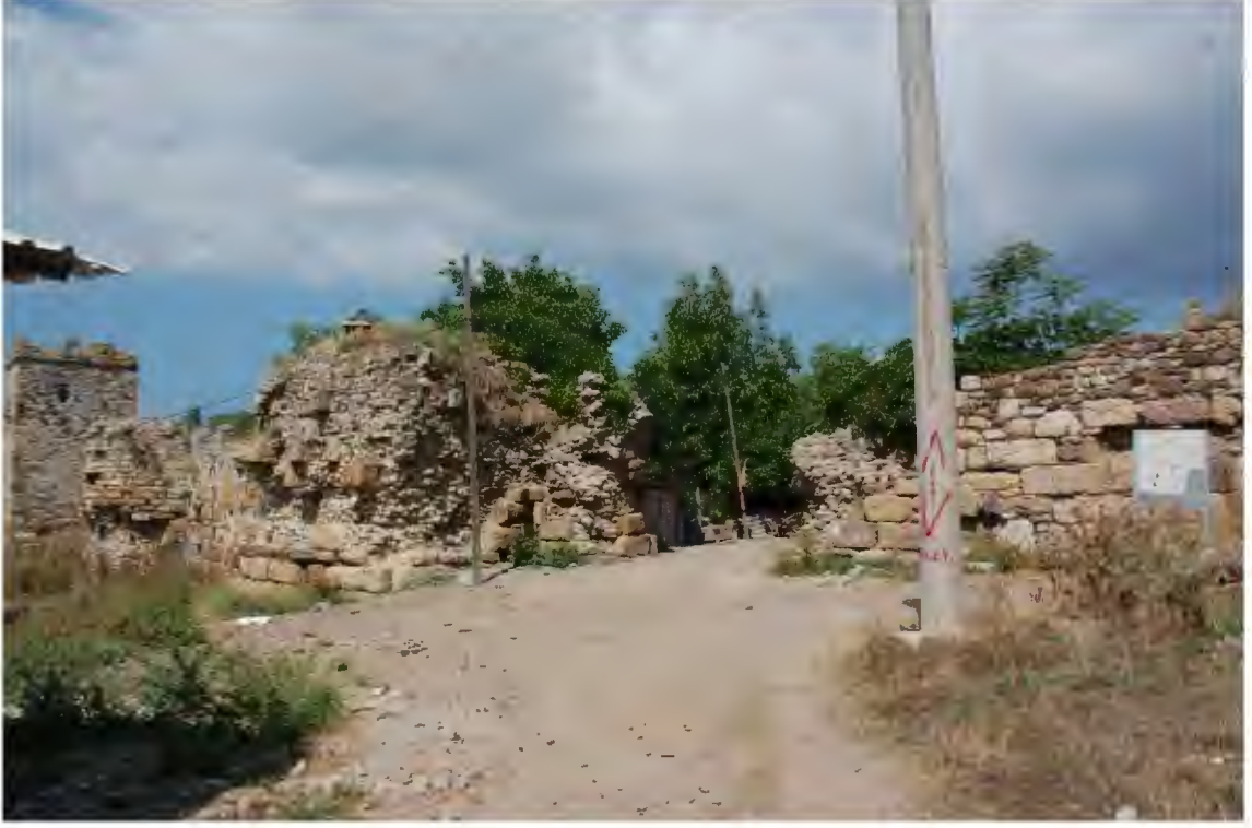
Res. 525. Kemerî yıkılmış durumda olan liman geiř kapısı (İ.H. Kurtuluř, 2018).
