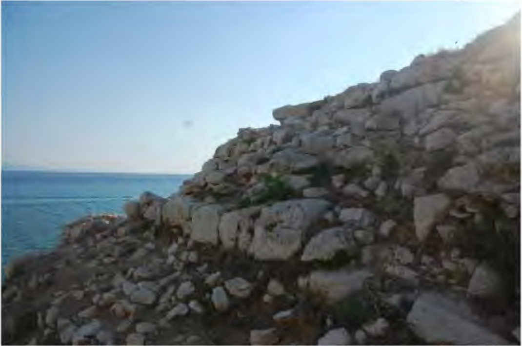
Res. 384. Surların temel kısmında büyük blok taşlar kullanımı (İ.H. Kurtuluş, 2018)
