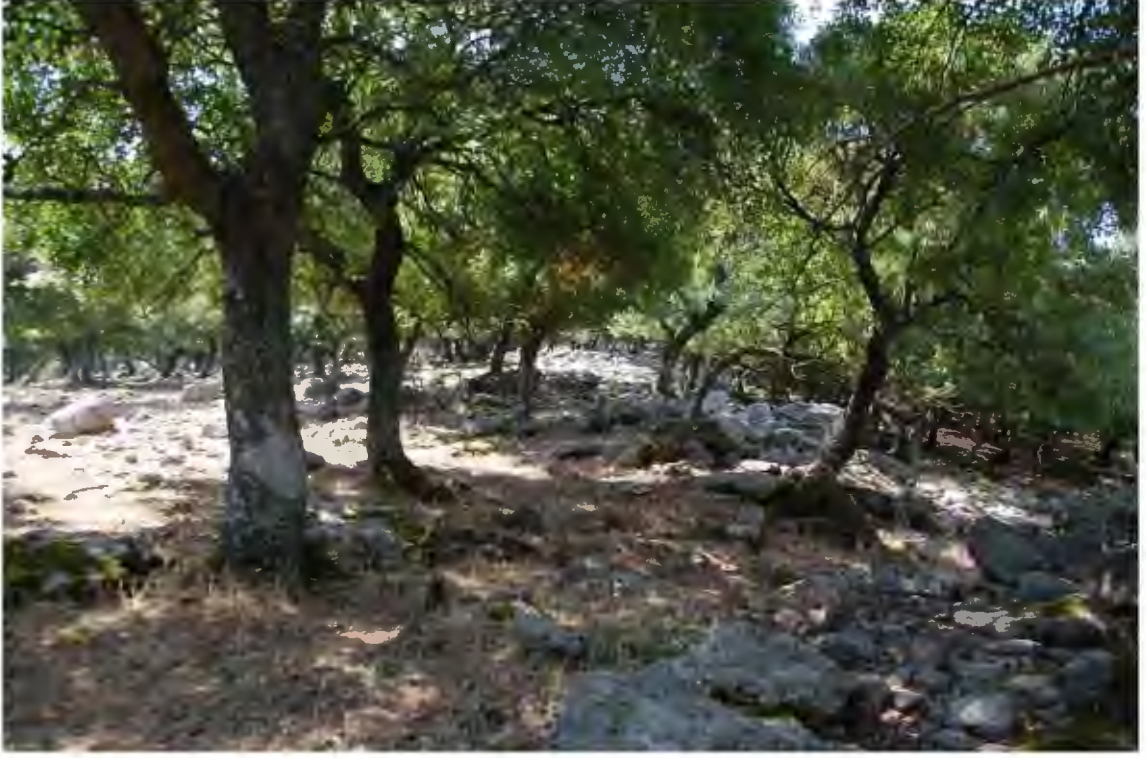
Res. 563. Hisarlıdağ Tahkimatlı alanının 1 no'lu duvarında, duvar bütünlüğünün yıkılarak bozulmuş bir bölümü (İ.H.Kurtuluş, 2018).
