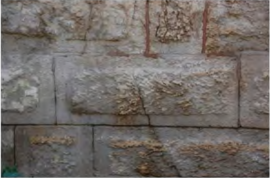
Res. 7. Edirne kalesi, güneydoğu surlarda, bosajlı yüzeye sahip sur taşları (İ.H. Kurtuluş, 2019).
