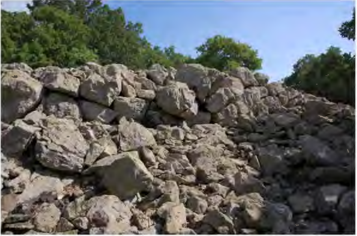
Res. 639. Dairesel tahkimatlı yapı duvarının kuzeybatı-batı dönüş kısmının cepheden bir görünümü (İ.H. Kurtuluş, 2018)
