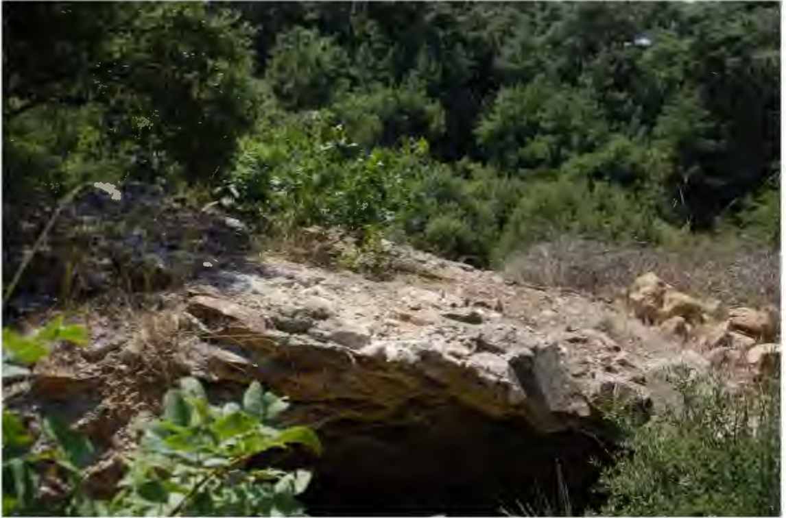
Res. 288. Burçtan kopan soldaki duvar kütlesi (İ.H. Kurtuluş, 2018).
