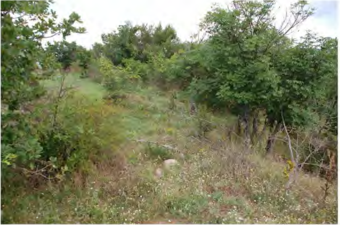
Res. 94. Ömeroba Kalesinin güney ve doğu duvarının köşesi (İ.H. Kurtuluş, 2018).
