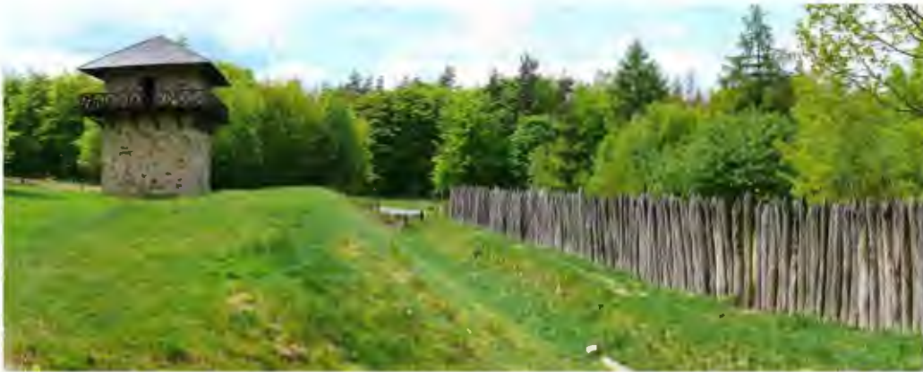
Res. 506. Roma gözetleme kulesi. Ehrenbach, Hesse, Almanya. Taş kuleye eklenmiş ahşap yürüme bantları yapılmış ve üzeri ahşap çatı ile örtülmüştür (wikiloc com).
