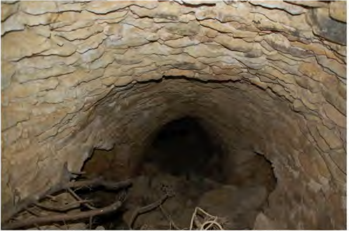
Res. 268. Galeri içinde sağ ve sol duvarlarda kaçak kazı yapan defineciler tarafından yıkılan kısımlar (İ.H. Kurtuluş, 2018).
