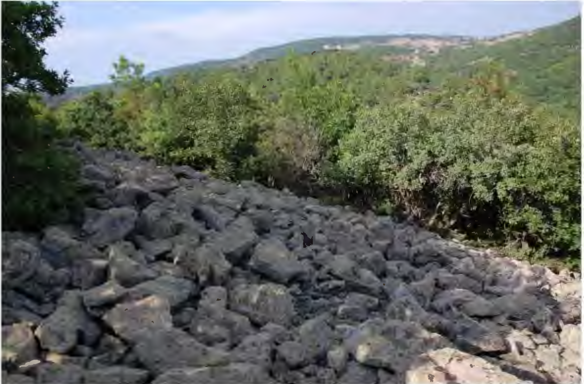
Res. 649. Doğu duvarının kuzeye doğru döndüğü kısım (İ.H. Kurtuluş, 2018)
