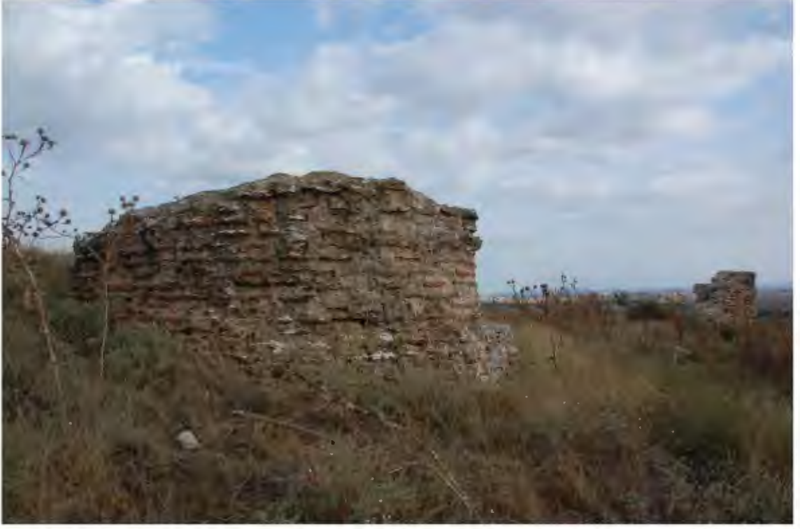
Res. 171. Ön planda kalenin güneydoğu burcu, arkada doğu ve güney surunun köşesinde bulunan duvar kalıntısı (İ.H. Kurtuluş, 2018).
