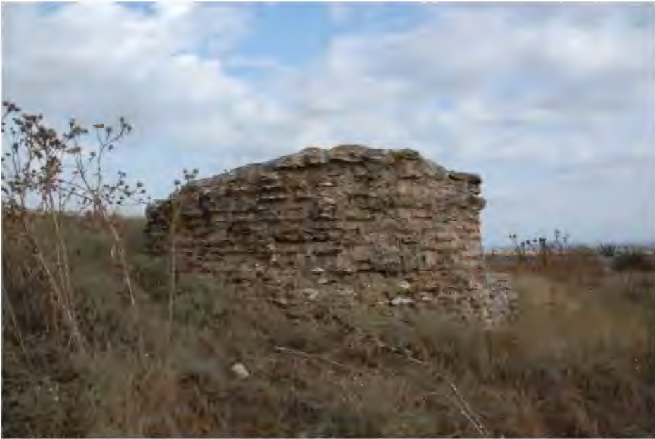
Res. 169. Güneydoğu burcun güney (dış) cephesi (İ.H. Kurtuluş, 2018).
