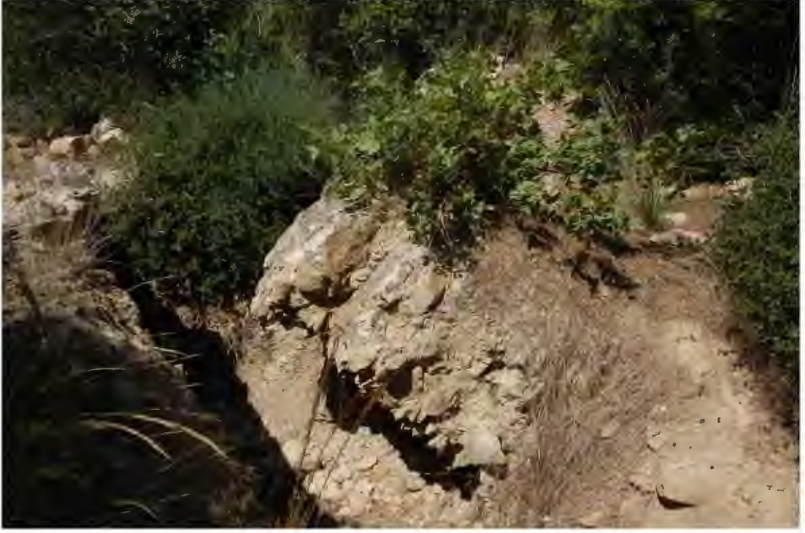
Res. 287. Burçtan kopan sağdaki duvar kütlesi (İ.H. Kurtuluş, 2018).
