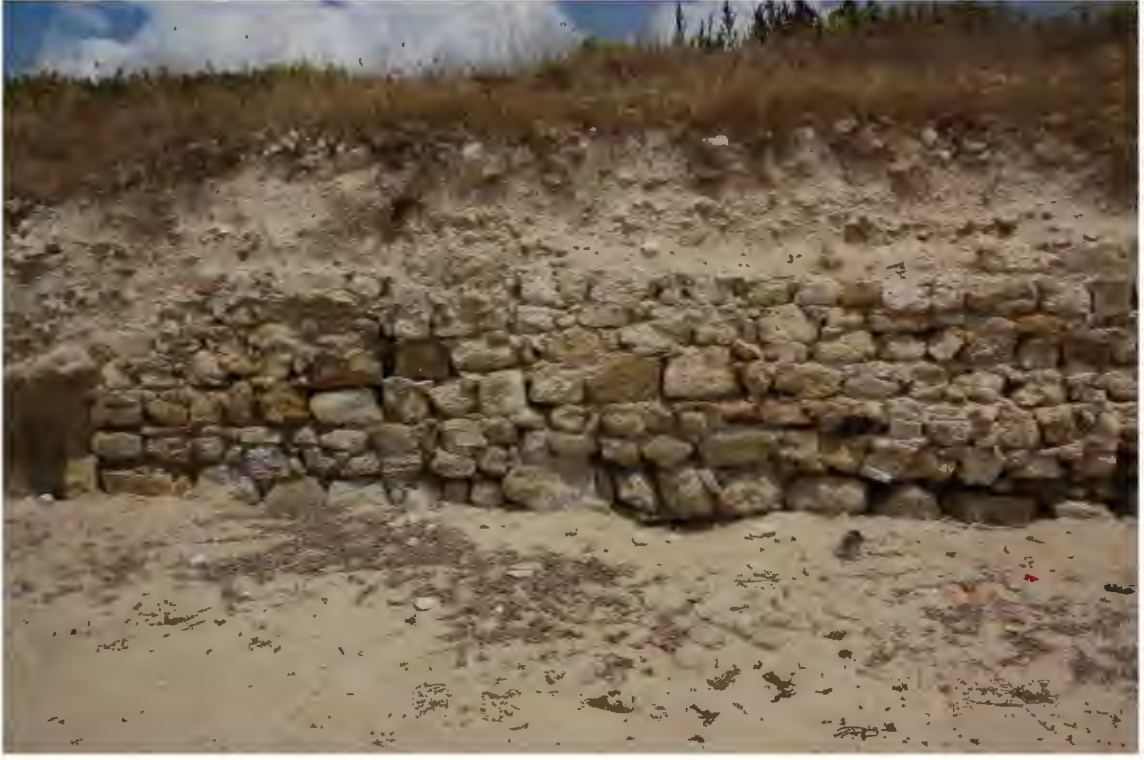
Res. 451. Tuğla hatıl kullanılmayan güney duvarı (İ.H. Kurtuluş, 2018)
