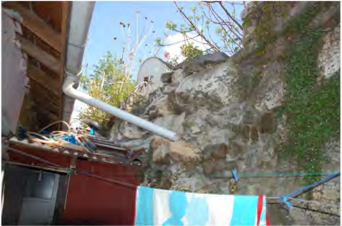
Res. 26. Mumcular sokağındaki evin arka kısmında, 4 numaralı surun batı kısmının Roma döneminden kalan sur parçasının üst bölümü (İ.H. Kurtuluş, 2019).
