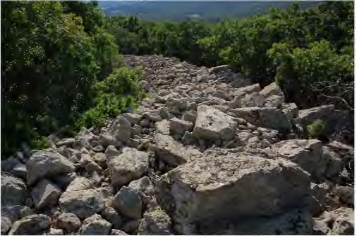
Res. 636. Kuzeybatı ve batı dönüşünün üstten genel görünümü. (sağda) duvarın dış cephesini oluşturan büyük blok taşlar görülmektedir (İ.H. Kurtuluş, 2018)
