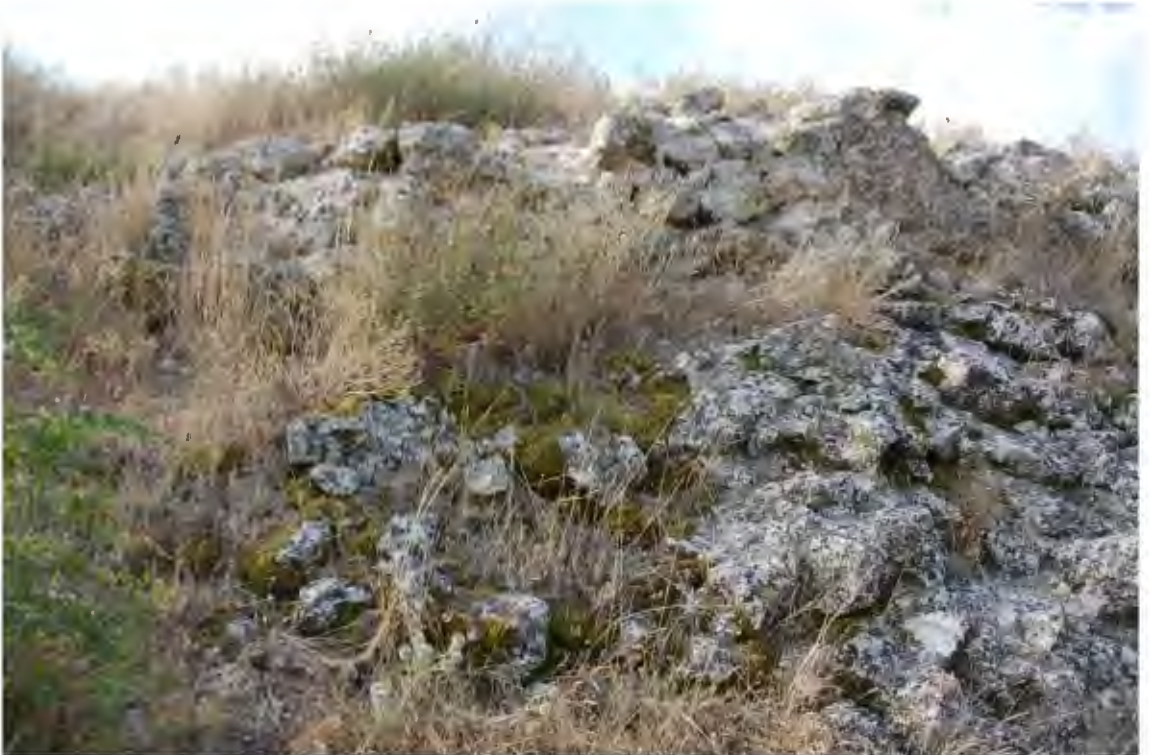
Res. 194. Kuzeybatı köşeye yakın bulunan duvar moloz taş duvar örgüsüne sahiptir ve çok güçlü bir beyaz harç kullanılmıştır (İ.H. Kurtuluş, 2018).
