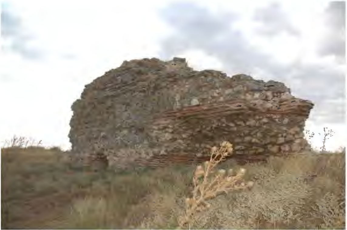
Res. 163. Güney sur kalıntısının, moloz taş - tuğla alternatif dizilimli iç cephesi (İ.H. Kurtuluş, 2018).
