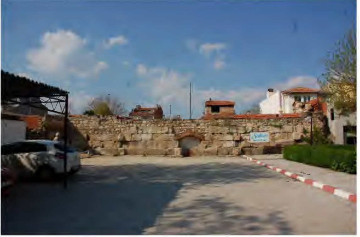
Res. 24. Kalenin kuzey surunun güney cephesi. Roma ve Bizans dönemi sur dokusu izlenmektedir (İ.H. Kurtuluş, 2019).
