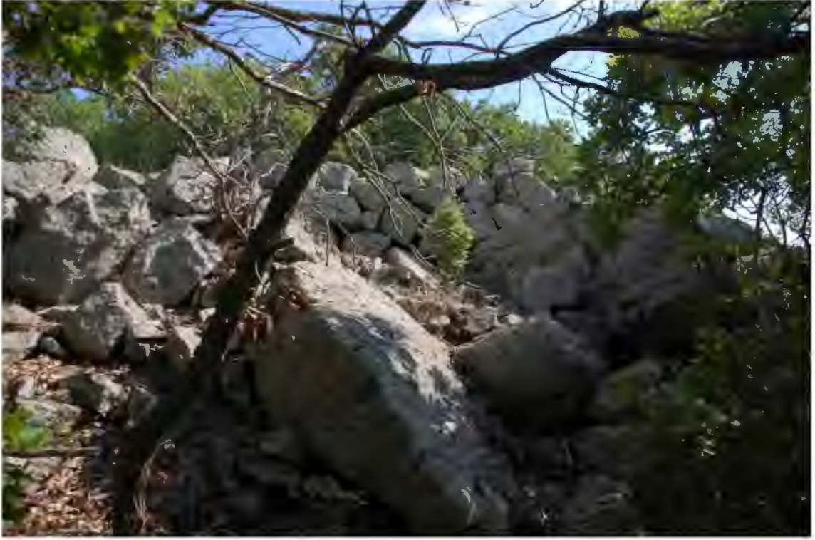
Res. 637. Dairesel tahkimatlı yapının kuzeybatı bölümünde, ana kayayla birleştirilmiş bölümünün dıştan cephe görünümü. (İ.H. Kurtuluş, 2018)
