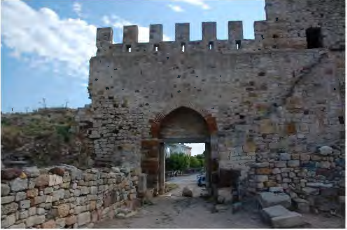
Res. 518. Enez kalesi ana girişin iç ten görünümü. Duvarın üstünde dendaneler, mazgal delikleri ve seyirdim yeri günümüze ulaşmıştır (İ.H. Kurtuluş, 2018).
