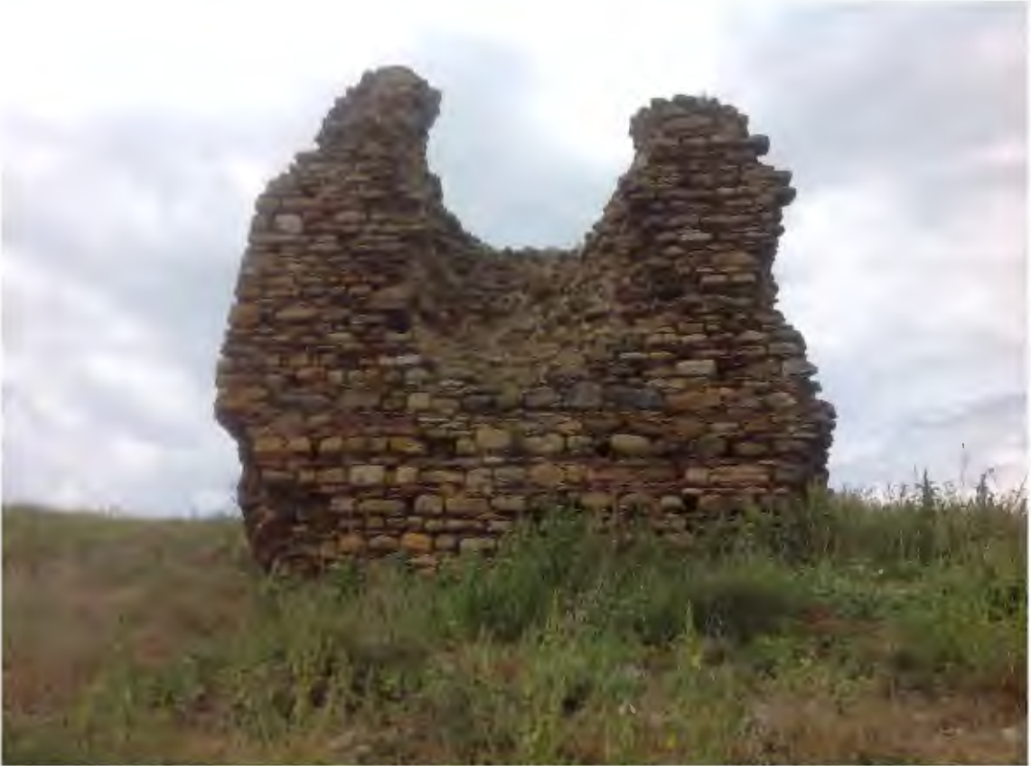
Res. 226. Güneydoğu burcun güney cephesi (İ.H. Kurtuluş, 2015).
