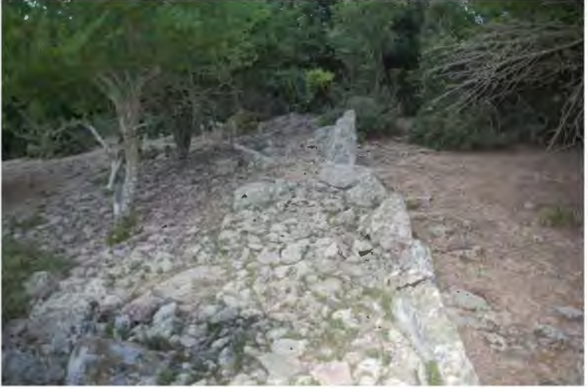
Res. 594. Üçüncü duvarın köşe mekânının 22, 40 m. devam ederek son bulan dış duvarının görünümü (İ.H. Kurtuluş, 2018).
