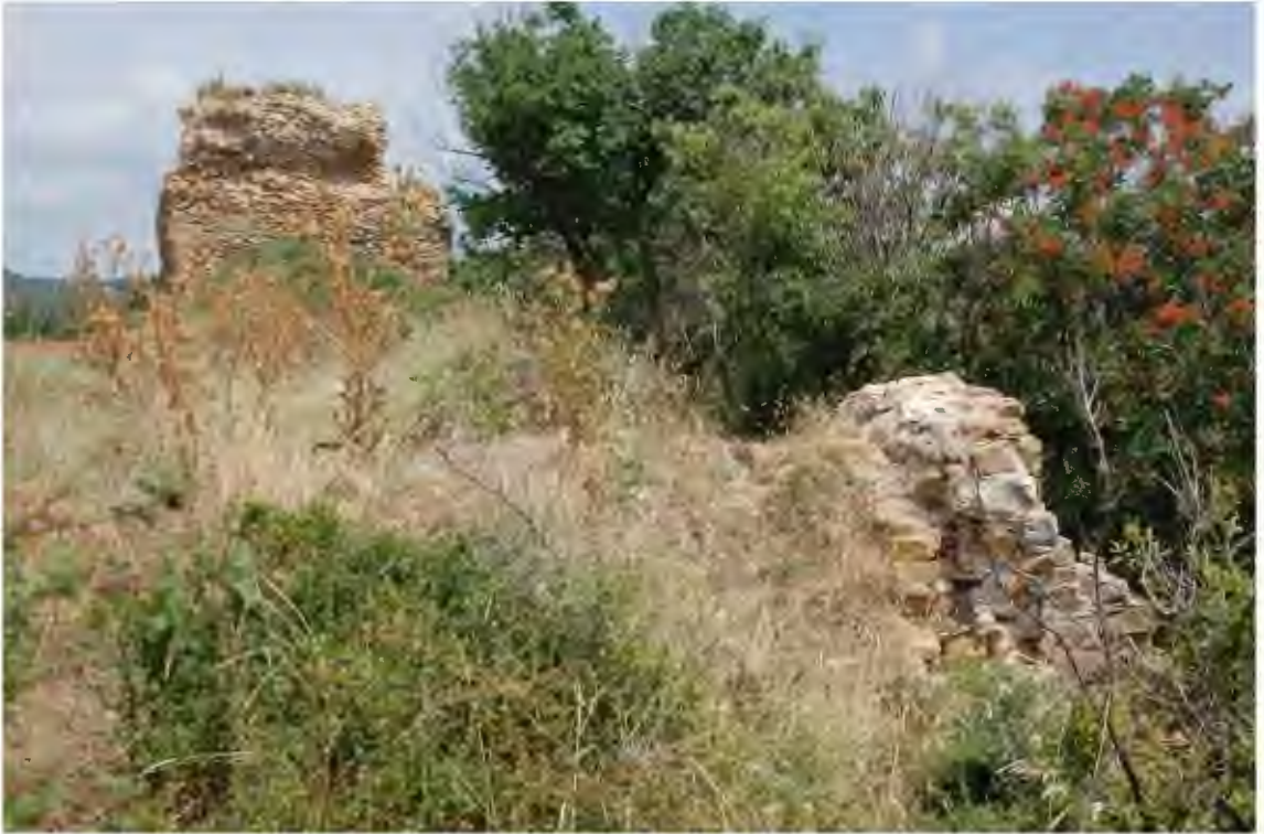
Res. 334. Gökçetepe Kalesinin doğu sur kalıntısı ve burcun görünümü (İ.H. Kurtuluş, 2018).
