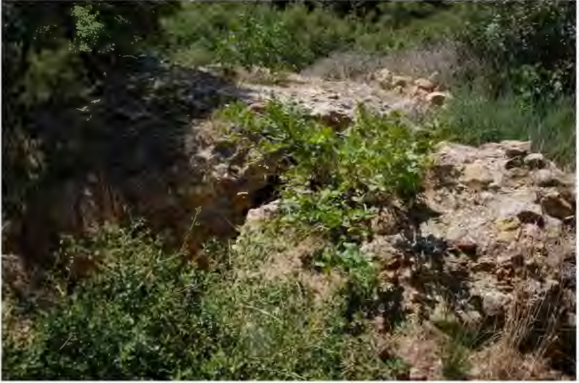
Res. 289. Moloztaş duvar örgüsüne sahip burç kalıntısının üstten görünümü (İ.H. Kurtuluş, 2018).
