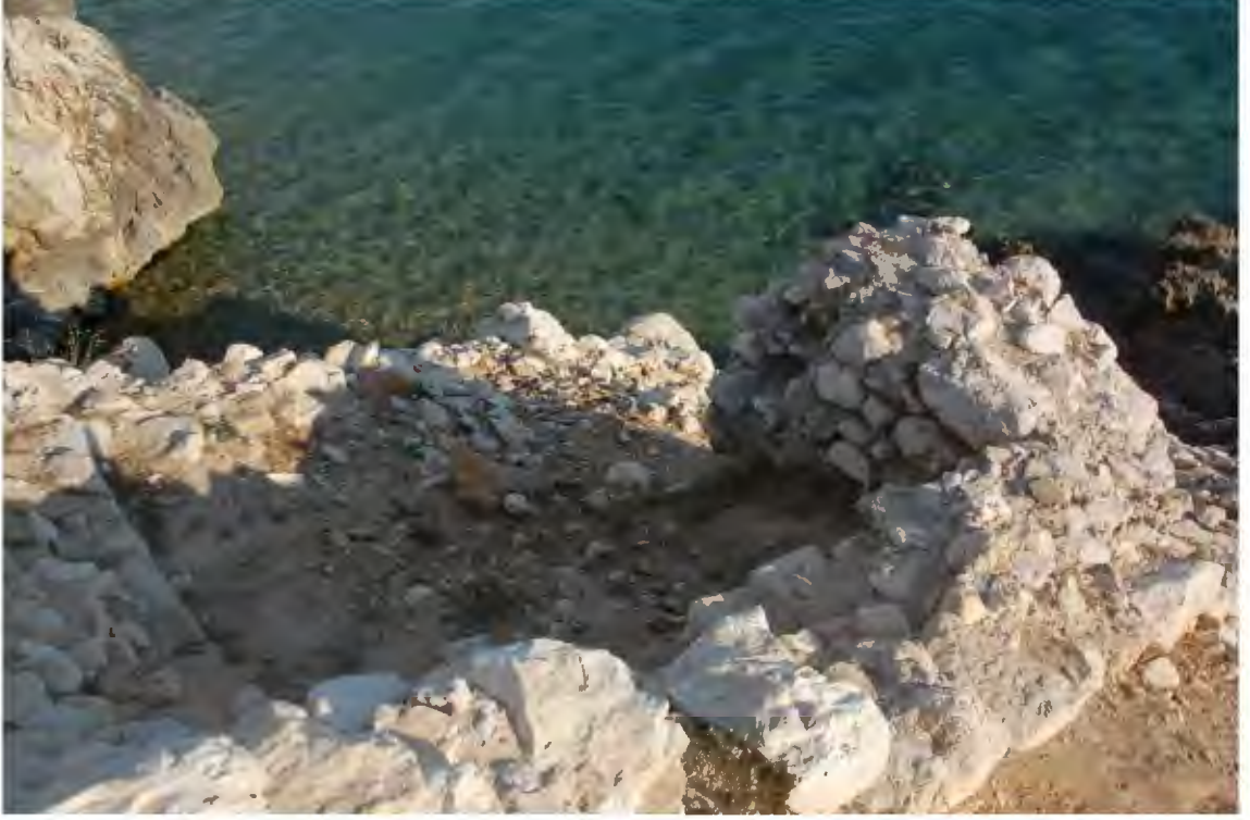
Res. 401. Kalenin güneydoğu burcunun üstten genel görünümü (İ.H. Kurtuluş, 2018)
