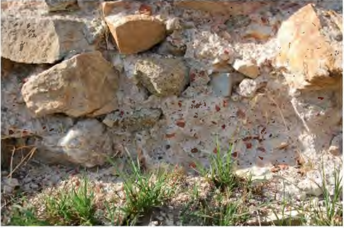
Res. 131. Taşlar arasında bağlayıcı malzeme olarak tuğla kırıklı güçlü harç kullanılmıştır (İ.H. Kurtuluş, 2018).
