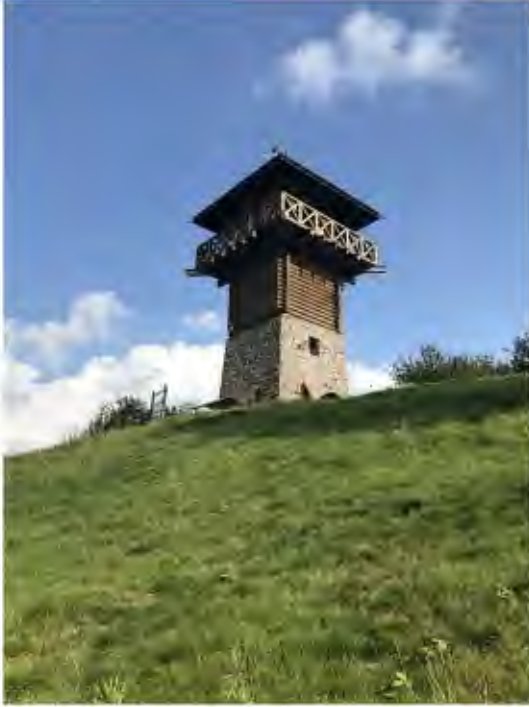
Res. 508. Almanya, Bayern Bölgesinde, Arzbach kasabasında, Limes üzerindeki Roma gözlem kulesi. Taş temel üzerinde yapılan ahşap bölümle kule yukarı yönde uzatılmış. En üstte dört yönünü çevreleyen ahşap yürüme bandı ve çatı eklenmiş. ( https://www.pixabay.com/de/photos/römer-römerturm.limes-arzbach-3834987/ ).
