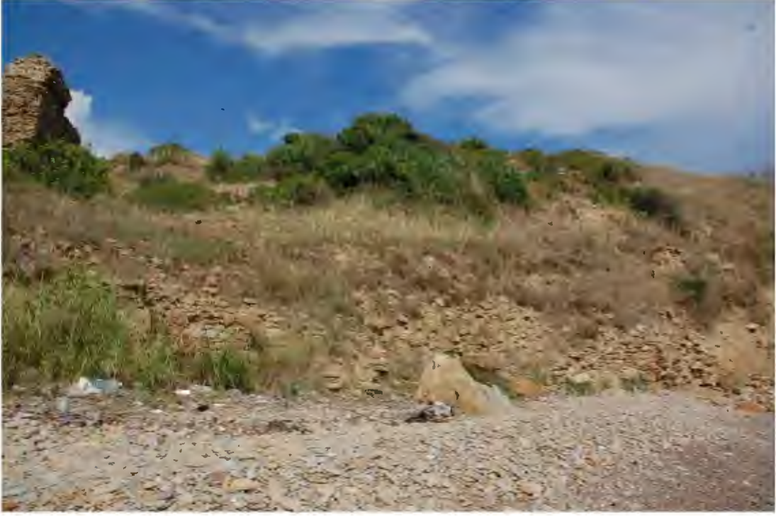
Res. 344. Kalenin güneybatı cephesindeki sur kalıntısının genel görünümü (İ.H. Kurtuluş, 2018).
