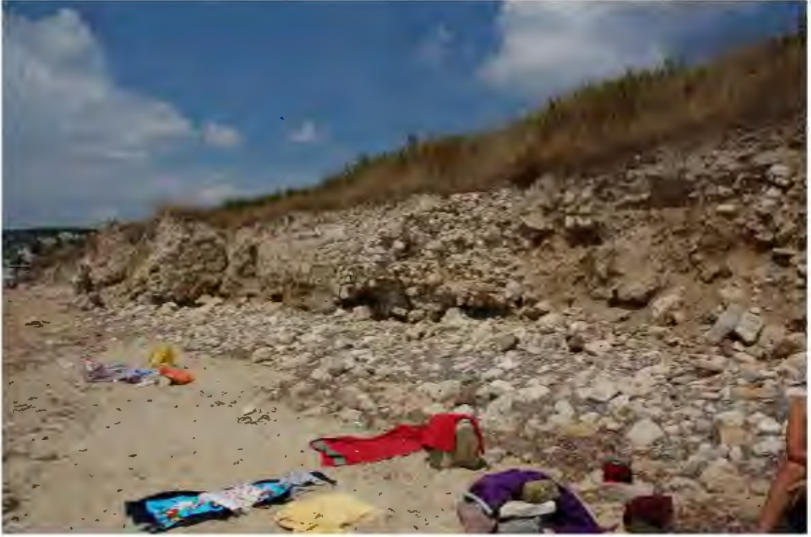
Res. 460. Güney suruna ait bazı parçaları görülebilen 60 m. uzunluğundaki duvarın genel görünümü (İ.H. Kurtuluş, 2018)
