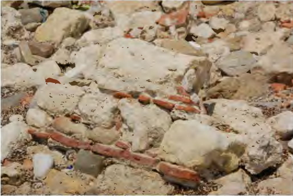
Res. 450. Yaylaköy Kalesinin güney duvarının tuğla hatıllı duvar işçiliğiyle yapılmış kalıntısı (İ.H. Kurtuluş, 2018)
