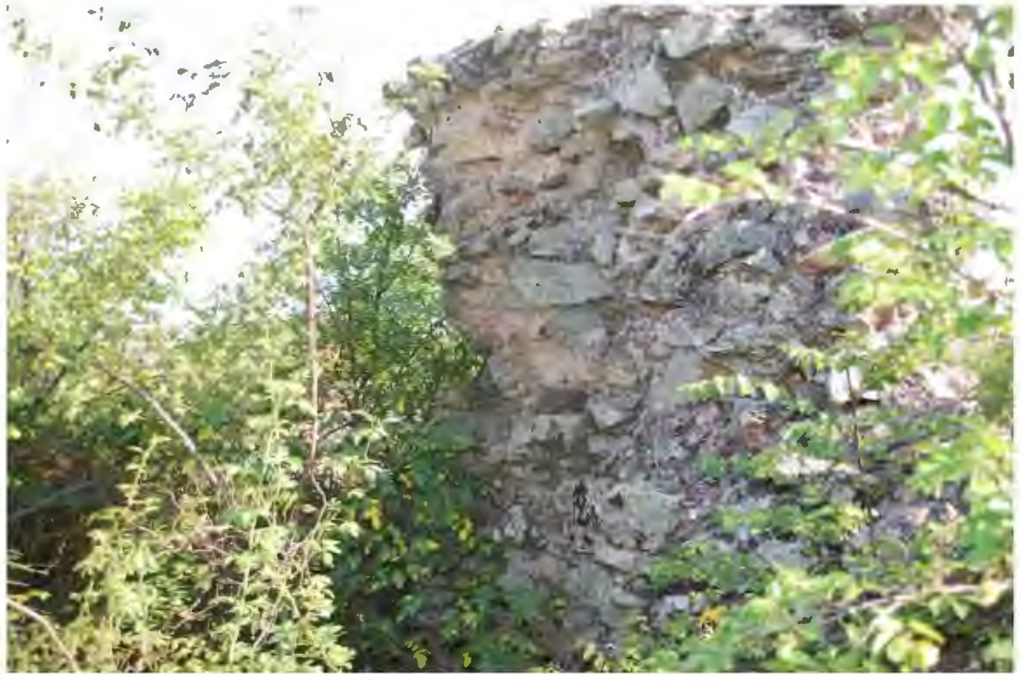
Res. 130. Duvar kalıntıları moloz taş tekniğiyle yapılmıştır (İ.H. Kurtuluş, 2018).
