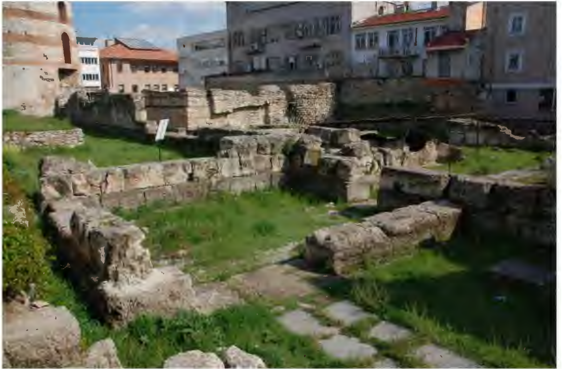
Res. 15 Kuzey surlarında yer alan Makedonya kulesinden sonraki köşeli burç (İ.H. Kurtuluş, 2019).
