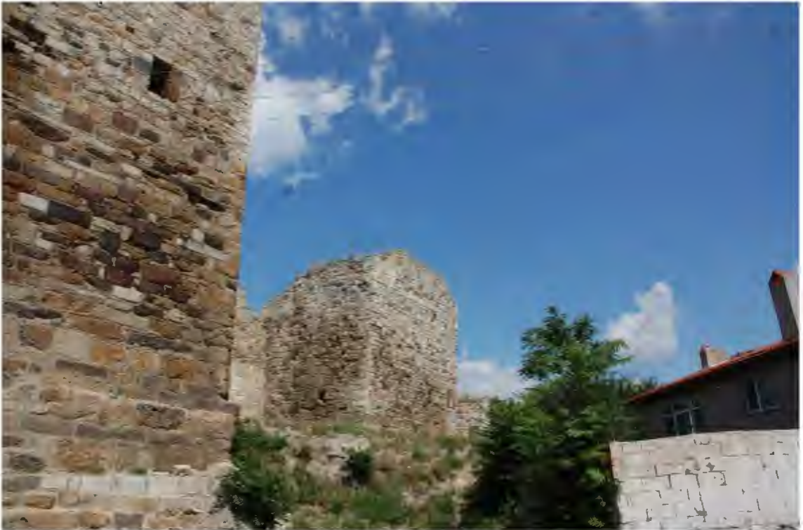
Res. 533. Enez Kalesinin doğu cephesinin dıştan görünümü (İ.H. Kurtuluş, 2018).
