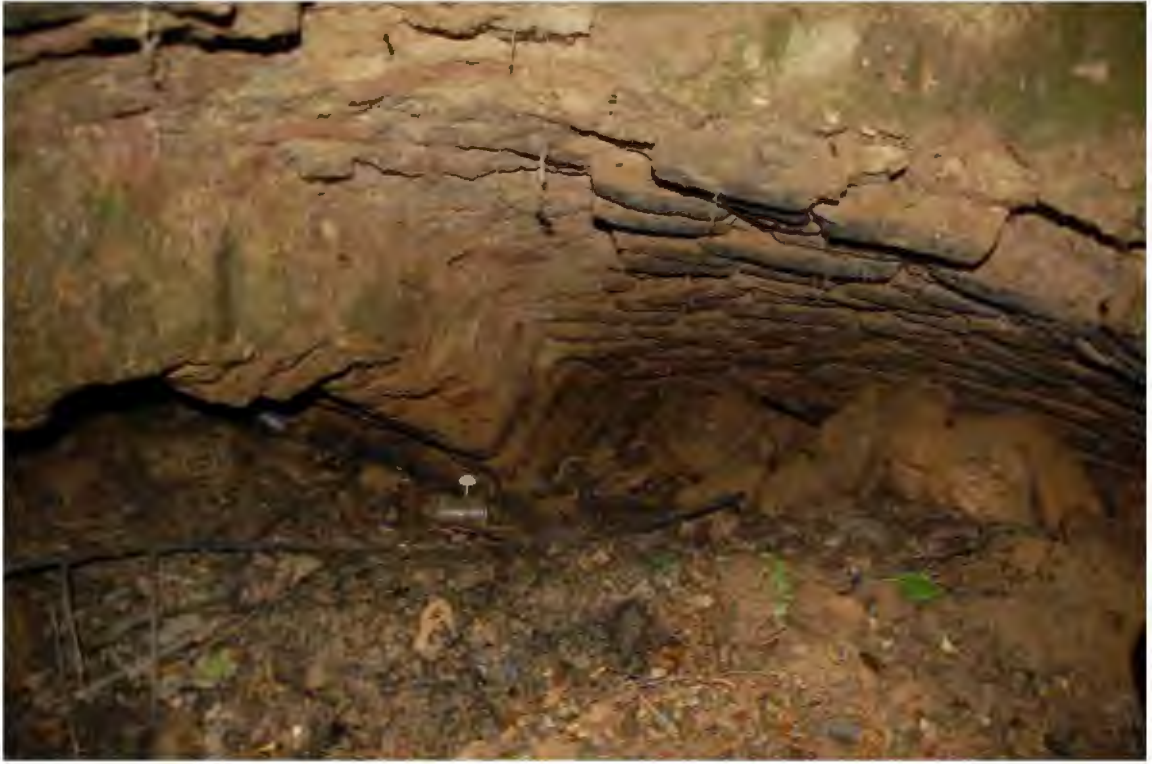
Res. 273. Güney duvarında tuğla malzeme ile yapılan tonoz (İ.H. Kurtuluş, 2018).
