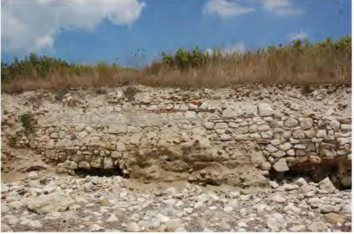
Res. 462. Burcun dođu bitiřiđinde bulunan beden duvarı (İ.H. Kurtuluř, 2018)
