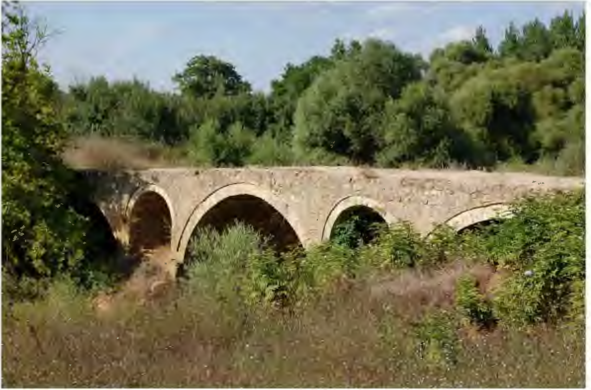
Res. 668. Mercan köyü yakınında bulunan çok gözlü köprü (İ.H. Kurtuluş, 2018).
