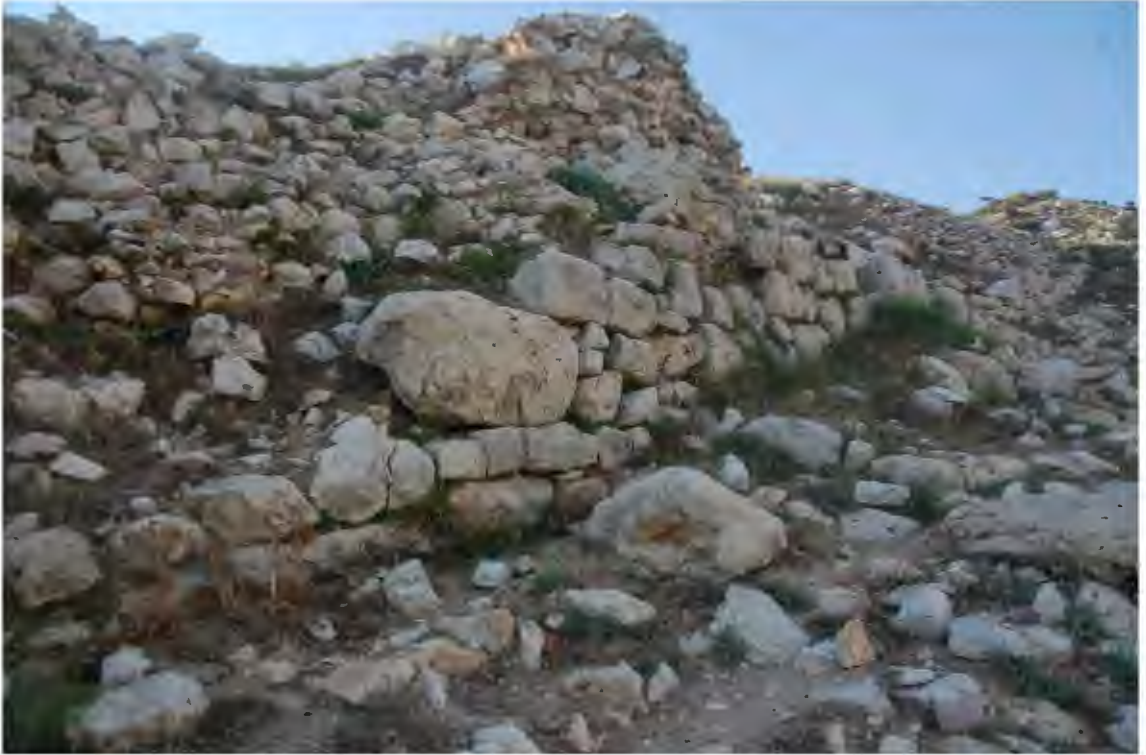
Res. 406. Dođu surunun duvar yapısından detay görünüm (İ.H. Kurtuluş, 2018)
