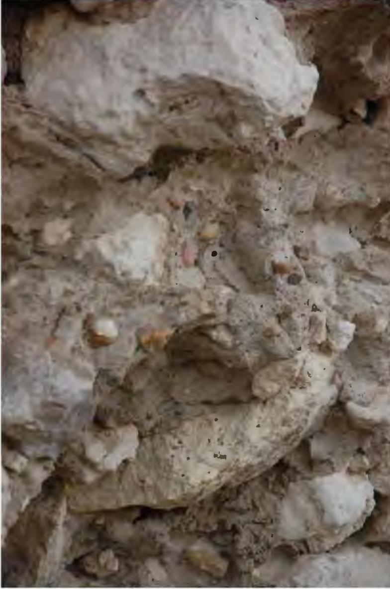
Res. 165. Sinanköy Kalesinin güney duvarında kullanılan taşlar ve harç (İ.H. Kurtuluş, 2018).
