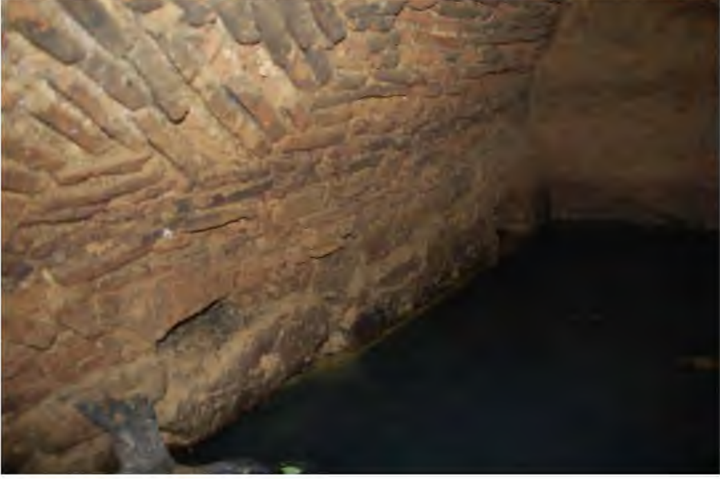
Res. 270. Dörtgen mekânın alt kısımlarında blok taşlar kullanılmıştır (İ.H. Kurtuluş, 2018).
