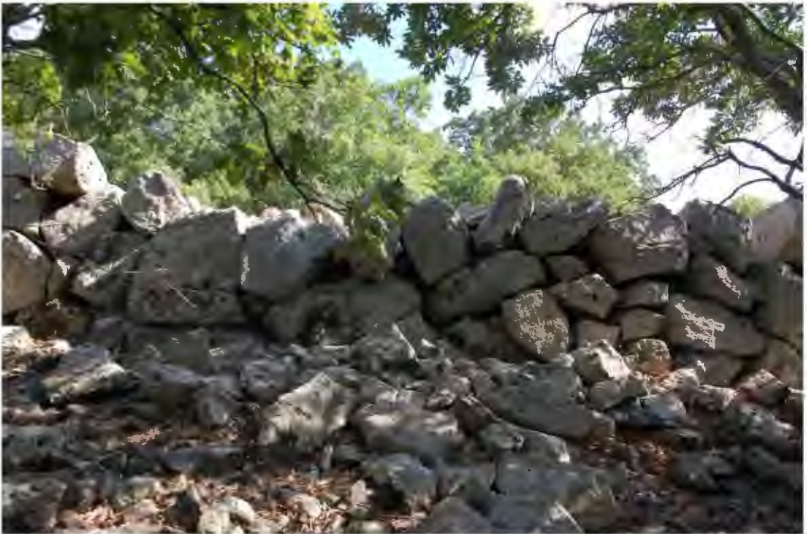
Res. 638. Dairesel tahkimatlı yapının kuzeybatı bölümünün duvar örgüsünün, dış cepheden detay görünümü (İ.H. Kurtuluş, 2018)
