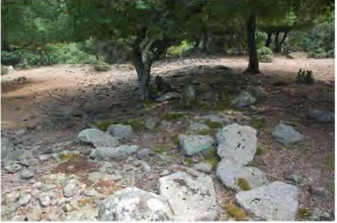
Res. 589. Üçüncü duvarın çok hasar görmüş bir bölümü (İ.H. Kurtuluş, 2018).
