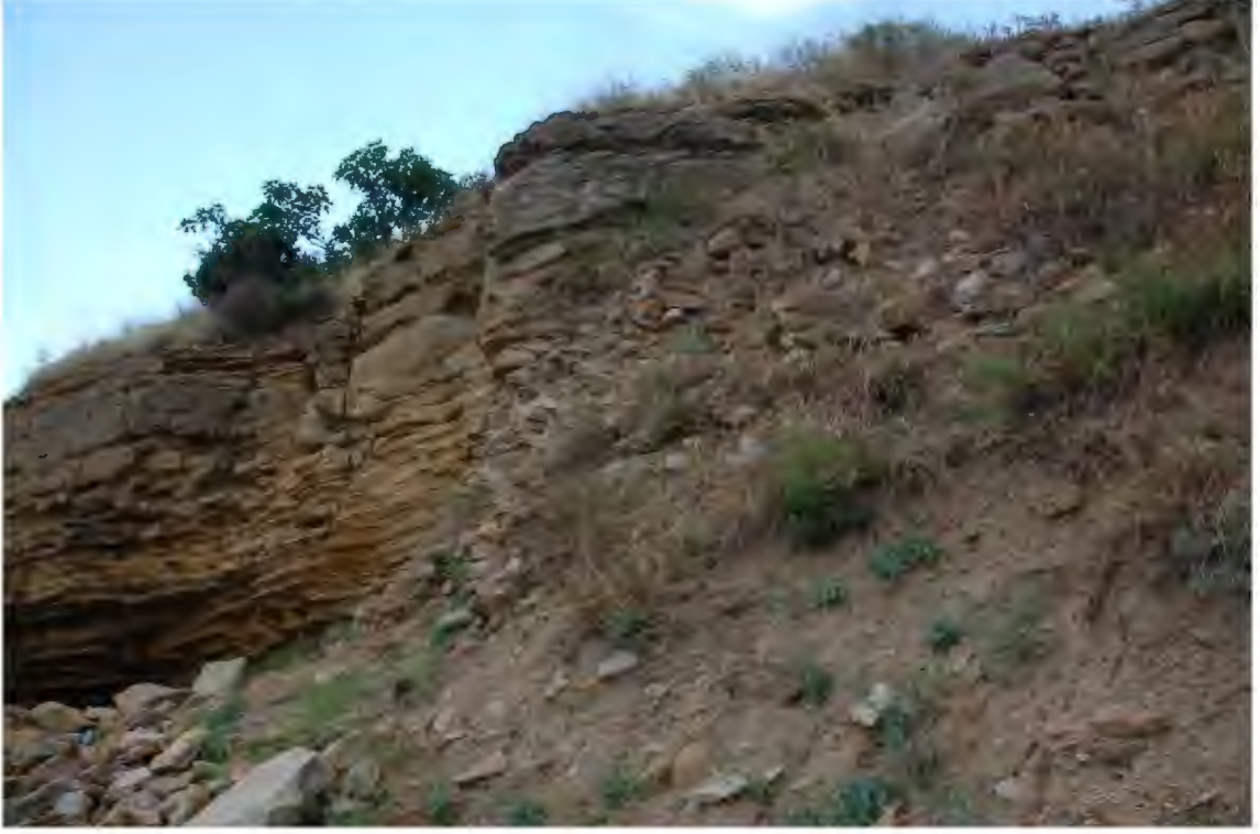
Res. 353. Gökçetepe Kalesinin güneydoğu cephesinde kayacın ön cephesini kaplayan sur izi (İ.H. Kurtuluş, 2018).
