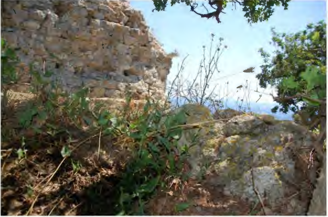
Res. 505. Karaincirli Kulenin batı tarafında bulunan harçlı duvar parçası ve arkada kulenin batı cephesinin görünümü (İ.H. Kurtuluş, 2018).
