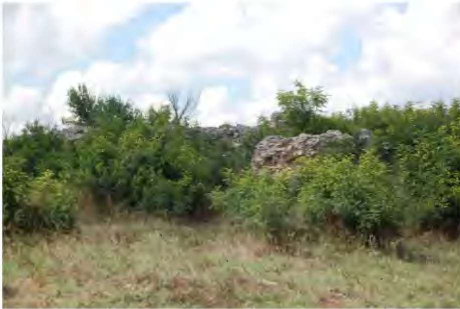
Res. 129. Dombay Kalesine ait duvar kalıntılarının güney cephesinin genel görünümü (İ.H. Kurtuluş, 2018).
