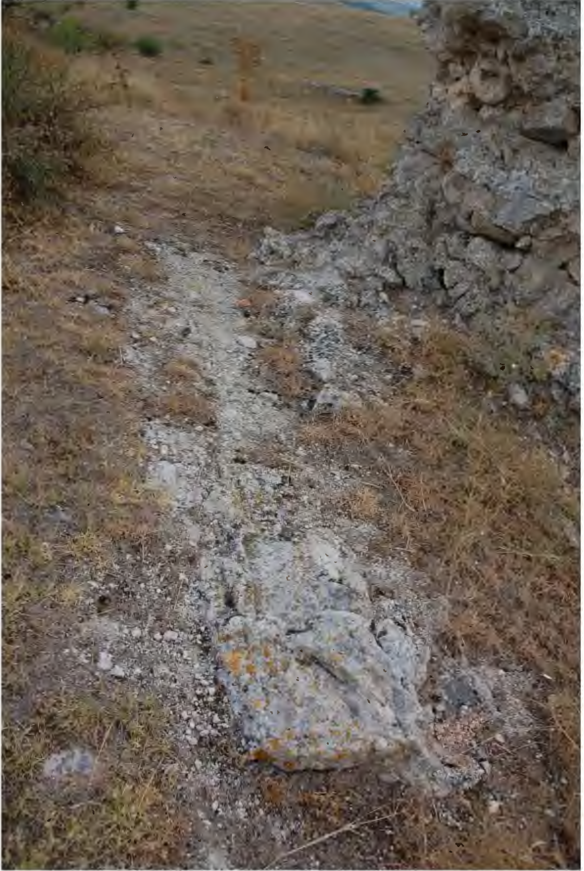
Res. 176. Güneydoğu köşede bulunan sur kalıntısının doğuya yönelik devam ettiğini gösteren izler (İ.H. Kurtuluş, 2018).
