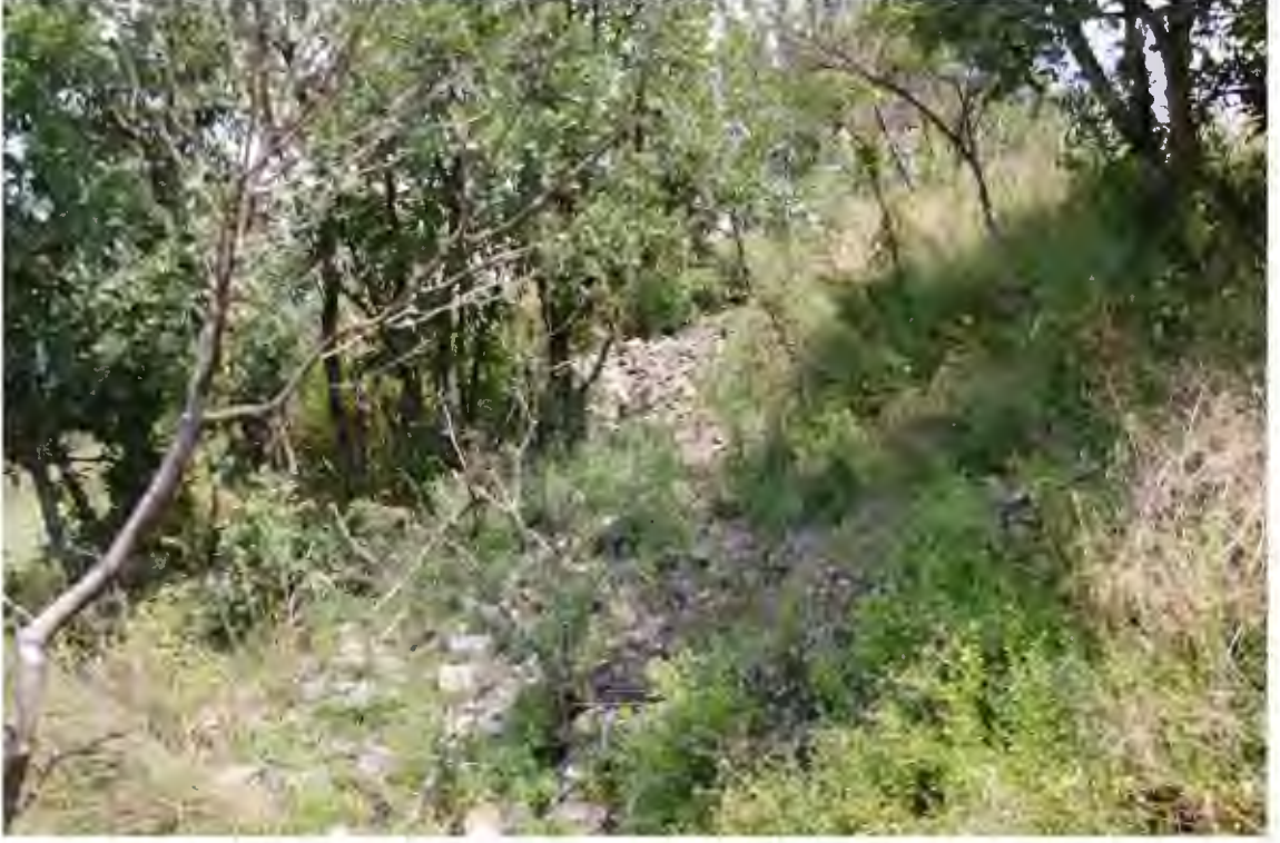
Res. 107 Kalenin kuzeybatı duvarından yıkılarak birikmiş taş kalıntıları (İ.H. Kurtuluş, 2018).
