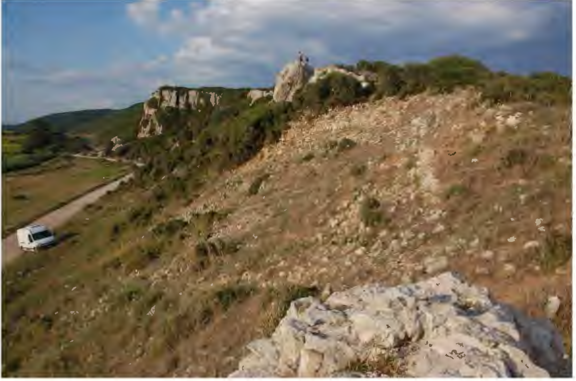
Res. 429. Güneydeki burçtan batı surunun temel seviyesinde izlenebilen kısmı (İ.H. Kurtuluş, 2018)
