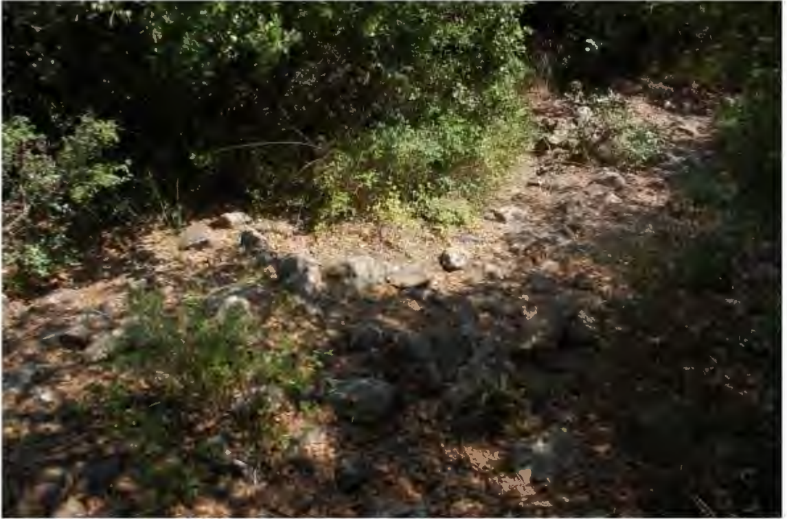
Res. 255. Çamlıca kalesinde bulunan dağılmış duvar izi (İ.H. Kurtuluş, 2018).
