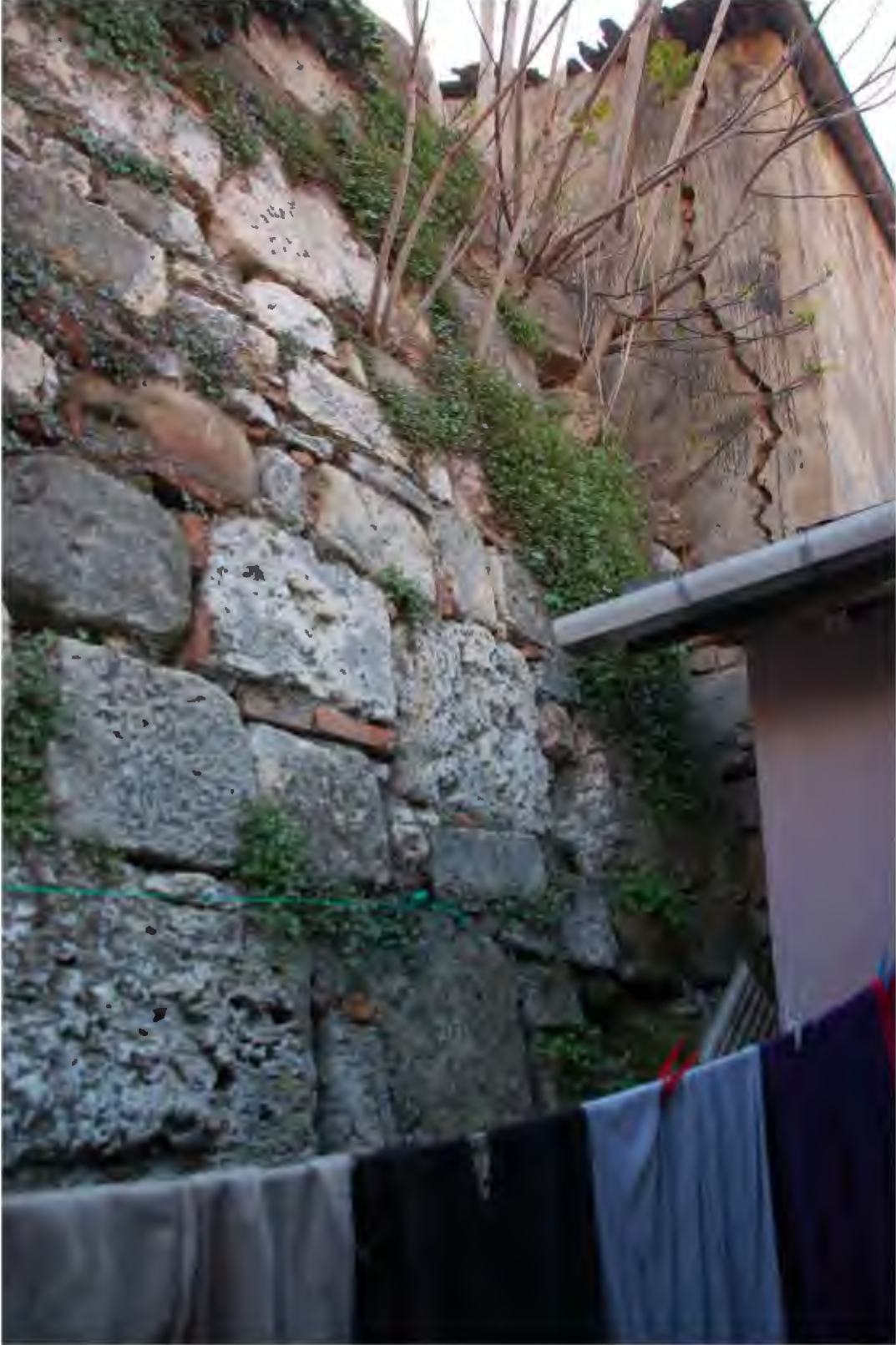
Res. 28. Evin arkasındaki surun kuzey cephesinin batı tarafındaki Bizans dönemi duvar kalıntısı (İ.H. Kurtuluş, 2019).
