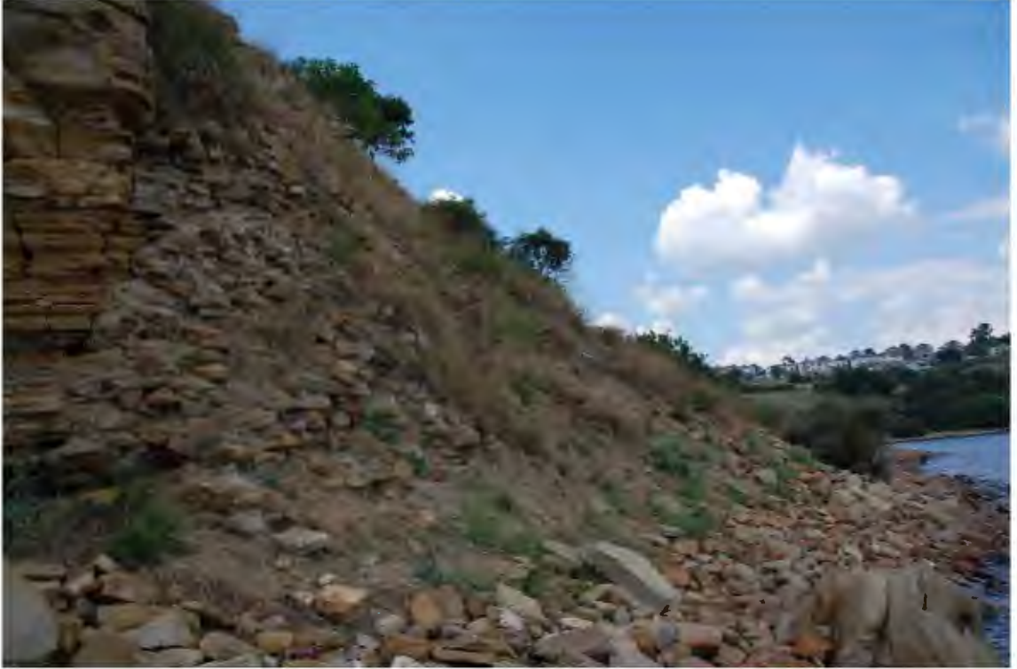
Res. 354. Gökçetepe Kalesinin güneydoğu cephesinde, kayacın cephesine örülmüş surdan kalan iz ve kuzey yönünde sahilin görünümü (İ.H. Kurtuluş, 2018).
