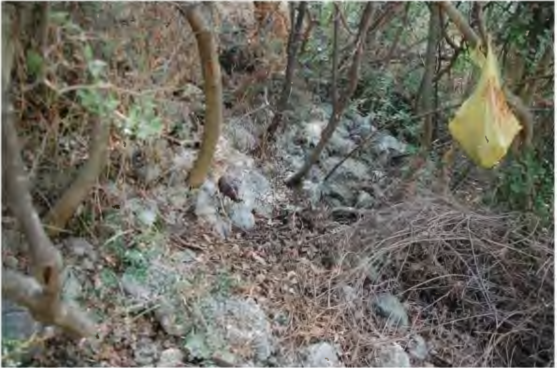
Res. 479. Kuzey suruna ait harçlı, moloztaş duvar parçası (İ.H. Kurtuluş, 2018)
