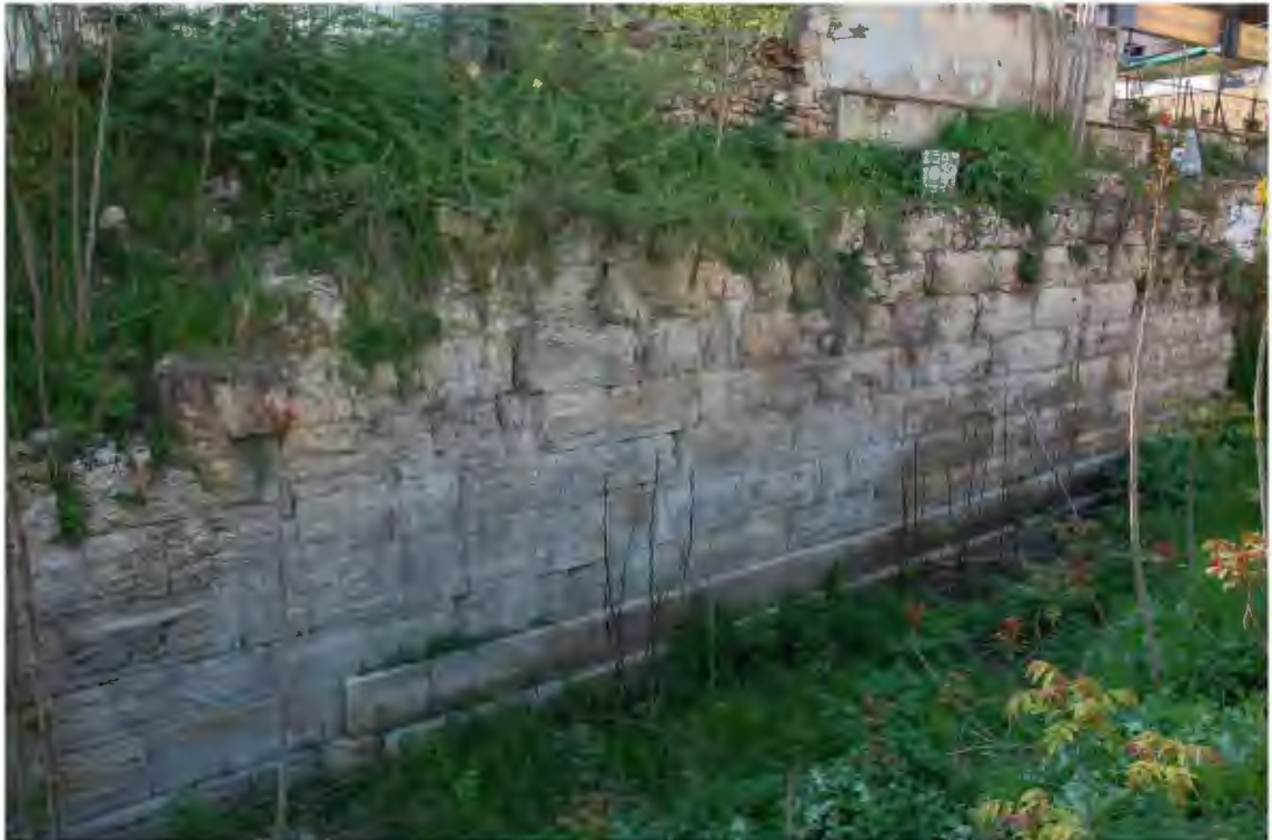
Res. 53. Surun tabanında küfeki taşı, üstte kireç taşı kullanılmış (İ.H. Kurtuluş, 2019).
