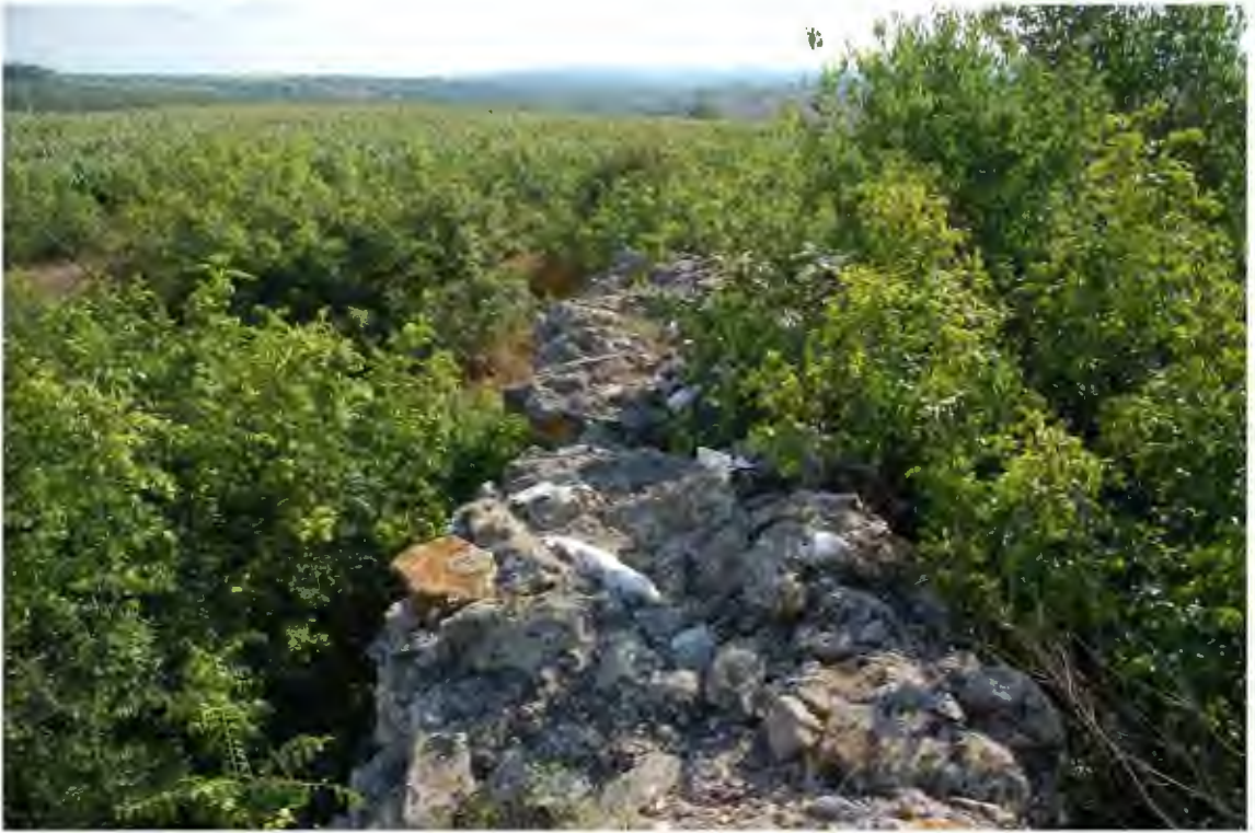
Res. 139. Köşeli U şeklindeki duvarın, burçla bağlantılı olan cephesinin üstten görünümü (İ.H. Kurtuluş, 2018).
