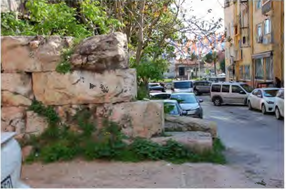
Res. 17. İki numaralı sur kalıntısı ve İstanbul caddesine açılan sokak tarafından son bulan sınırı (İ.H. Kurtuluş, 2019).
