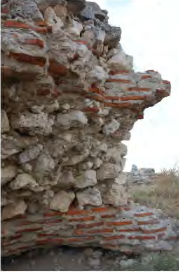
Res. 162. Güney sur kalıntısında alternatif duvar örgüsü detayı (İ.H. Kurtuluş, 2018).
