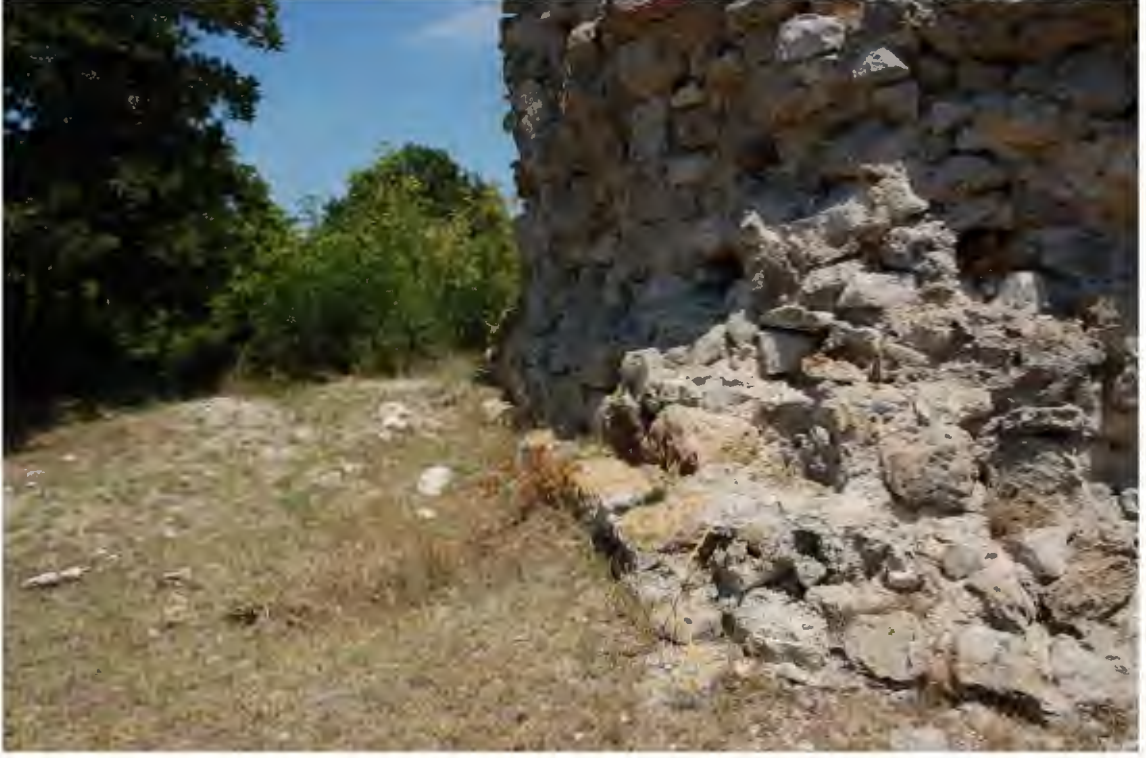
Res. 497. Karaincirli kulenin batı cephesinin güney köşesinde çıkma yapan temel yapısının güneyden görünümü (İ.H. Kurtuluş, 2018).
