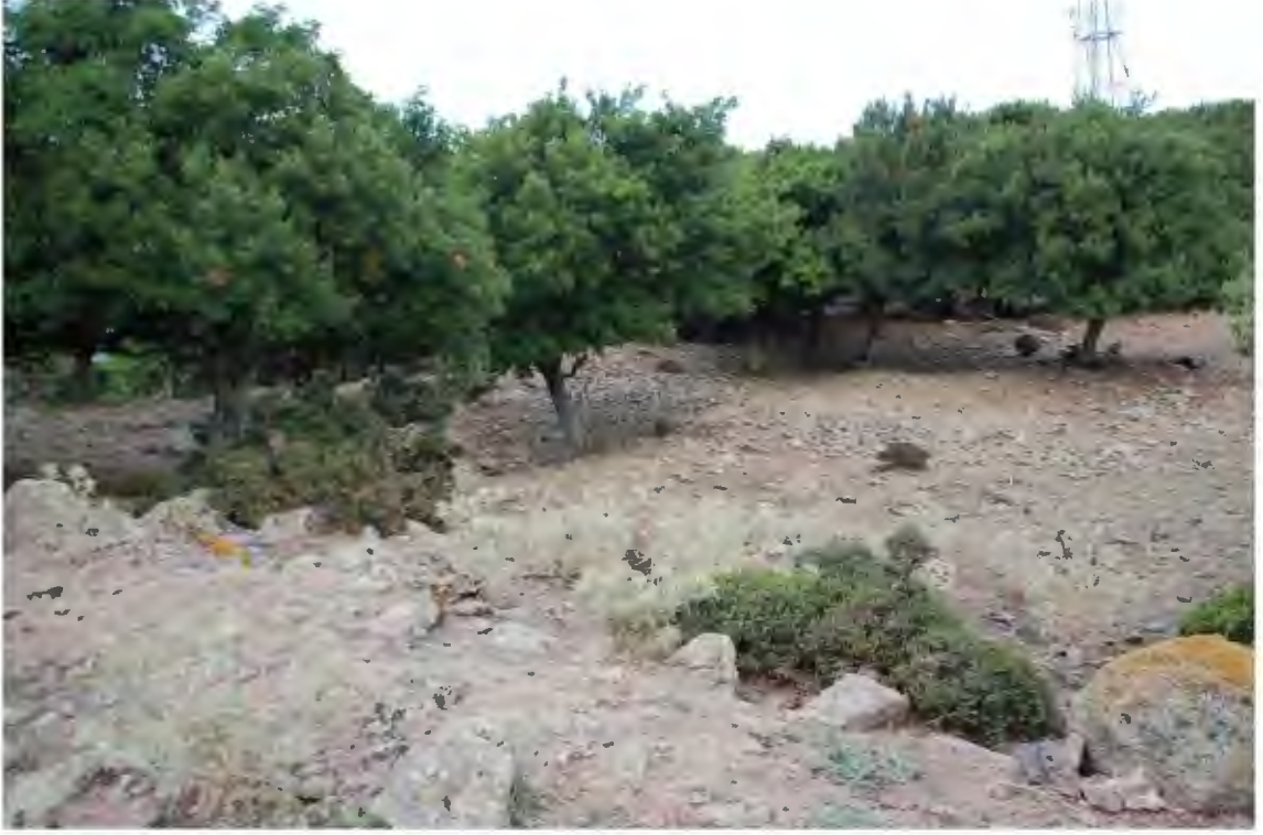
Res. 606. Hisarlıdağ Tahkimatlı alanının içinde, yıkılan duvarlardan dökülen taşların yoğun olduğu bir alan (İ.H. Kurtuluş, 2018).
