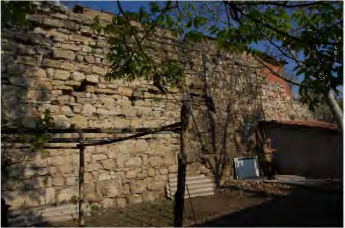
Res. 42. Bizans dönemi 5 numaralı sur kalıntısının güneydoğu cephesi (İ.H. Kurtuluş, 2019).
