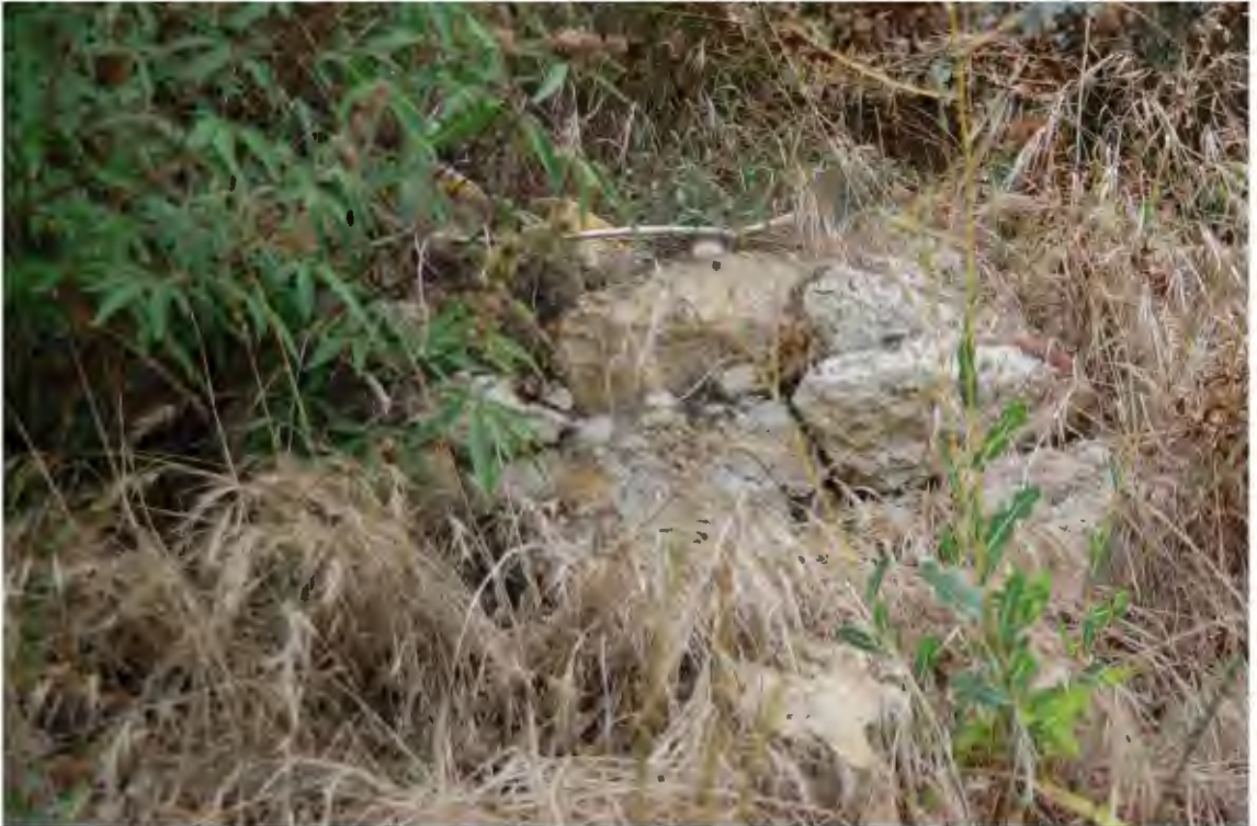
Res. 368. Kalenin dış batı cephesinde bulunan duvar kalıntısı (İ.H. Kurtuluş, 2018)
