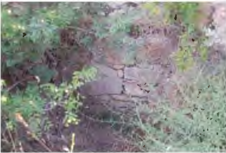
Res. 132. Kaçak kazı sonucu temel seviyesinde ortaya çıkan, farklı işçiliğe sahip duvar (İ.H. Kurtuluş, 2018).
