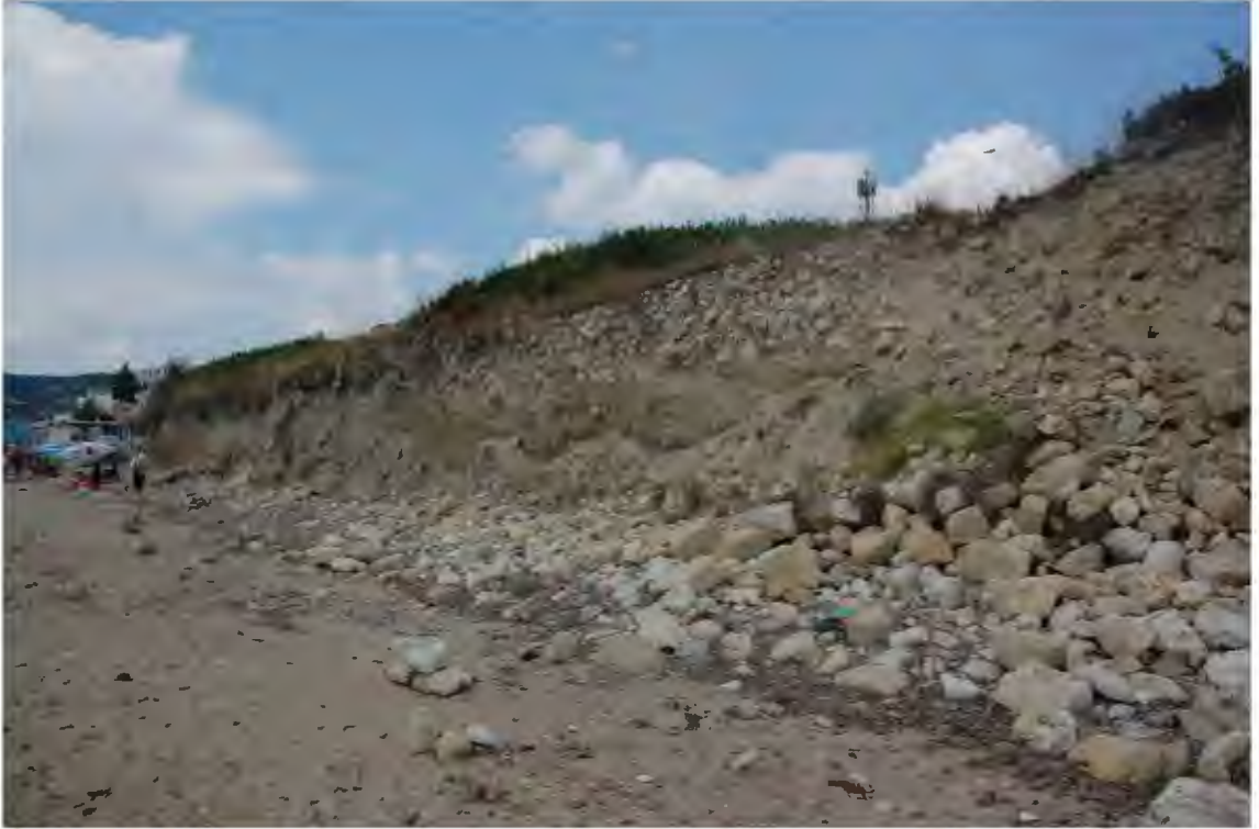
Res. 466. Kalenin güneybatı köşesine kadar uzanan duvar kalıntısı bulunmayan bölümün genel görünümü (İ.H. Kurtuluş, 2018)
