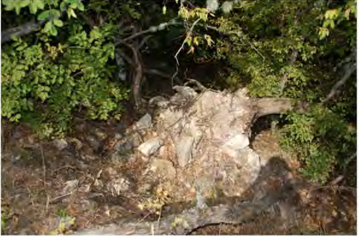
Res.70. Kuzey duvarında bulunan harçlı duvar parçası (İ.H. Kurtuluş, 2018).
