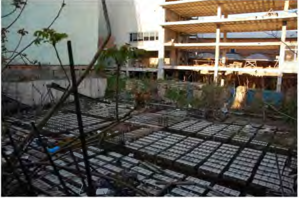
Res. 60. Talat Paşa Caddesi ile Maarif Caddesi köşesinde bulunan 8 numaralı sur kalıntısı (İ.H. Kurtuluş, 2019).
