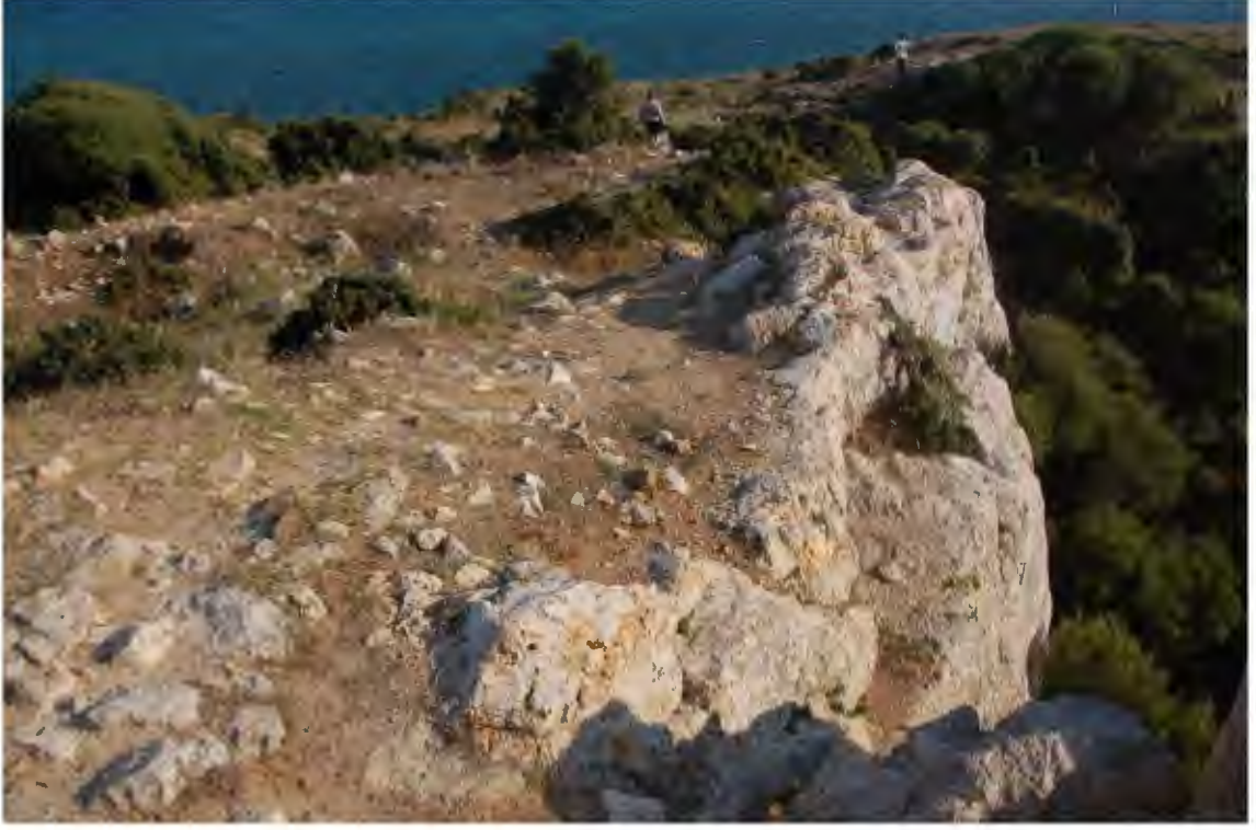
Res. 417. Mecidiye Kalesinin kuzeybatı köşesinde, kaya bloğunun üzerinde dağılmış durumdaki yapı taşları (İ.H. Kurtuluş, 2018)
