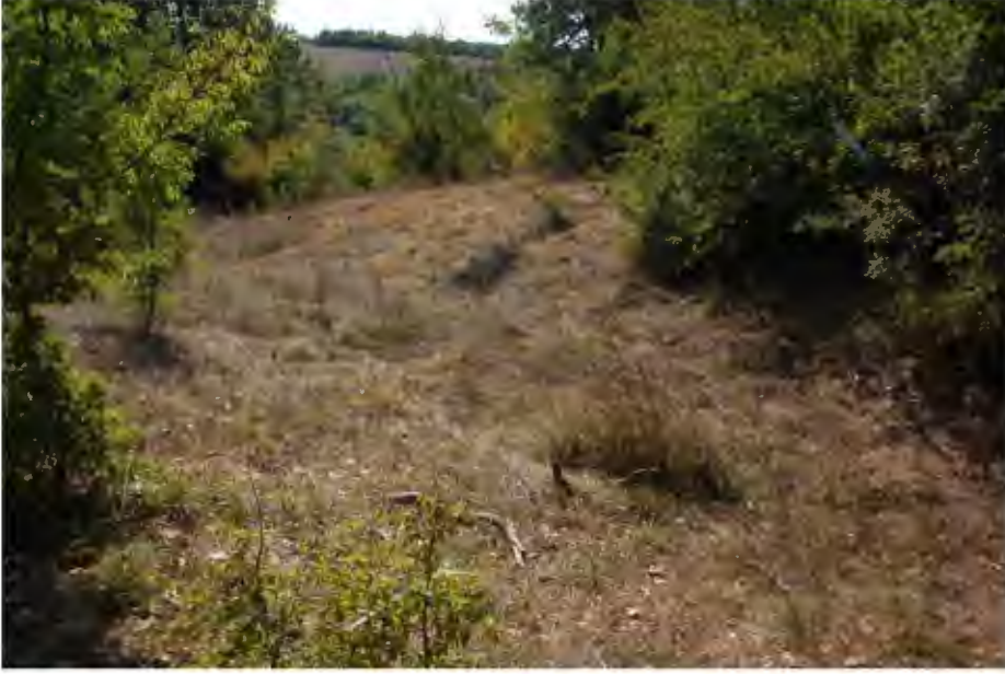
Res. 73. Yapının batı duvarı dışında bulunan yıkıntının doğudan (ana yapıdan) görünümü (İ.H. Kurtuluş, 2018).
