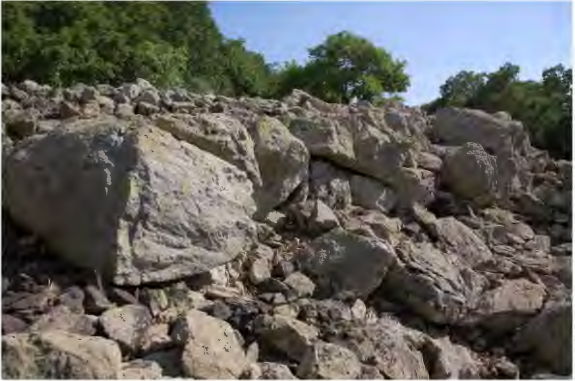
Res. 640. Dairesel tahkimatlı yapıyı oluşturan duvarın batı kısmının cepheden detay görünümü (İ.H. Kurtuluş, 2018)
