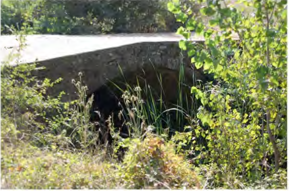
Res. 669. Mercan köyü yakınında bulunan tek gözlü köprü (İ.H. Kurtuluş, 2018).
