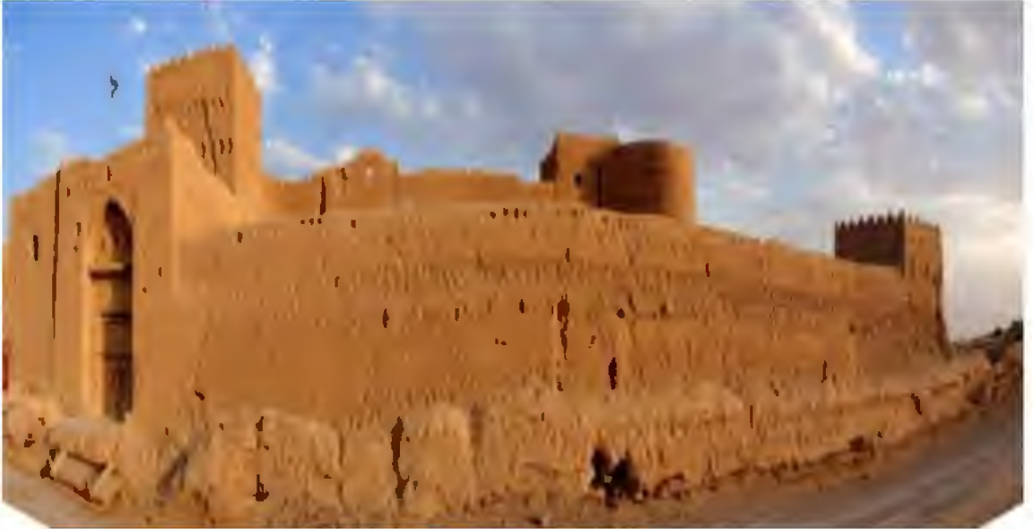
Res. 2. Saryazd Kalesi, yapım malzemesi kerpiç. Samaniler dönemine ait (Bafghi, Zad, Khalilabab, 2016: 18).
