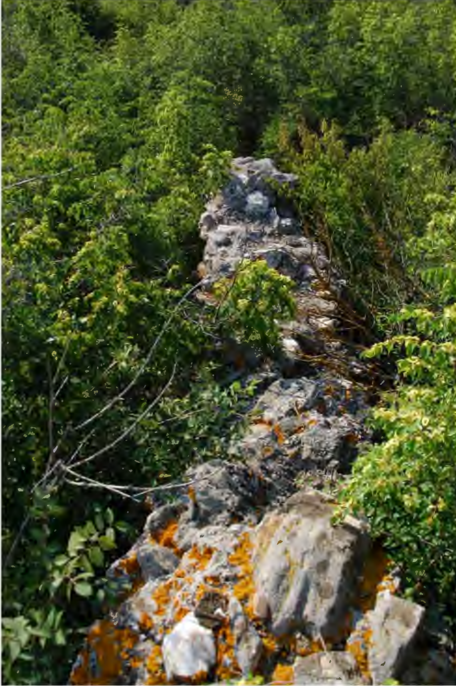
Res. 141. Köşeli U şeklindeki kalıntının sol kanat duvarının üstten görünümü (İ.H. Kurtuluş, 2018).
