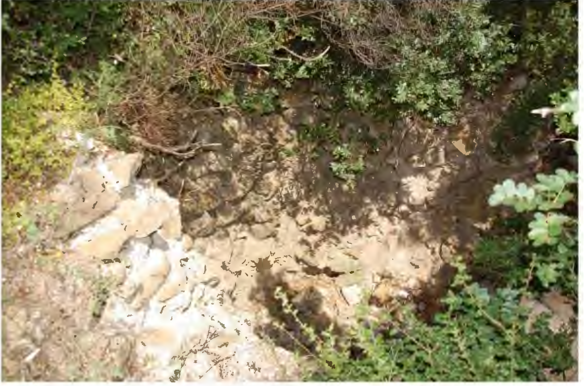
Res. 284. 3 no'lu duvarın önünde tahribata uğramış yapı kalıntıları (İ.H. Kurtuluş, 2018).
