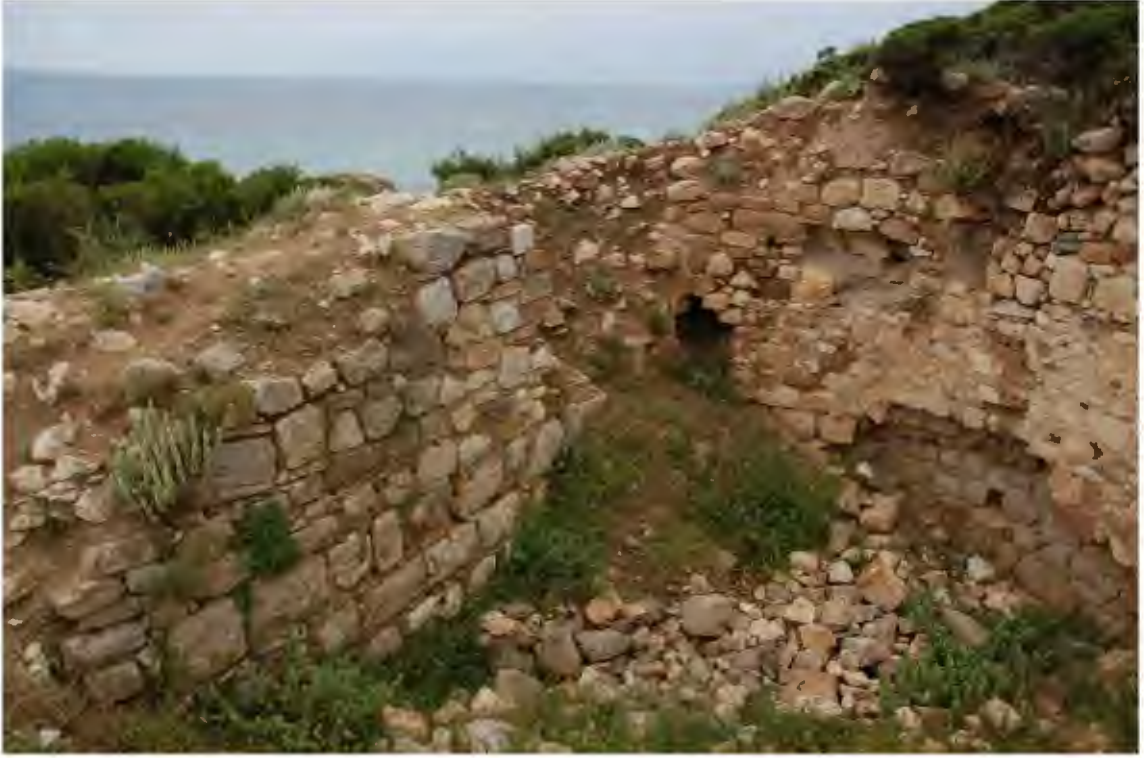
Res. 413. Burcun güney duvarının iç kısmında, düzgün taşlarla kaplanmış duvar cephesi (İ.H. Kurtuluş, 2019)
