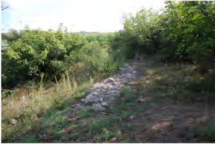
Res. 136. Burcun güneyinde bulunan temel seviyesindeki duvarın, burca doğru görünümü (İ.H. Kurtuluş, 2018).
