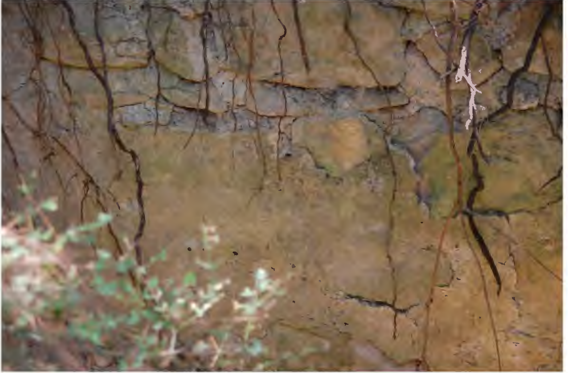
Res. 280. Kalıntının dikdörtgen bölümünde sıva kalıntıları bulunan duvardan detay görünüm (İ.H. Kurtuluş, 2018).
