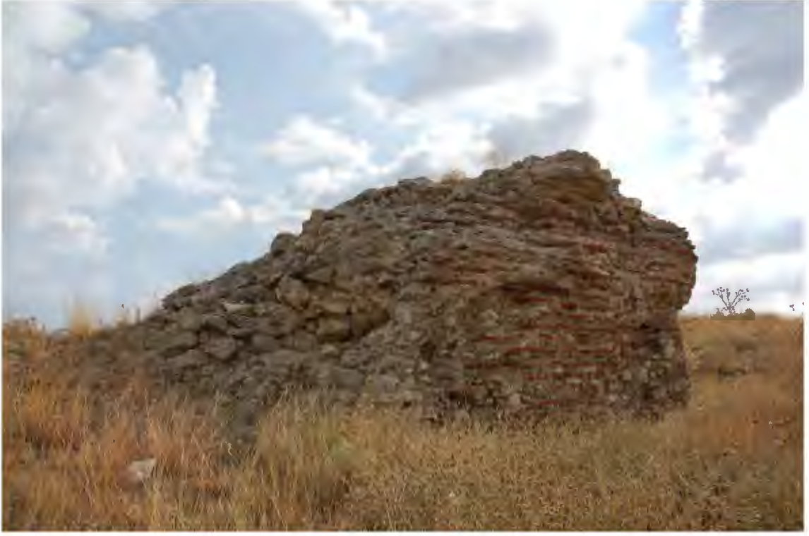
Res. 209. Batı surunun altıncı duvar kalıntısının tuğla örgülü batı cephesi (İ.H. Kurtuluş, 2018).
