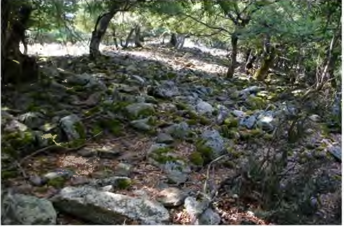
Res. 558. Hisarlıdağ Tahkimatlı alanının 1 no'lu duvarında yıkılmış duvara ait taşların iki yana akarak biriktiği bir bölüm (İ.H.Kurtuluş, 2018).
