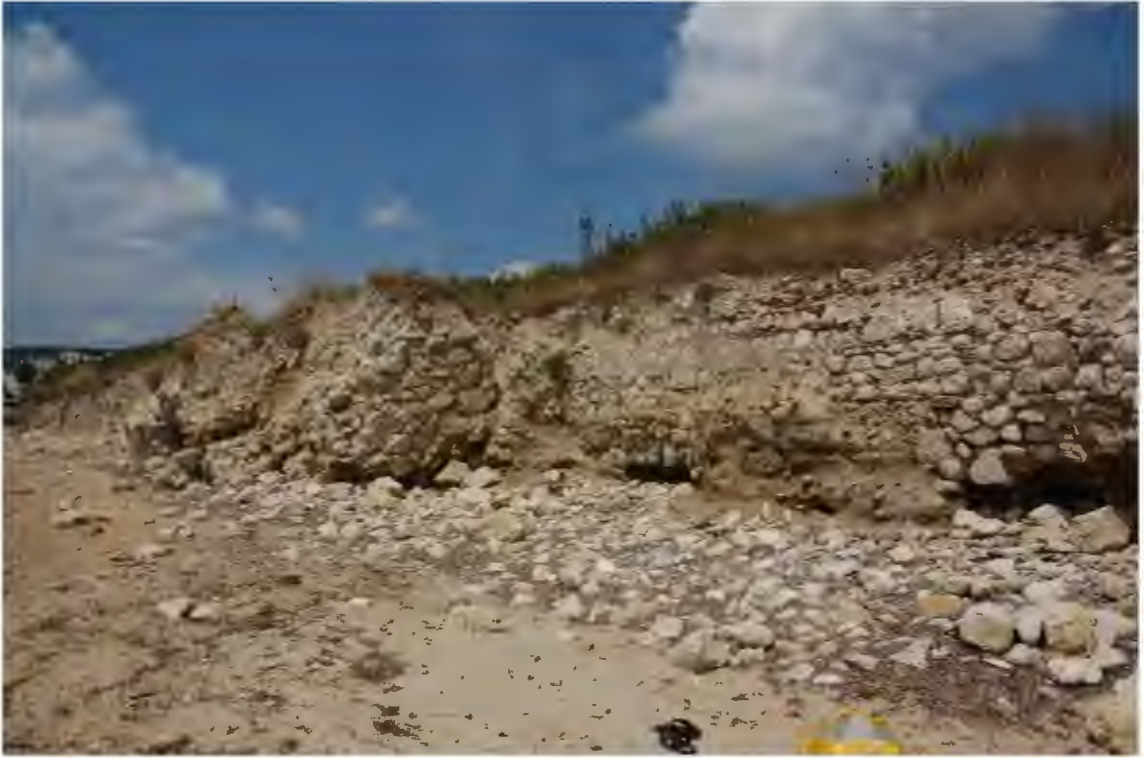
Res. 461. Güney cephede burç kalıntısı ve doğusundaki beden duvarı (İ.H. Kurtuluş, 2018)
