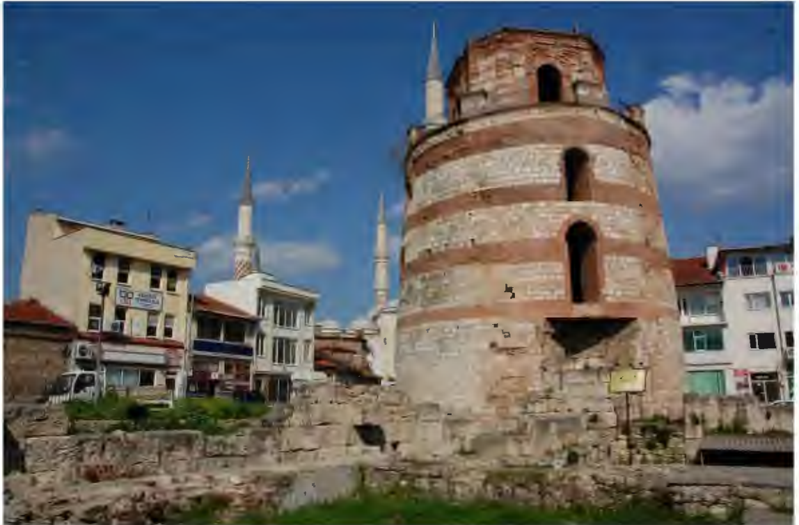
Res. 10. Makedonya kulesi ve üzerinde saat kulesinin zemin kat kalıntısı. Sol: Roma dönemi kuzey sur kalıntısı, Sağ: Roma dönemi doğu sur kalıntısı (İ.H. Kurtuluş, 2019).
