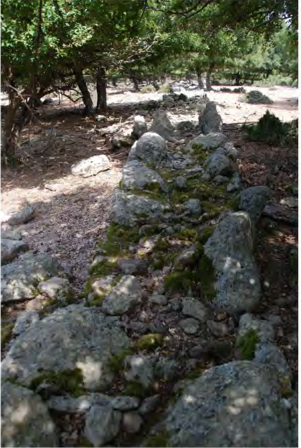
Res. 586. Üçüncü duvar da uygulanan kuru taş tekniği (İ.H. Kurtuluş, 2018).
