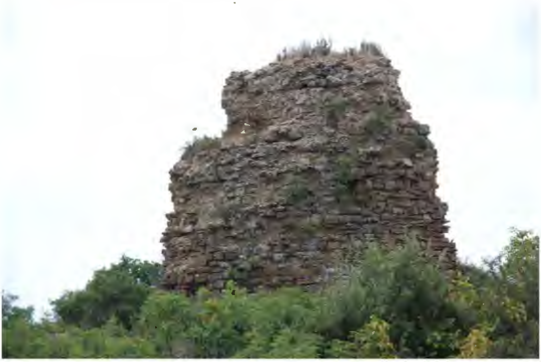
Res. 326. Burcun kuzey cephesinin genel görünümü (İ.H. Kurtuluş, 2018).
