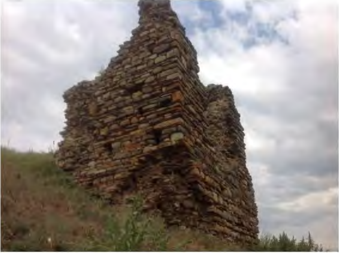
Res. 225. Güneydoğu burcun batı ve güney cephesi (İ.H. Kurtuluş, 2015).
