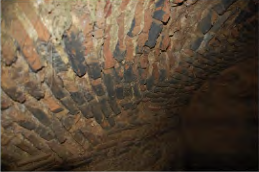
Res. 271. Dörtgen mekânın kemer ve tonoz üst örtü sisteminde tuğla kullanılmıştır (İ.H. Kurtuluş, 2018).
