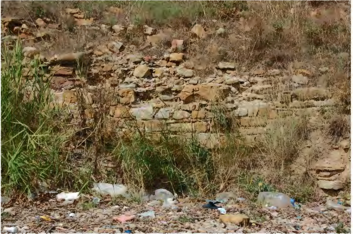
Res. 345. Kalenin güneybatı sur kalıntısının yakın görünümü (İ.H. Kurtuluş, 2018).
