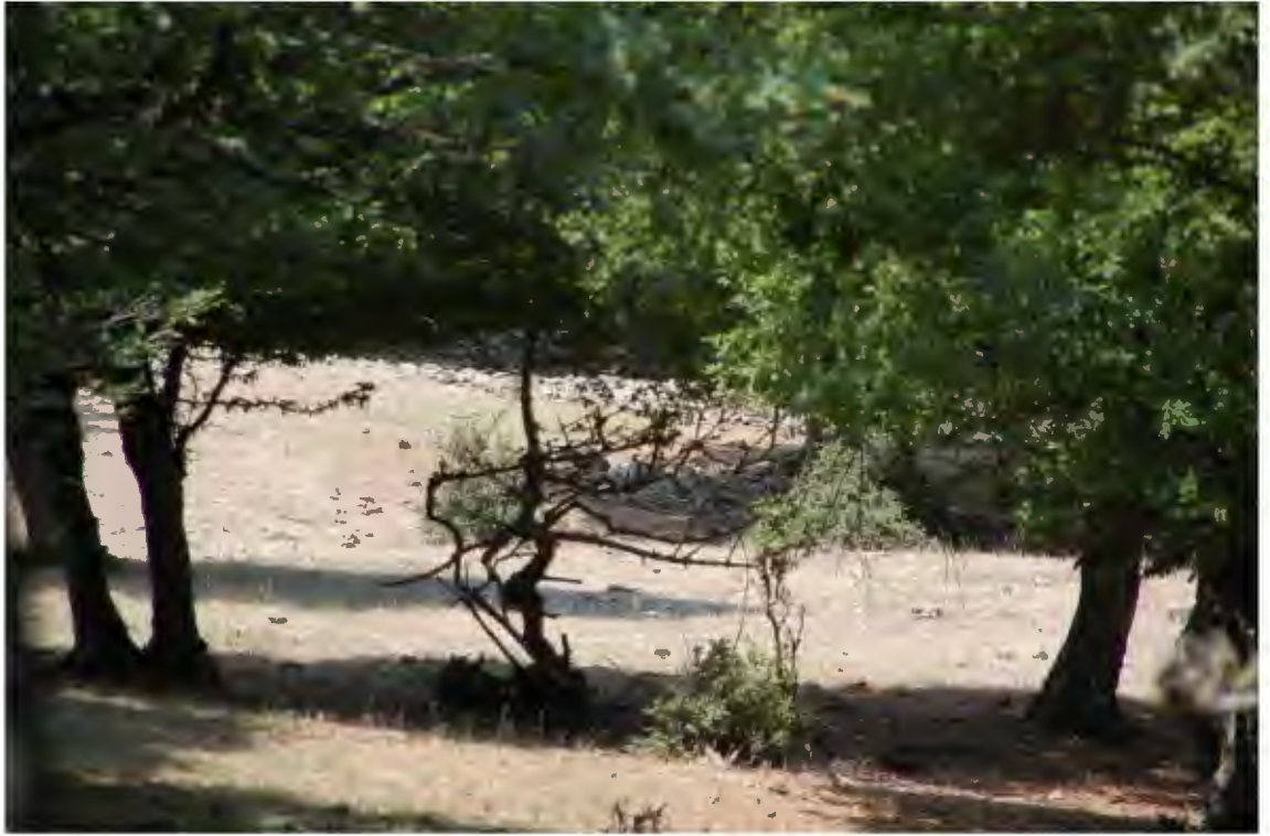
Res. 570. İkinci duvardan, yıkılmış kulenin görünümü (İ.H. Kurtuluş, 2018).
