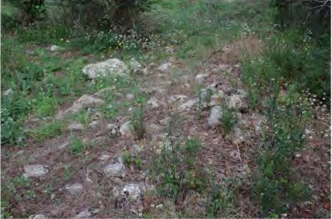
Res. 97. Kuzeydoğu duvarının, iki yana doğru yıkılmış kısmının görünümü (İ.H. Kurtuluş, 2018).
