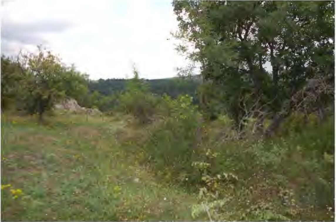
Res. 92. Ömeroba Kalesinin doğu duvarının kaya kütlesiyle birleştiği yer (İ.H. Kurtuluş, 2018).
