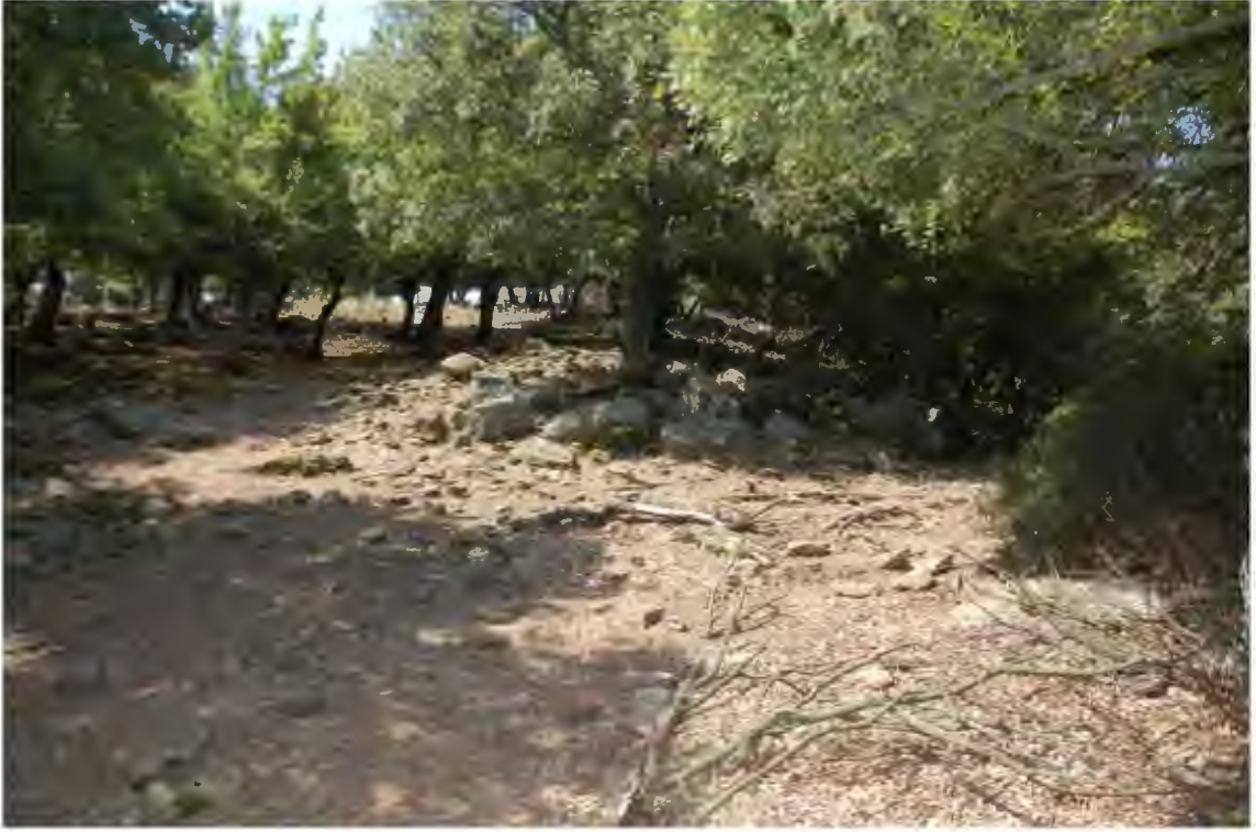
Res. 560. Hisarlıdağ Tahkimatlı alanının 1 no'lu duvarının orta bölümüne yakın bir yerde iş makinasıyla yıkılan kısım (İ.H.Kurtuluş, 2018).
