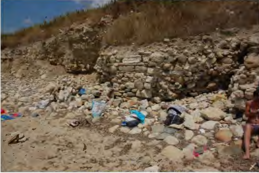
Res. 449. Yaylaköy Kalesinin moloztaş duvarların cepheleri daha düzgün kesilmiş taşlarla kaplanmıştır (İ.H. Kurtuluş, 2018)
