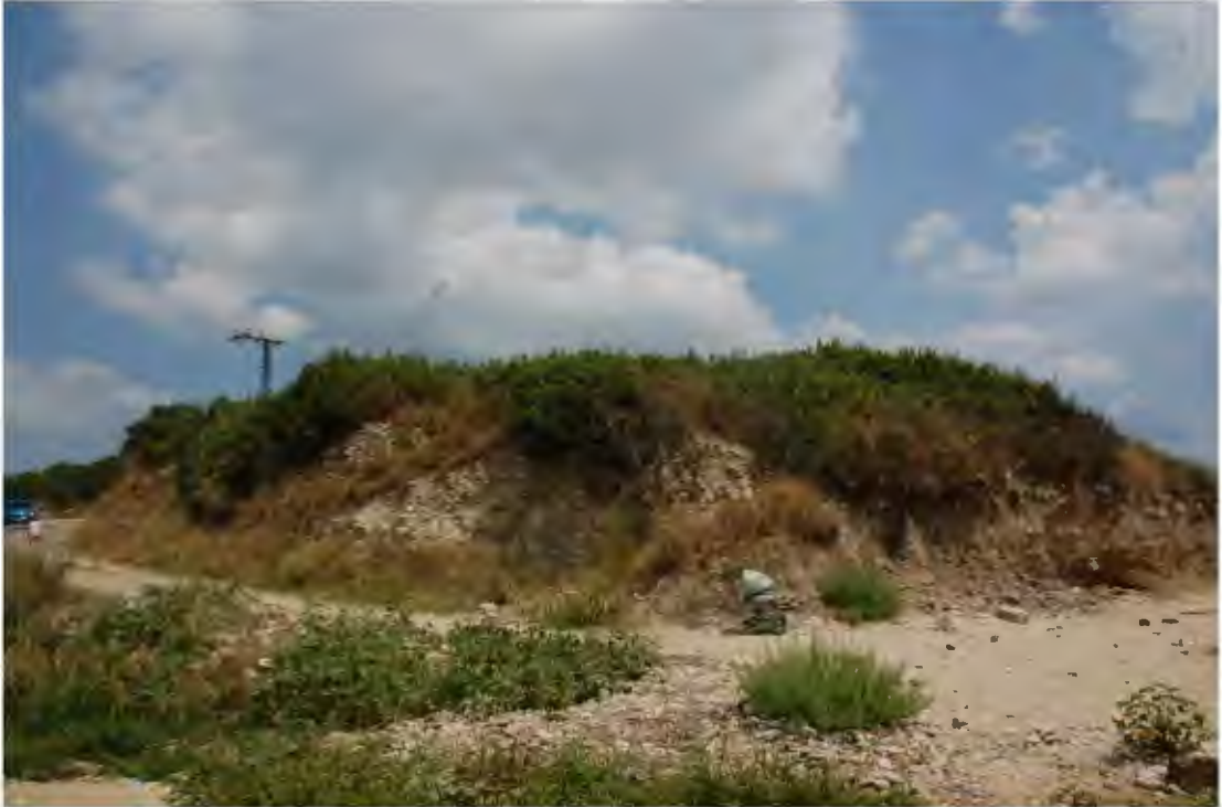
Res. 469. Güney ve batı surların birleştiği güneybatı köşenin genel görünümü (İ.H. Kurtuluş, 2018)
