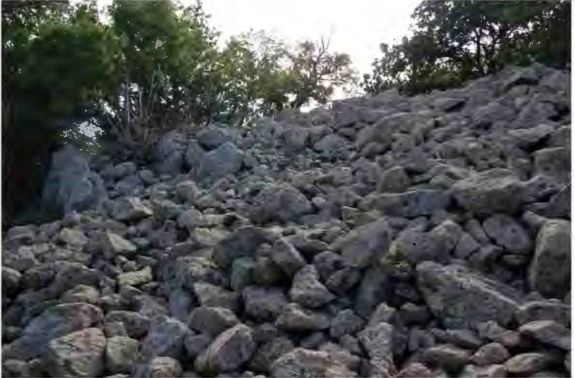
Res. 620. Dairesel tahkimatın dışındaki eğimli araziye akmış olan yapı duvarına ait taşlardan bir görünüm (İ.H. Kurtuluş, 2018)
