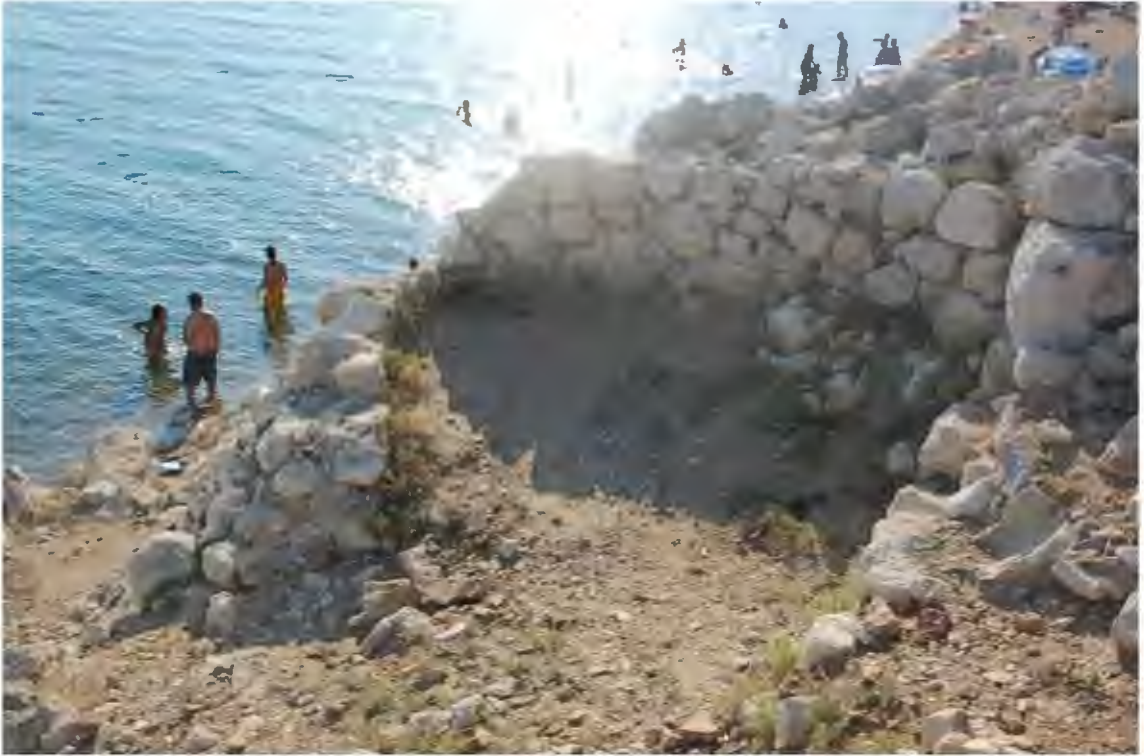
Res. 394. Mecidiye Kalesi güneybatı burcunun iç kısmının genel görünümü (İ.H. Kurtuluş, 2018)
