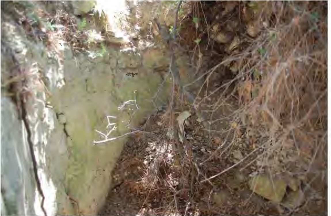
Res. 276. Yapının dairesel kısmında sıvalı duvar parçası (İ.H. Kurtuluş, 2018).
