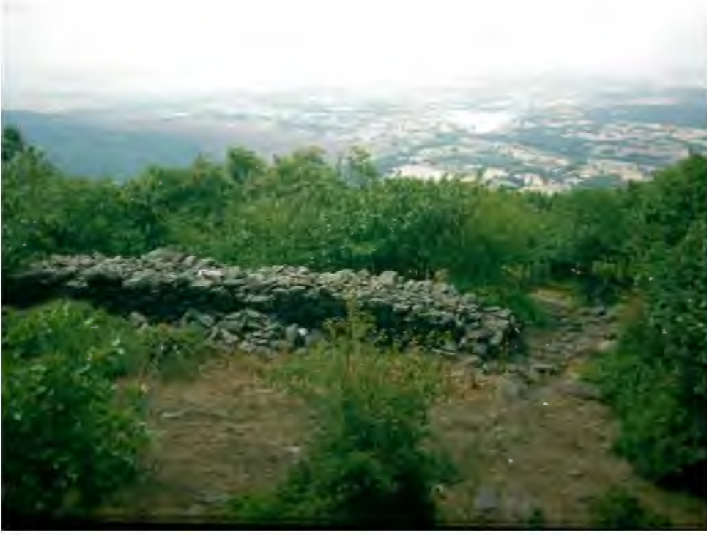
Res. 612. (Ova'dan uzakta tepe kalesi).Kırklareli, Yıldız Dağları, Evciler Köyü, Karakoçan Tepe Kalesi'nin duvar yapısı. Kurutaş tekniğiyle yapılan harçsız duvarlar, birbirine yakın boyutlarda kesilmiş, çok büyük olmayan taşlarla oluşturulmuştur.(İ.H. Kurtuluş arşivi, 1995)
