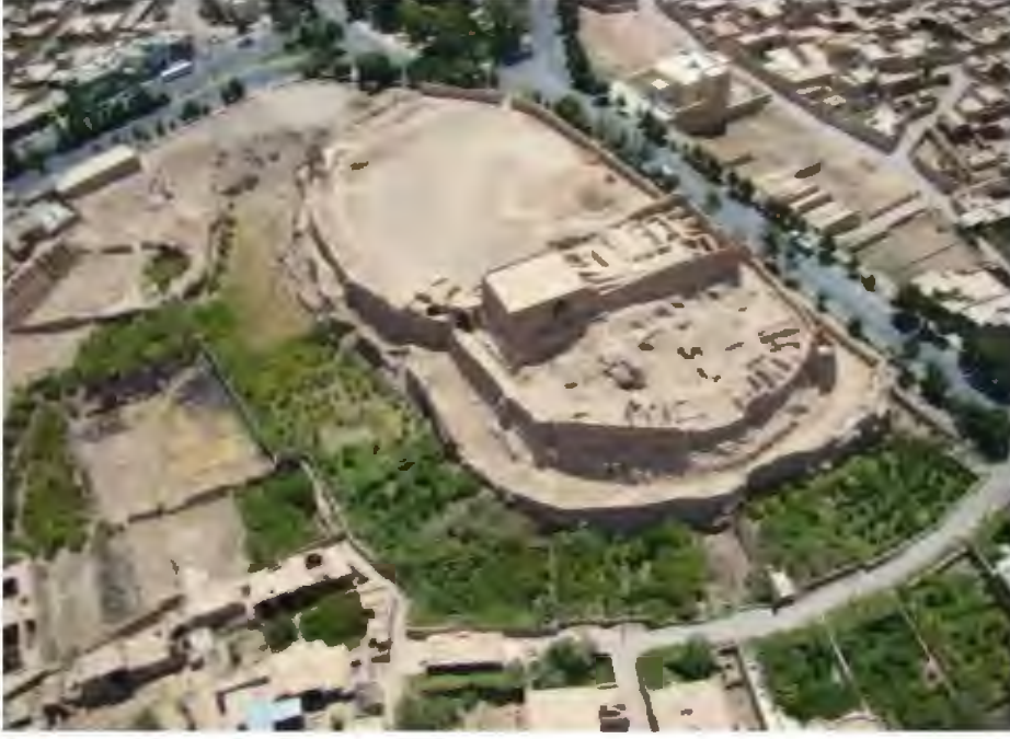
Res. 1. Narin Kale, yapımında, yüksek kaliteli kerpiç kullanılmıştır (Bafghi, Zad, Khalilabab, 2016: 14)
