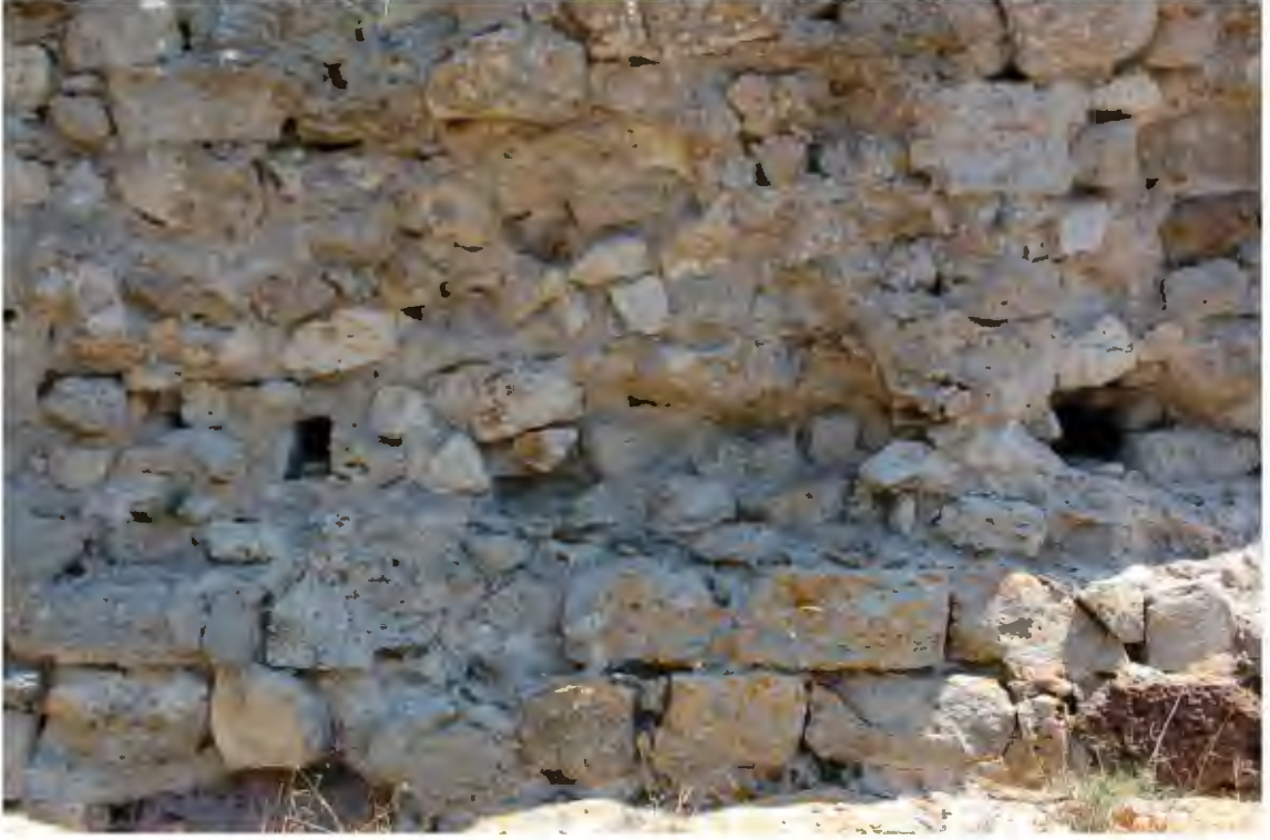
Res. 491. Karaincirli Kulenin moloztaş duvar içyapısı (İ.H. Kurtuluş, 2018)
