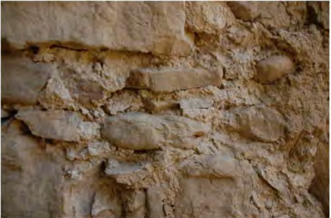
Res. 260. Galerinin yapımında kuvvetli, beyaz renkli harç kullanımı (İ.H. Kurtuluş, 2018).
