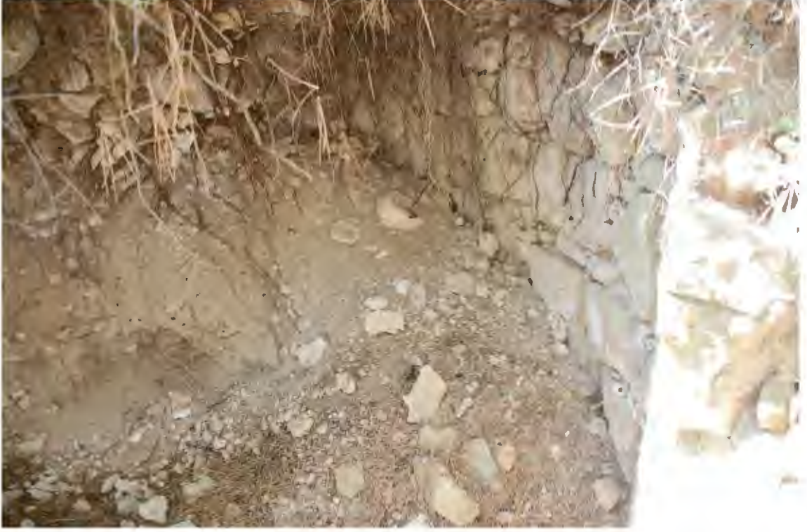
Res. 275. Yapının dairesel kısmında görülen duvar işçiliği (İ.H. Kurtuluş, 2018).
