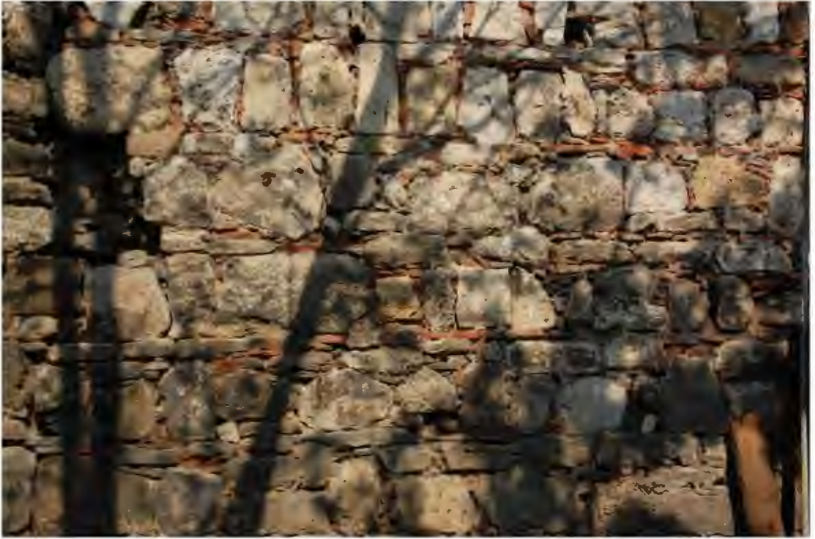
Res. 40. Bizans dönemine ait 5 numaralı sur kalıntısında tuğla ile çerçevelenmiş taş-tuğla dokusu (İ.H. Kurtuluş, 2019).
