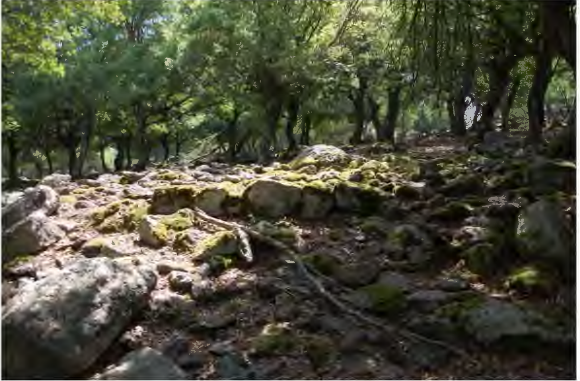
Res. 559. Hisarlıdağ Tahkimatlı alanının 1 no'lu duvarında yıkılmış duvara ait taşların iki yana akarak biriktiği bir bölümde altyapısını korumuş kısım (İ.H.Kurtuluş, 2018).
