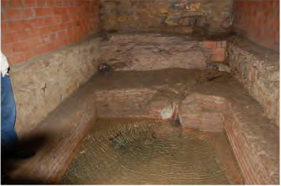
Res. 662. Hamzabeyli köyünde, kale arazisi olarak gösterilen alanın aşağısında bulunan su kaynağı ve su haznesi (İ.H. Kurtuluş, 2018).
