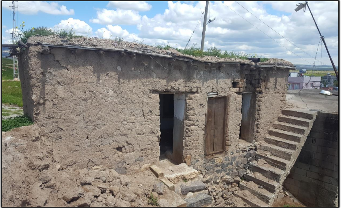
Foto 3.15: Bazalt, Toprak, Kiretařı ve Ahřap Malzeme Kullanılarak Yapılmıř Bir Ev (Oylum Mahallesi).
