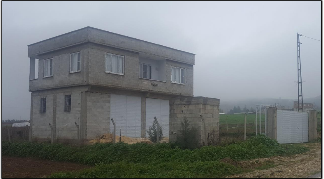
Foto 3.19: Briketten Yapılmış Konut (Bağarası Köyü).
