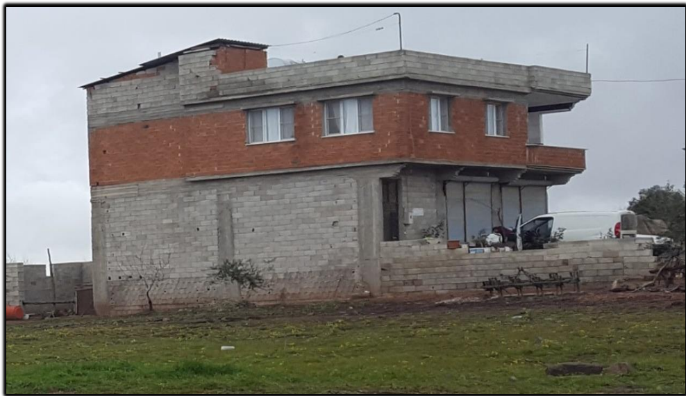
Foto 3.21: Briket ve Tuğladan Yapılmış Konut (Kaynaklı Köyü).
