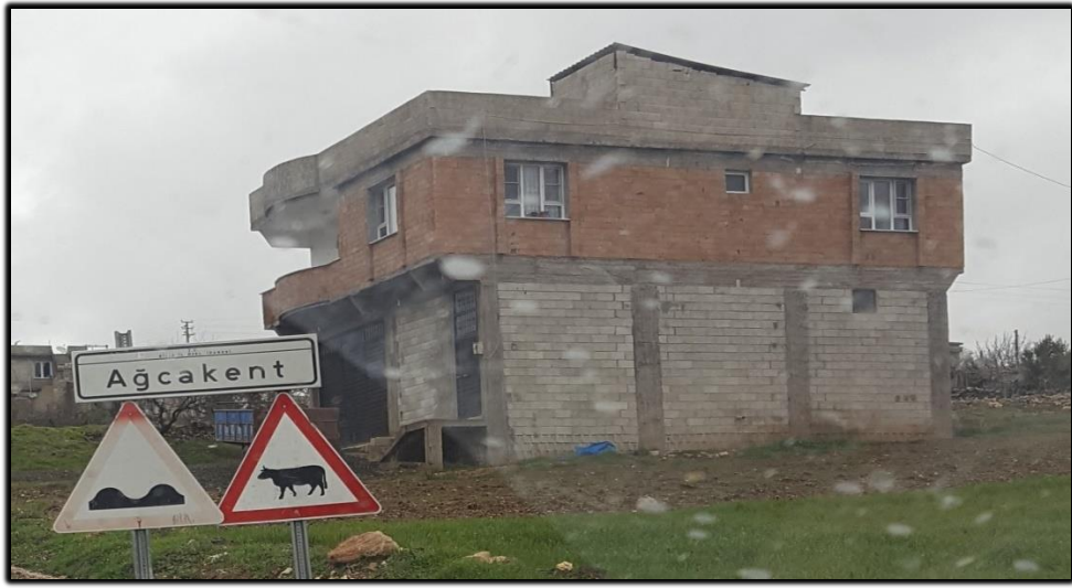
Foto 3.20: Briket ve Tuğla Kullanılarak Yapılmış Bir Konut (Ağcakent Köyü).
