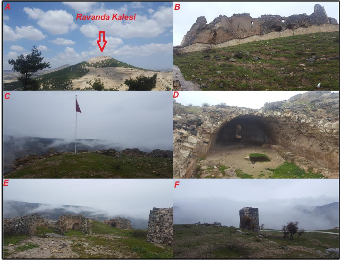
Foto 4.33: A-Ravanda Kalesi, B-Kalenin Dış Cephesi, C-Kalenin Kurulduğu Düzlük, D, E ve F- Kalenin Ayakta Kalmış Yapıları.
