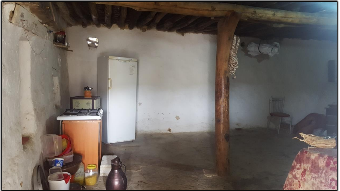
Foto 3.18: Kireçtaşı ve Bazalt Kullanılarak İnşa Edilen Evin İç Kısmından bir Görüntü, (Koçağız Köyü).
