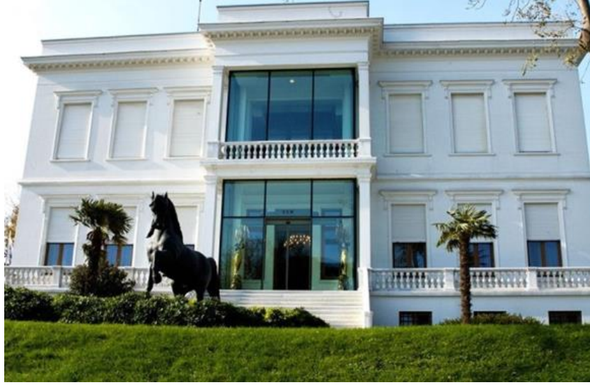
Fotoğraf 7: Sakıp Sabancı Üniversitesi Sakıp Sabancı Müzesi Binası Dışarıdan Görünüş,
