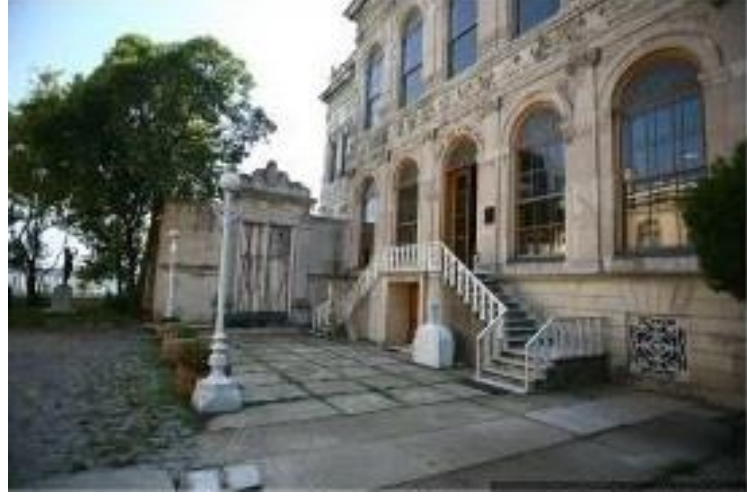
Fotoğraf 1: Resim Heykel Müzesi Binası
