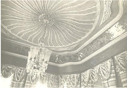
Fotoğraf 77: Tezyinat Restorasyonu Öncesi Servis Odası, 1982-87 46
