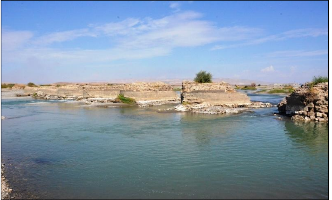
Fotoğraf 17: Pira Pepira Köprüsü
