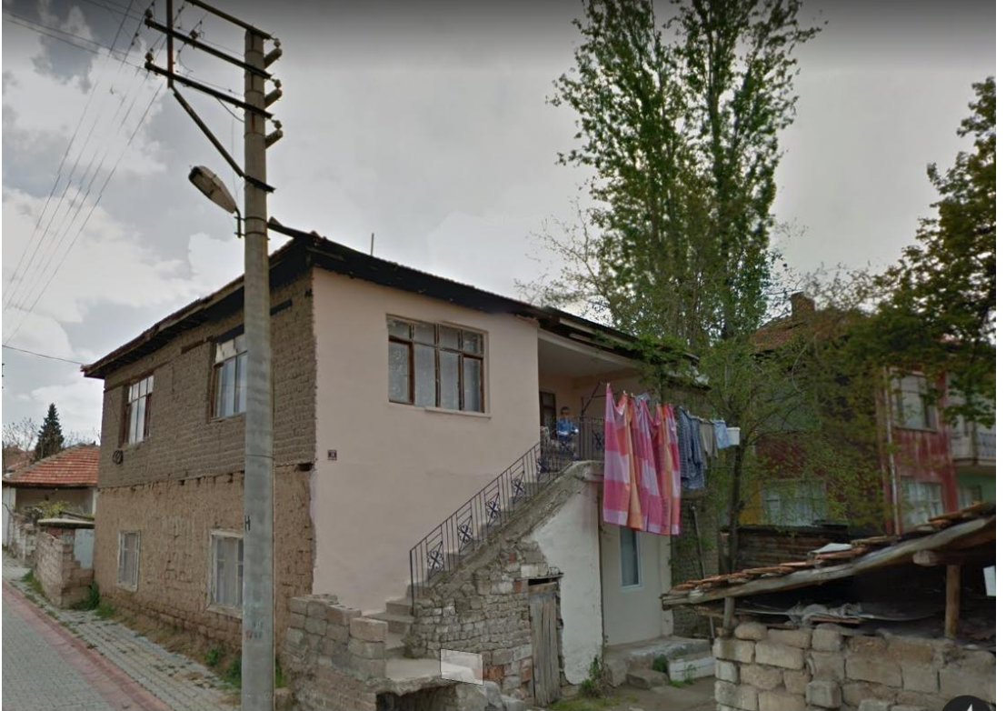
Foto 28. Kırıkkale Şehri'nde Bulunan Geleneksel Kerpiç Mesken
