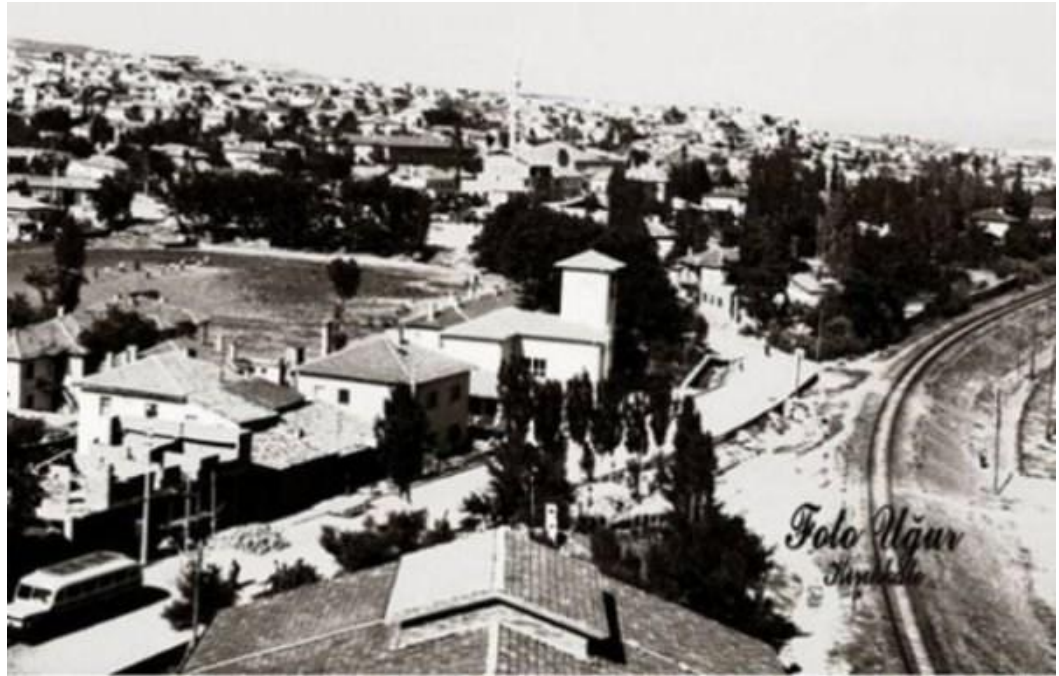
Foto 6. Kırıkkale Şehri'ndeki Tren İstasyonu ve Demiryolu
