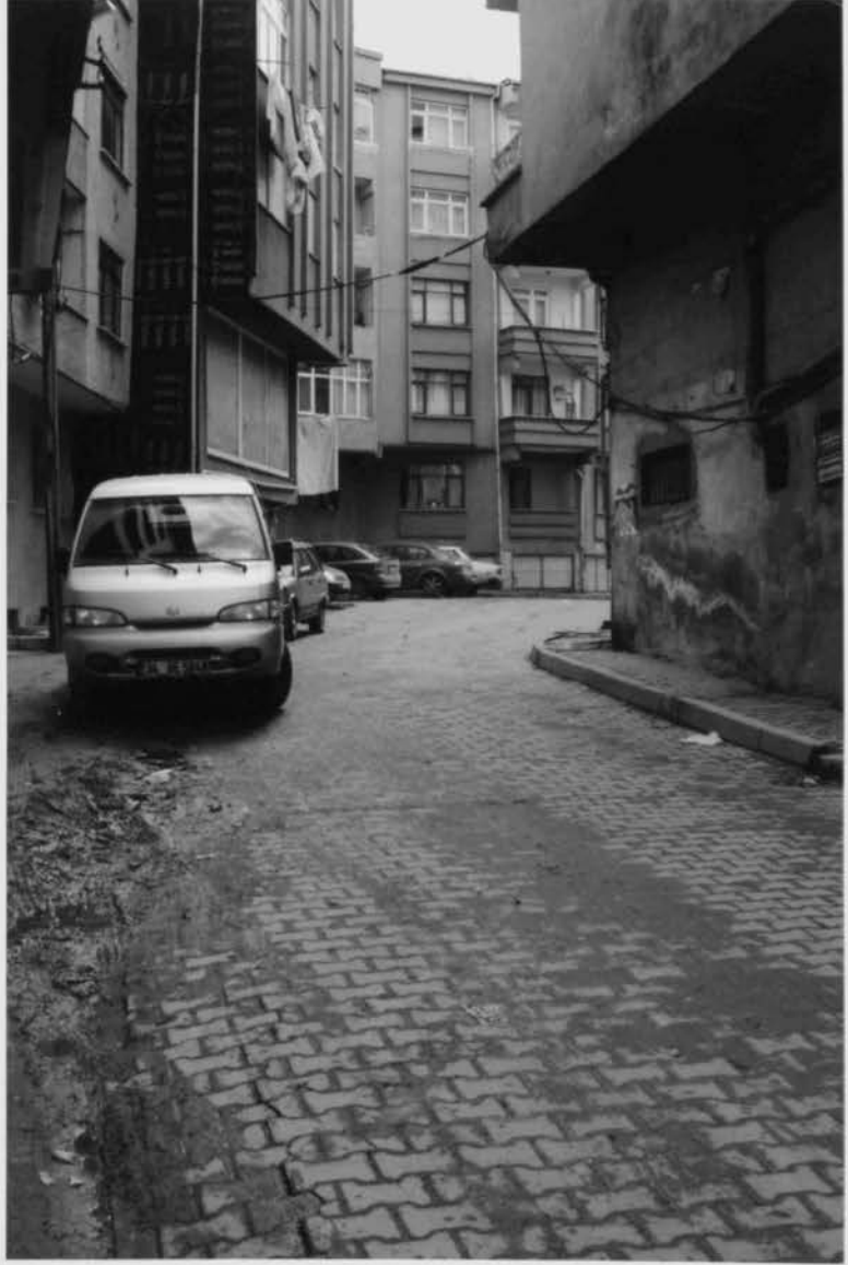
Foto-11:Zeytinburnu İlçesinden apartman görüntüleri
