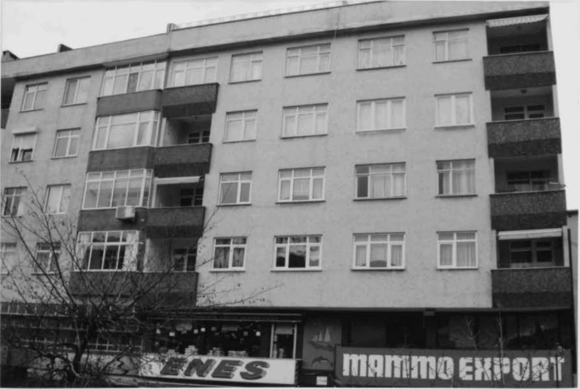
Foto-6:Gökulp Mahallesi 58 Bulvar caddesinden apartman görüntüleri
