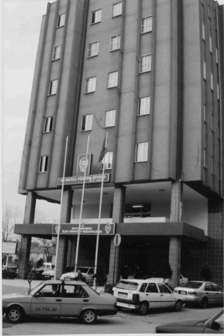
Foto-3: İlçe Emniyet Müdürlüğü Binası
