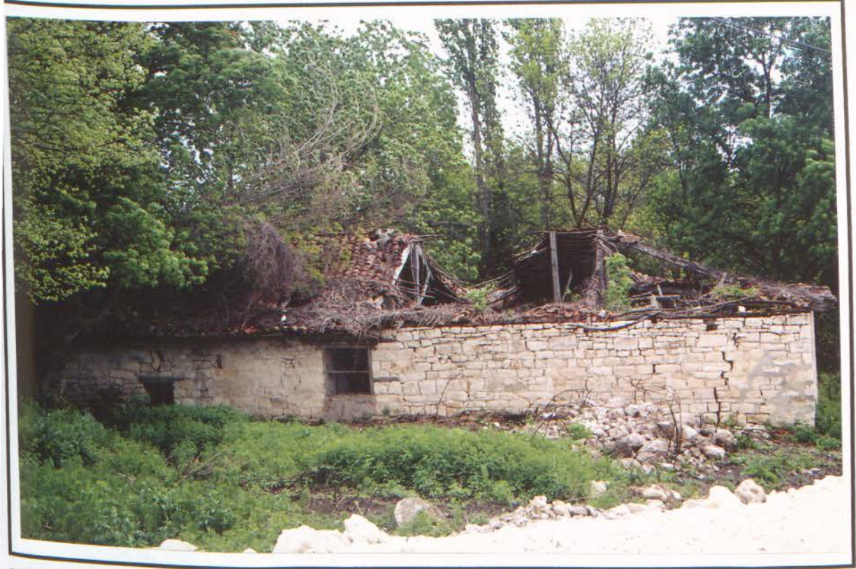
FOTO-58 KÖYDE YIKILMIŞ EN ESKİ EV
