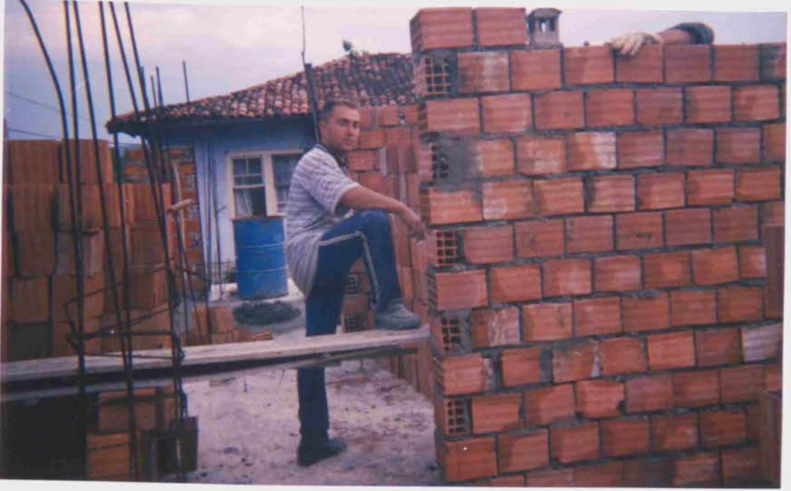
Fotoğraf 31: Yeni evli genç erkek, kendi evinin inşaatında çalışmakta.
