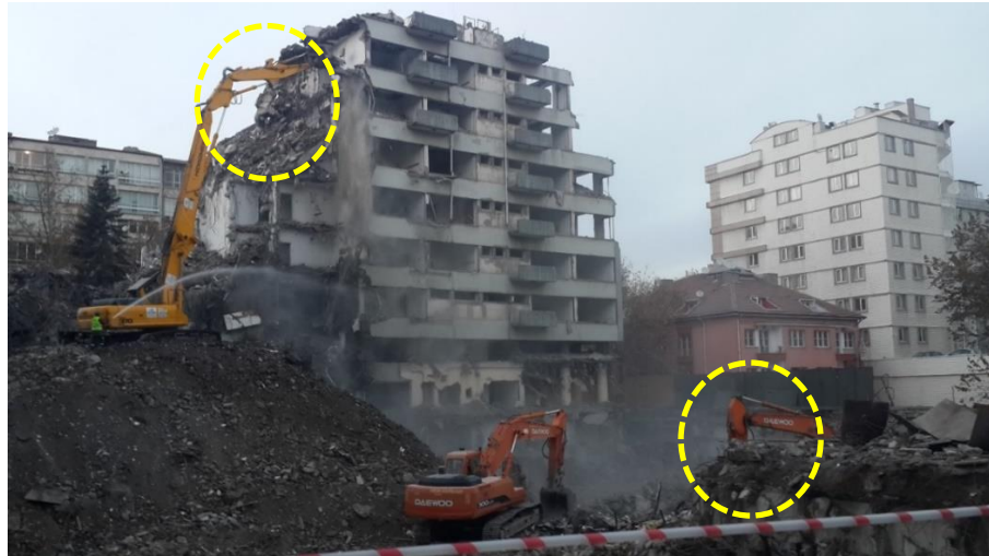
Resim 4.7. Makas İle Bina Yıkımı
