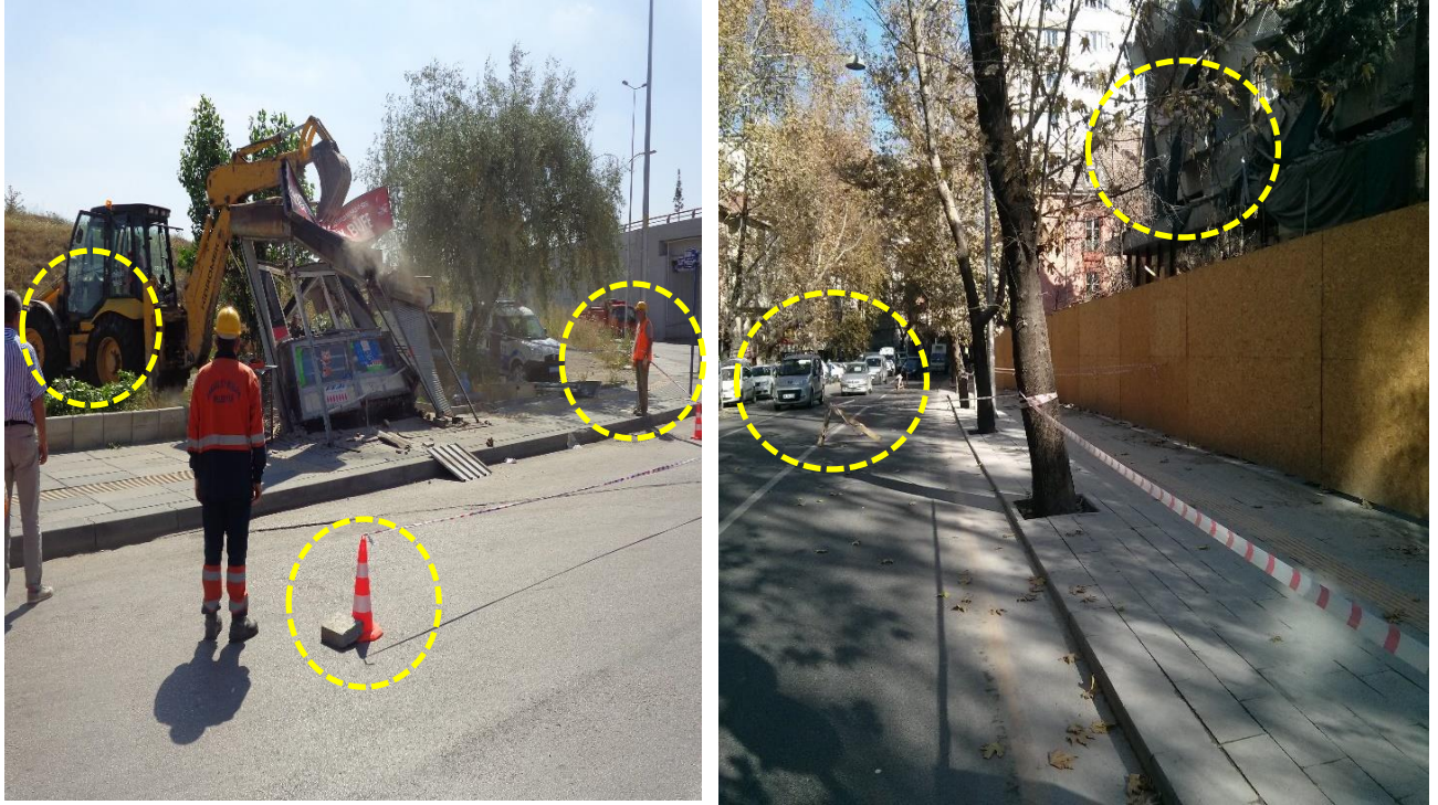
Resim 4.3. Yıkım Sahasının Çevrenmesinde İki farklı Örnek
