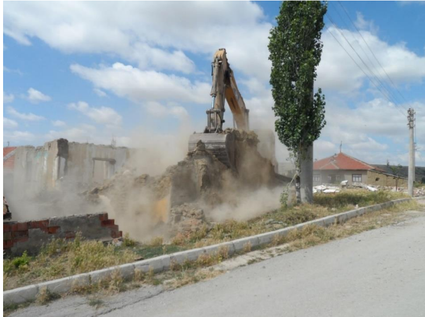
Resim 4.13. Yıkım Esnasında Oluşan Toz
