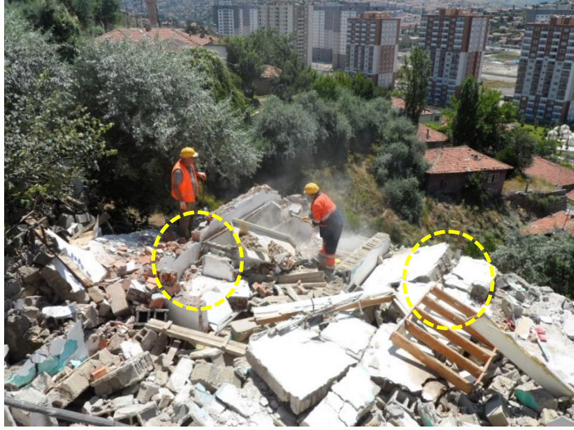
Resim 4.9. Güvenli Olmayan Yüksekte Çalışma
