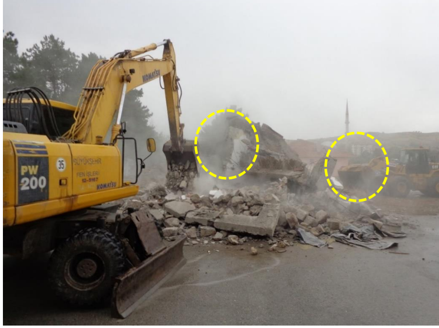
Resim 4.6. Bina Yıkımında Kullanılan Ekskavatör ve Loder
