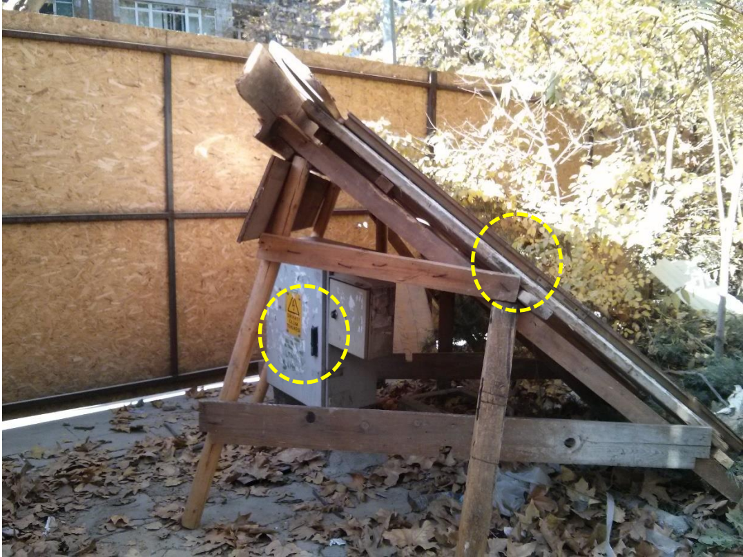
Resim 4.11. Elektrik Panelinin Moloz Düşmesine Karşı Korumaya Alınması
