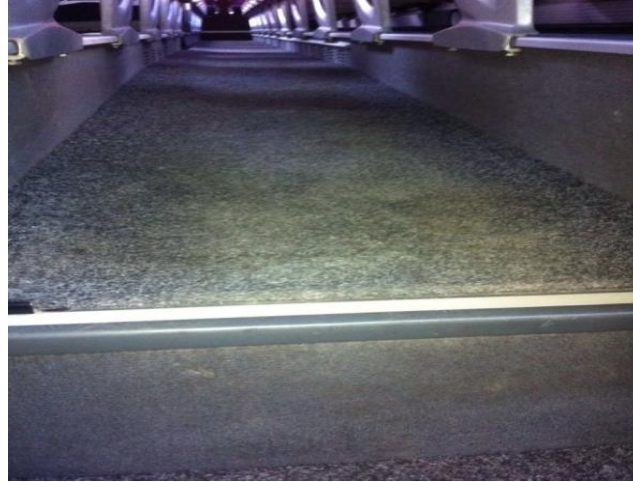
Şekil 12. Halıfleks ile Kaplanmış Koridor Zemini
