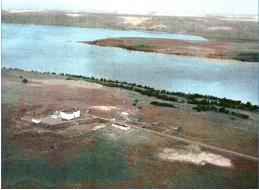
RESİM 3. Küçükçekmece’de 1960-62 Arasında İnşa Edilen Reaktör Binası (solda) ve İdare Binası (sağda). Kaynak: Türkiye Atom Enerjisi Kurumu Çekmece Nükleer Araştırma ve Eğitim Merkezi – Tarihçe (1956-2003). Yazar yok. Tarih yok.
