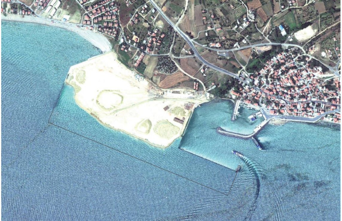
Şekil 3.192: Asya Port limanı, dolgu yapım aşaması.
