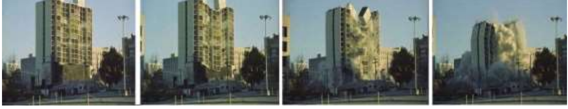
Şekil 2.23: Betonarme Binanın Olduğu Yere Çökertilerek Yıkılması (Özer ve Karadoğan, 2012)
