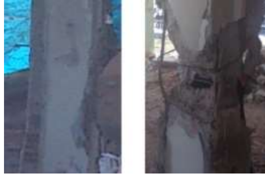
Şekil 4.41: 11 Numaralı Kolonun Ateşleme Öncesi ve Ateşleme Sonrası Durumu
