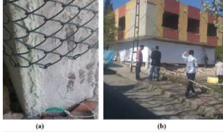
Şekil 2.8: Parça Savrulmasına Yönelik Alınan Güvenlik Önlemleri
