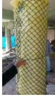
Şekil 4.45: Kolonlarda Alınan Güvenlik Önlemleri
