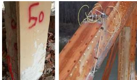
Şekil 2.38: Yapı Elemanlarında Patlayıcı Konumları
