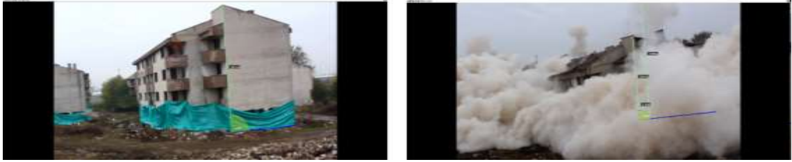
Şekil 4.29: Binaın Maksimum Yüksekliği ile Yıkım Sonrasındaki Maksimum Yüksekliği
