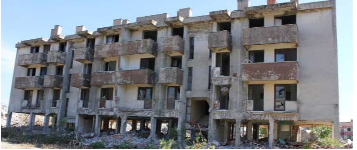
Şekil 3.2: Edirne Kapıkule Gümrük Lojman Binası
