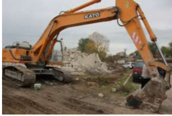
Şekil 4.34: Yıkımda Kullanılan KATO Ekskavatör
