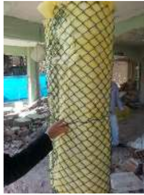
Şekil 2.9: Cam Yününün Gürültüyü Azaltmak Amacıyla Kolona Sarılması
