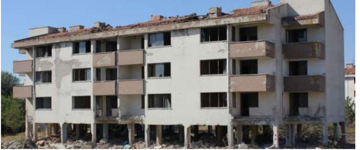
Şekil 3.3: Edirne Kapıkule Gümrük Lojman Binası
