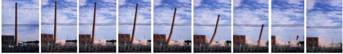
Şekil 2.30: Tuğla Bacanın Yan Yatırma Metodu İle Kontrollü Yıkımı (Özer ve Karadoğan, 2012)
