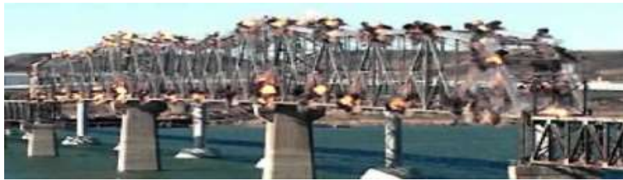
Şekil 2.33: Çelik Köprülerin Kontrollü Patlatmalarla Yıkılması (Özer ve Karadoğan, 2012)
