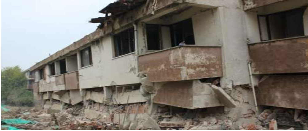
Şekil 4.27: Yıkılmış Binanın Görüntüsü
