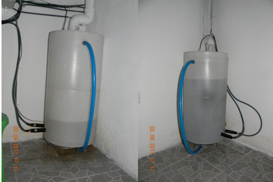
Ek-7.2.8 - Yağış sırasında çatı sistemlerinden tahliye edilen su miktarı (Yeşil çatı solda, referans çatı sağda) – 9 Mart 2011
