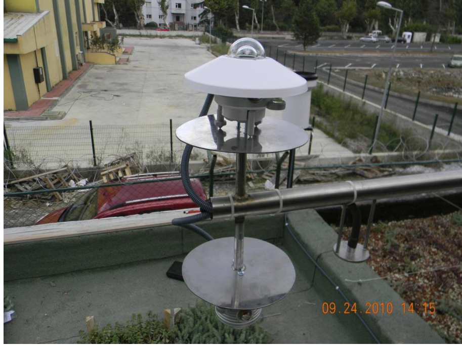
Ek-7.2.3 - Çatı yüzeyinde bulunan piranometreler
