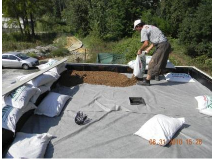
Şekil 3.6: Yeşil çatı sisteminin oluşturulması
