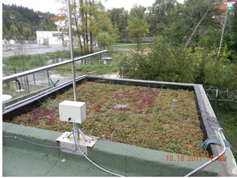
Ek-7.3.5 - Yeşil çatı görünümü - 18 Ekim 2011
