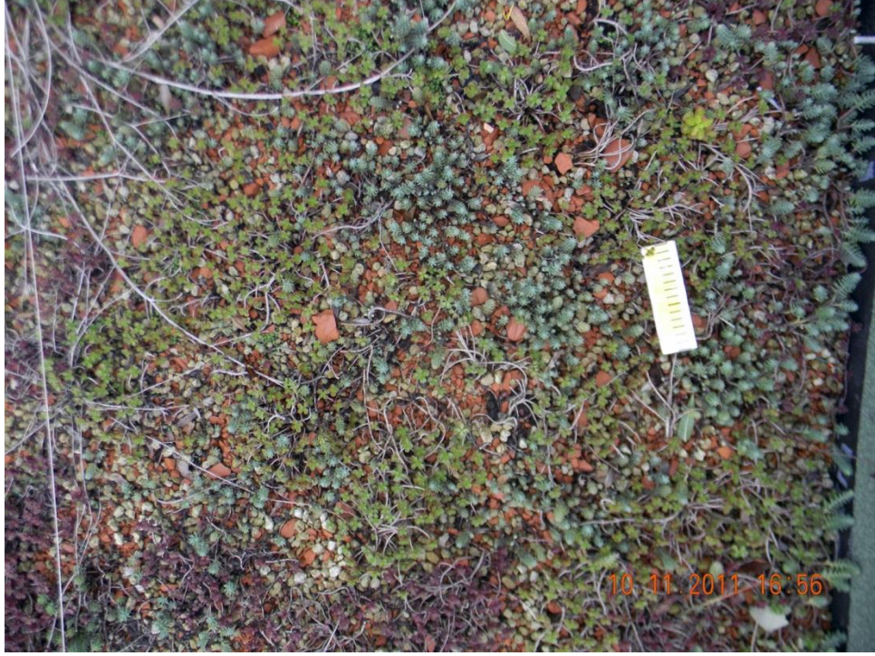
Şekil 4.70 – Çatı yüzeyinden elde edilen fotoğraf örneği
