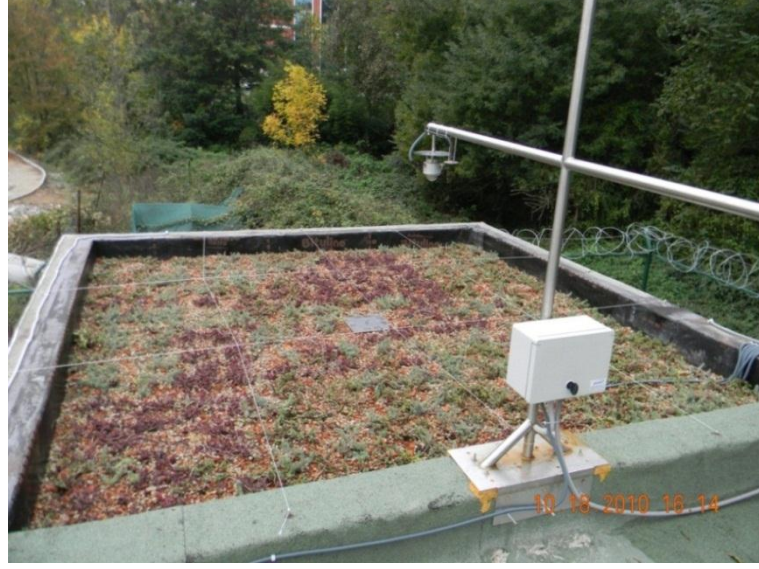
Ek-7.3.1 - Yeşil çatı görünümü - 18 Ekim 2010
