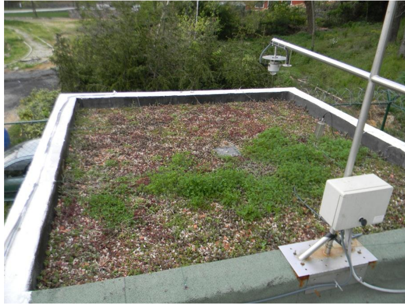
Ek-7.3.6 - Yeşil çatı görünümü – 20 Nisan 2012
