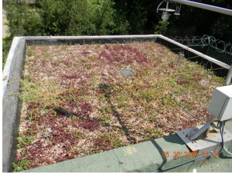
Ek-7.3.3 - Yeşil çatı görünümü - 30 Mayıs 2011
