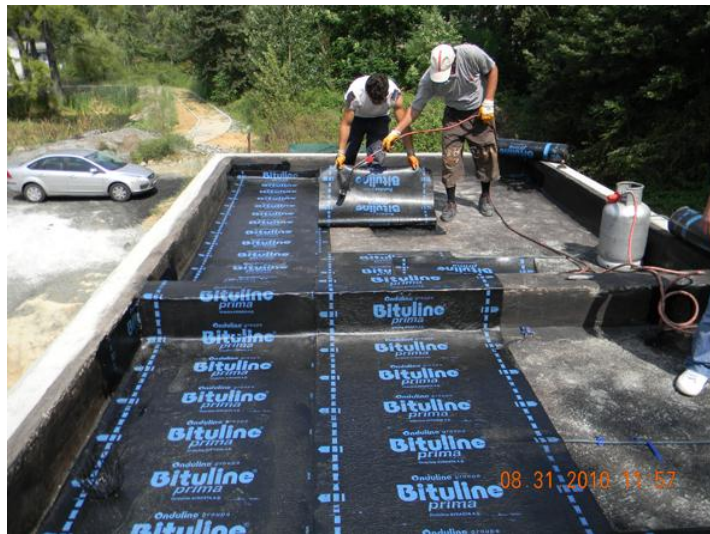
Şekil 3.5: Çatı yüzeyine su yalıtımı uygulaması
