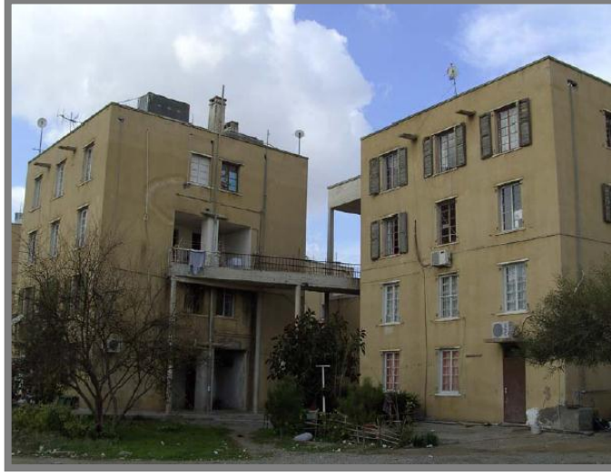
Foto 36: 1958 yılında Büyük Kaymaklı bölgesine inşa edilen polis konutları (Tozan, 2008: 175).
