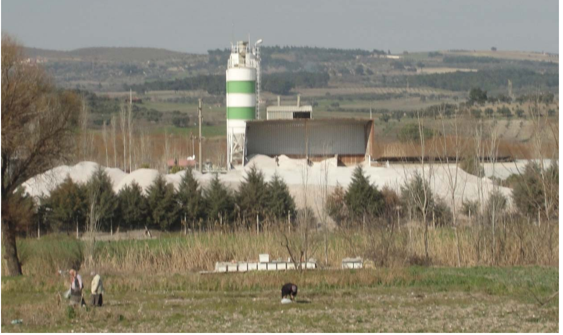
Fotoğraf 54: Erdenler taşocağı işletme tesisi (19/06/2010).
