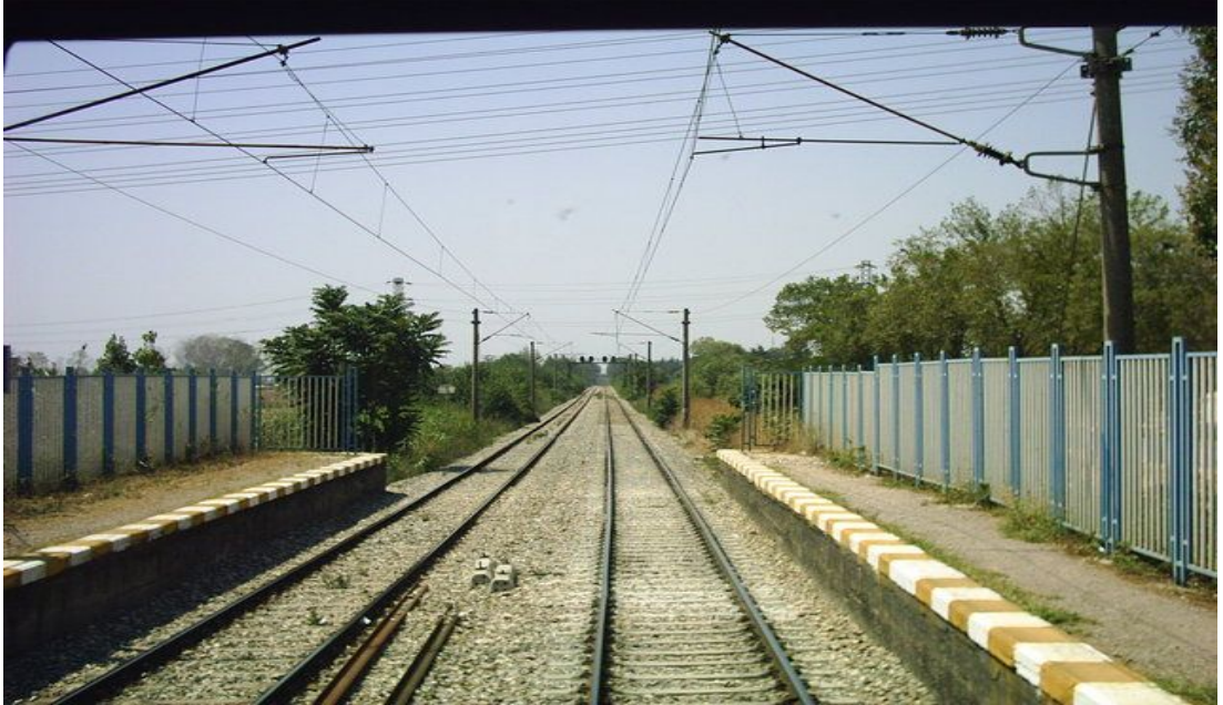
Foto 8: Gebze Osmangazi Tren İstasyonu.
