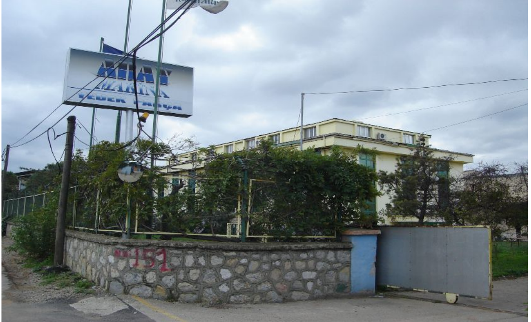
Foto 37: Abay Makine Tesisleri. Foto Selva TEZKIZAN.
