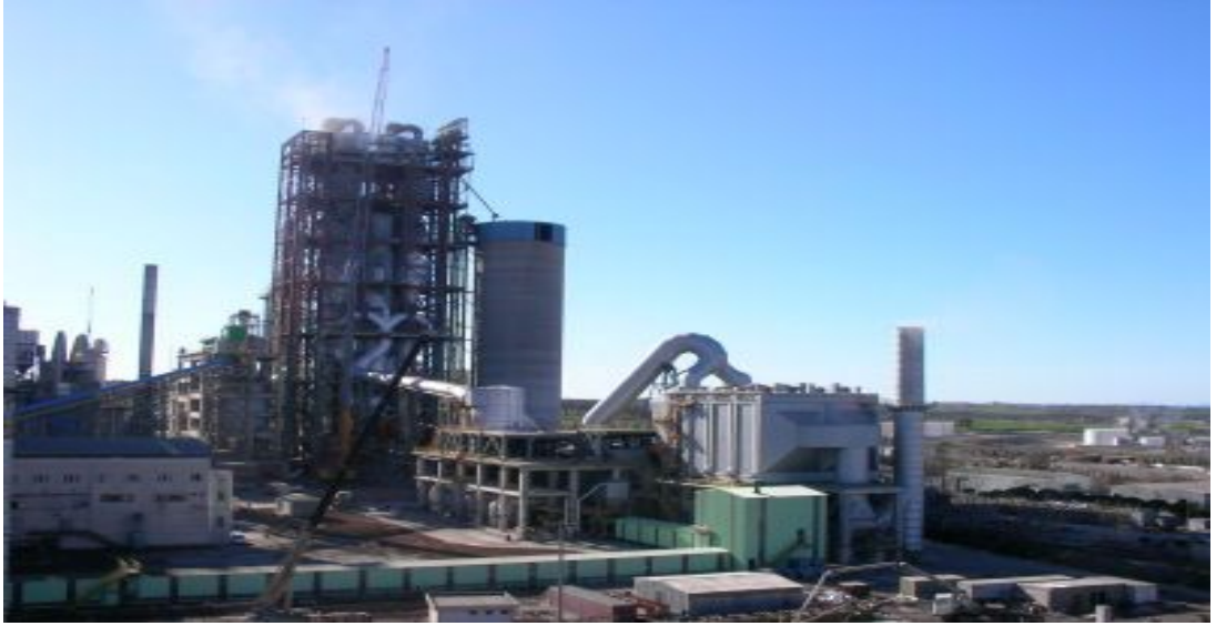
Foto 44:Aslan Çimento Fabrikası. www.ceta.com.tr 'den alınmıştır.
