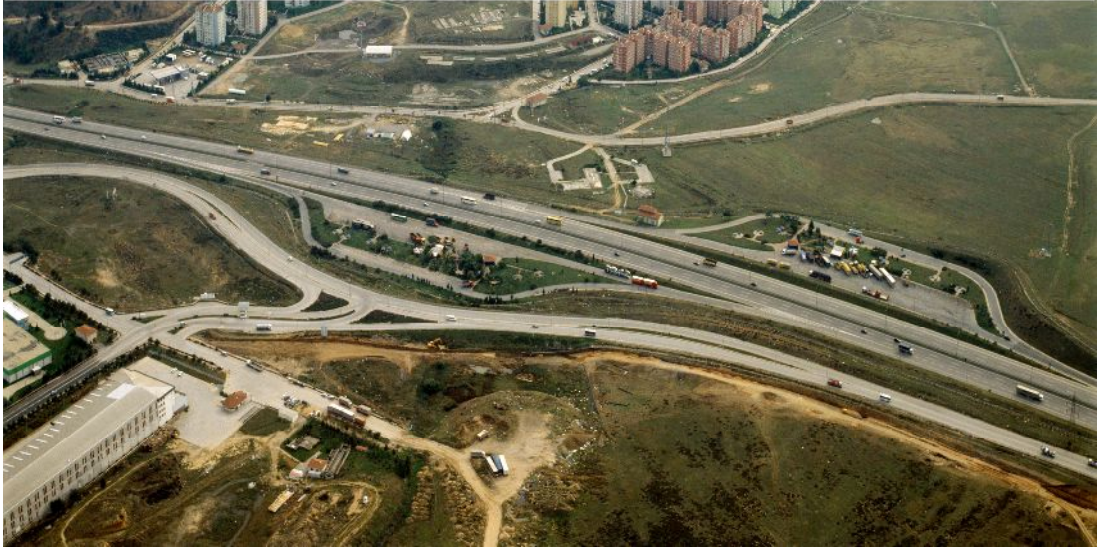
Foto 6: TEM Otoyolu Gebze Mutlukent Geçişi. Gebze Belediyesi'nden alınmıştır.
