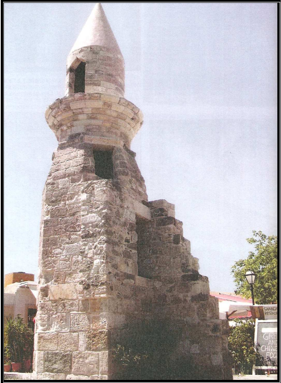
EK-3: Yeni Kapı Camii (Neval Konuk'tan)
