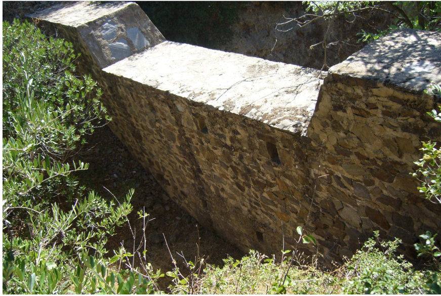
Şekil 5.2: Kargılı dere havzasında arkası dolmamış taşıntı barajı
