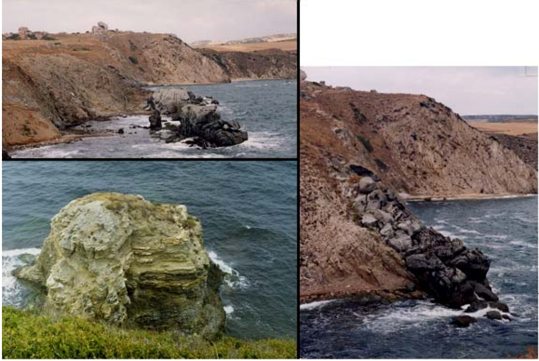
Foto 114, 115, 116: Karabiga kuzeydoğusunda Kale Burnu kıyılarında kıyı aşınımını gösteren kayalıklar ve falez üzerinde bulunan Piriapos harabelerinin kıyı aşınımıyla tahrip olması.
