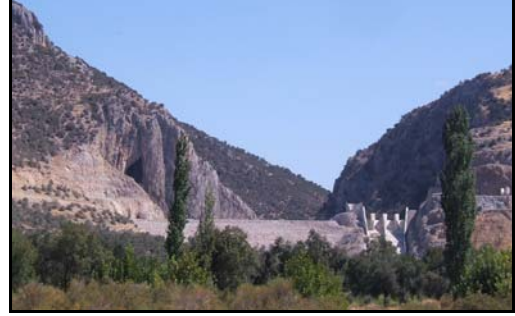
Foto 32: Havran Barajı inşaatı (12.10.2006).
