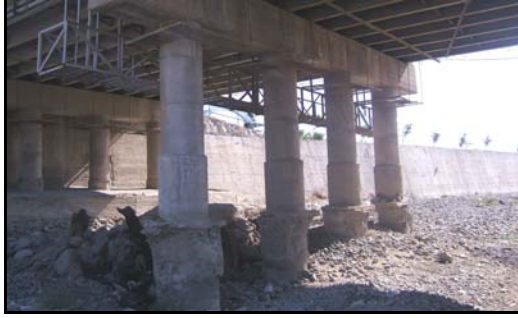
Foto 39: Havran köprüsü ayakları.
