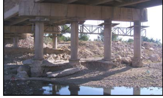
Foto 40: Çevreyolu köprüsü ayakları.
