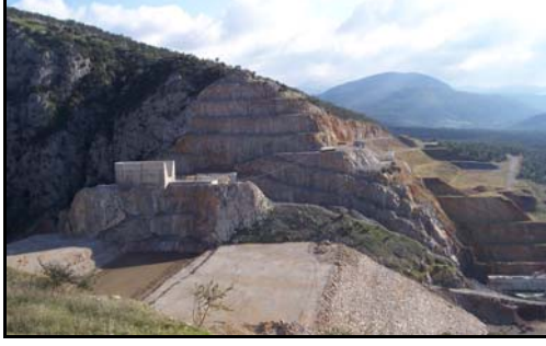
Foto 31: Havran Barajı inşaatı (26.01.2006).
