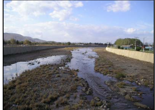
Foto 34: Havran Çayı kenarındaki beton duvarlar.
