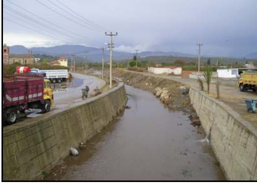
Foto 33: Küçükçay kenarındaki beton duvarlar.
