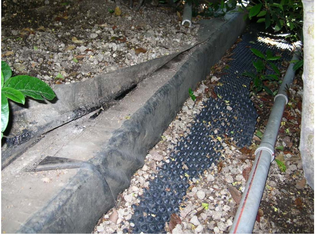
Şekil 3.3 : Bahçedeki drenaj ve su yalıtımı.
