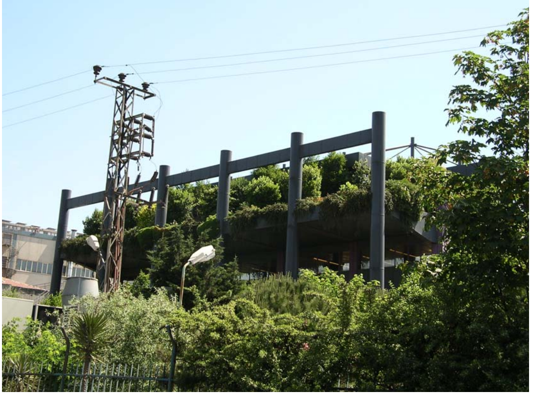
Şekil 3.2 : Binanın dışarıdan görünüşü
