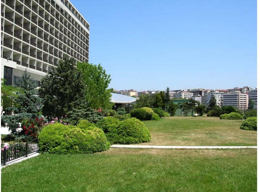
Şekil 3.24 : Hilton Oteli küçük otel binası üzerinde bulunan çatı bahçesi
