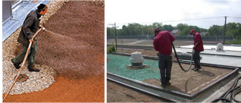
Şekil 2.21. Hydroseeding uygulaması[21]
