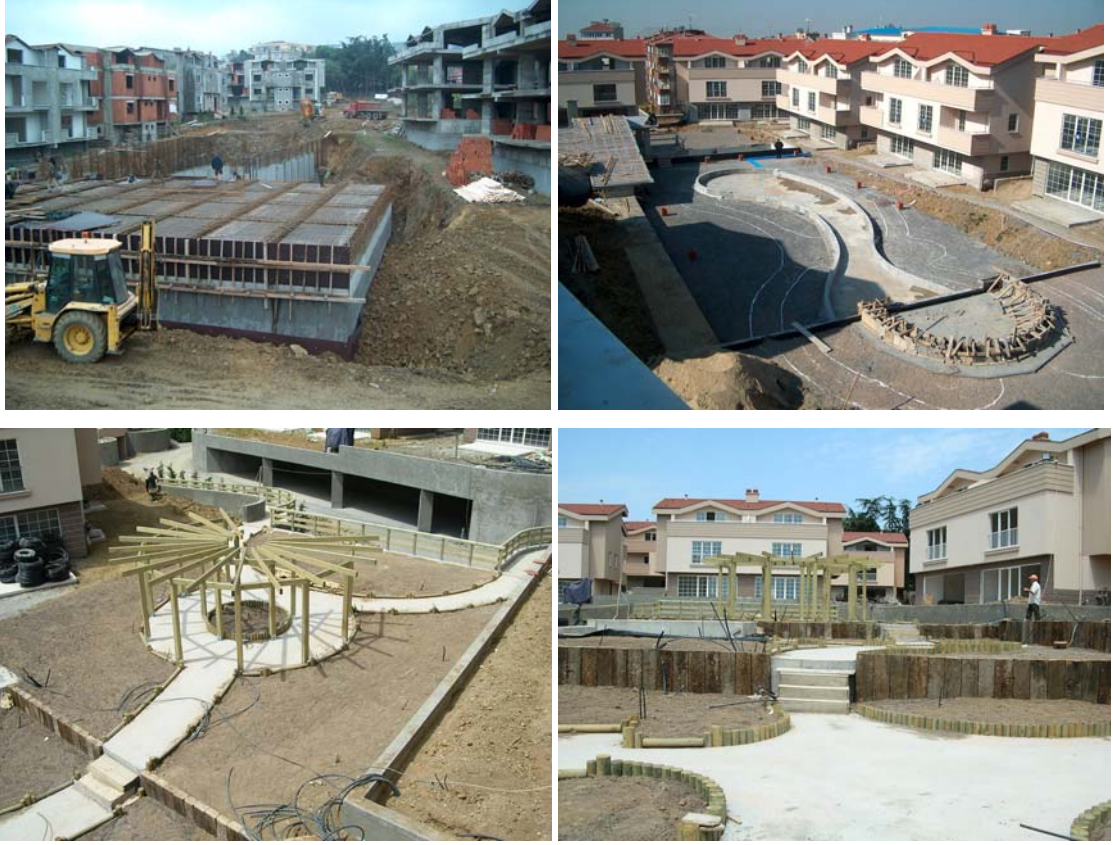
Şekil 3.17 : Çatı bahçesinin yapım aşamaları.
