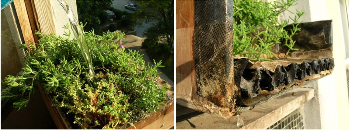
Şekil 4.21 : Su verildikten sonra suyun drenaj katmanından tahliyesi.
