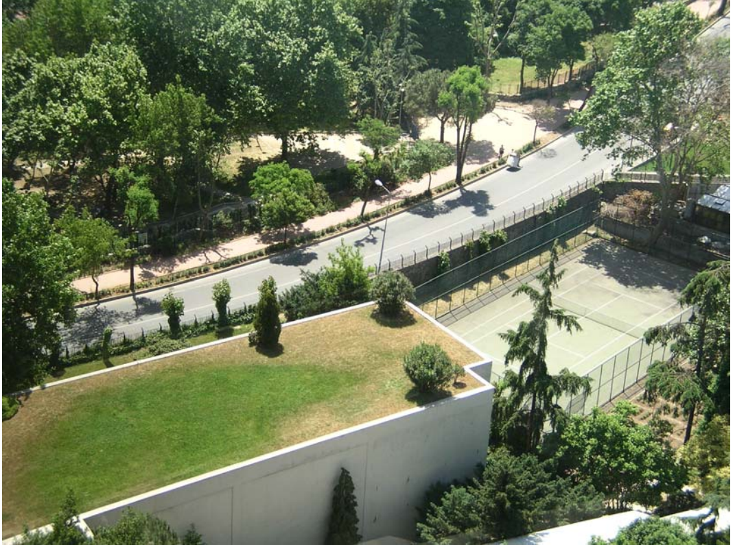
Şekil 3.26 : Çatı bahçesinden diğer bir görünüm.
