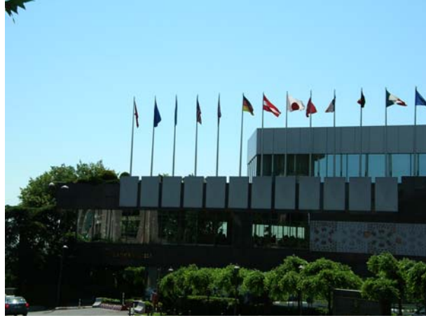
Şekil 3.31 : Ceylan Intercontinental Otel çatı bahçesinin dışarıdan görünüşü
