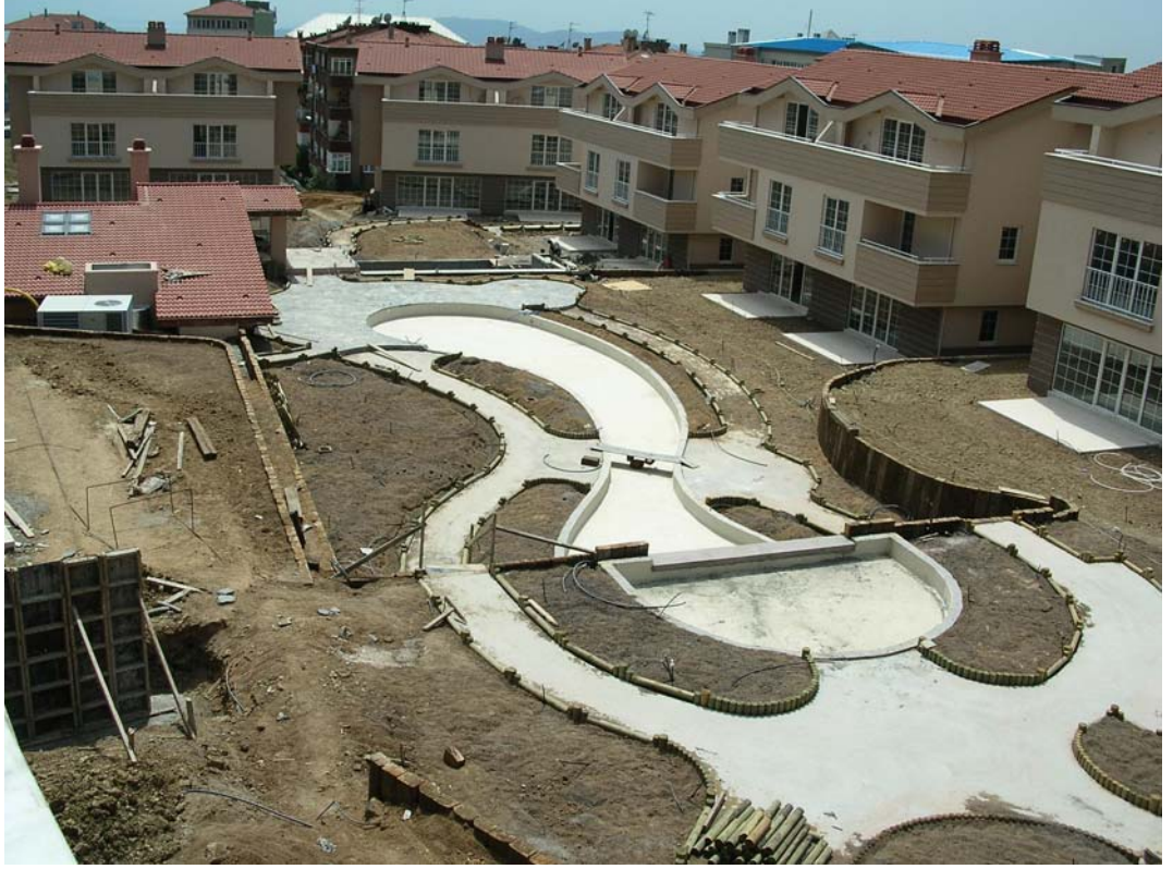
Şekil 3.15 : Çatı bahçesinin sert zemin ve ahşap setlerinin yapım aşamaları.
