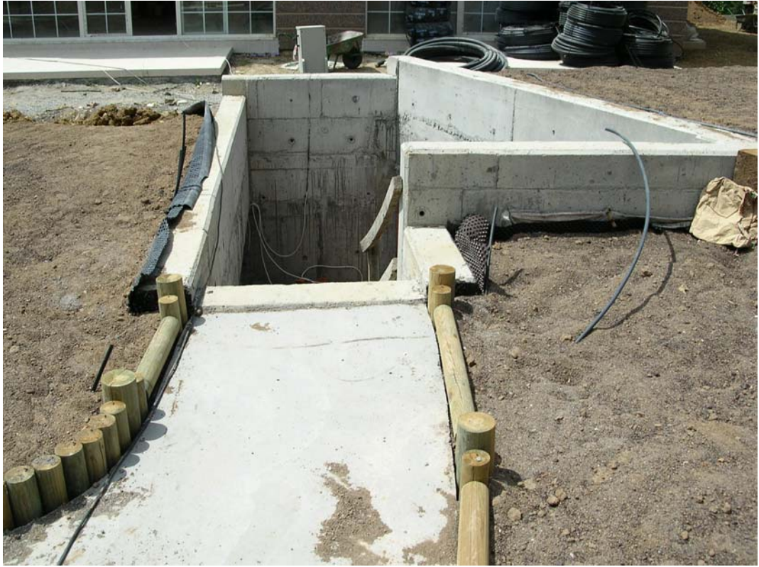
Şekil 3.18 : Çatı bahçesinden otoparka iniş.
