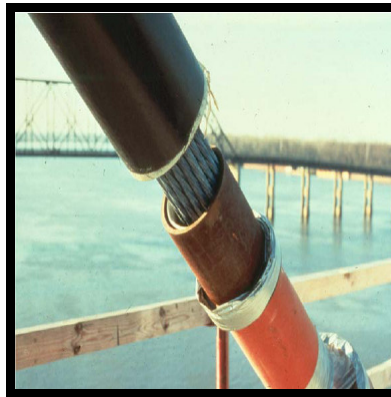
Şekil 3.35 Ana askı koruyucu elemanları [20]
