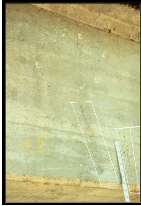
Şekil 3.3 Eğilme çatlağı resmi [20]
