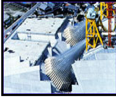
Şekil 3.31 Dağıtma konisi [20]
