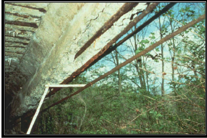
Şekil 3.12 Donatıda korozyon [20]
