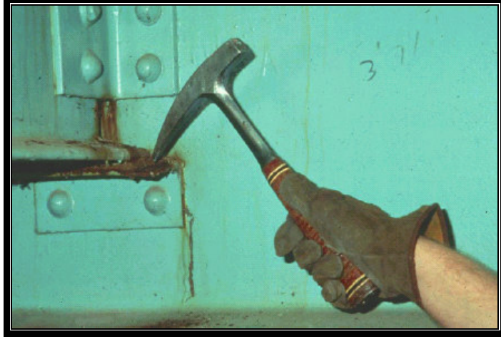
Şekil 3.27 Korozyon [20]
