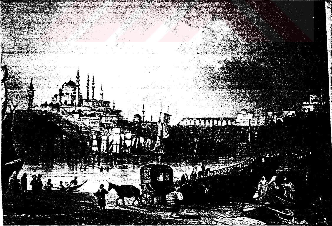
Gravür 5. Unkapanı Köprüsü - genel görünüş. (Arslan, 1992)
