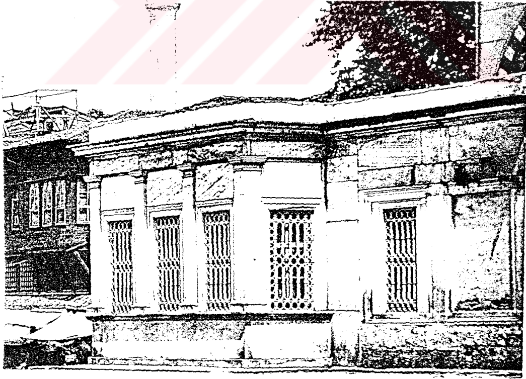
Resim 36. Sultan Ahmet Camii Muvakkithanesi - genel görünüş. (Eldem, 1979)
