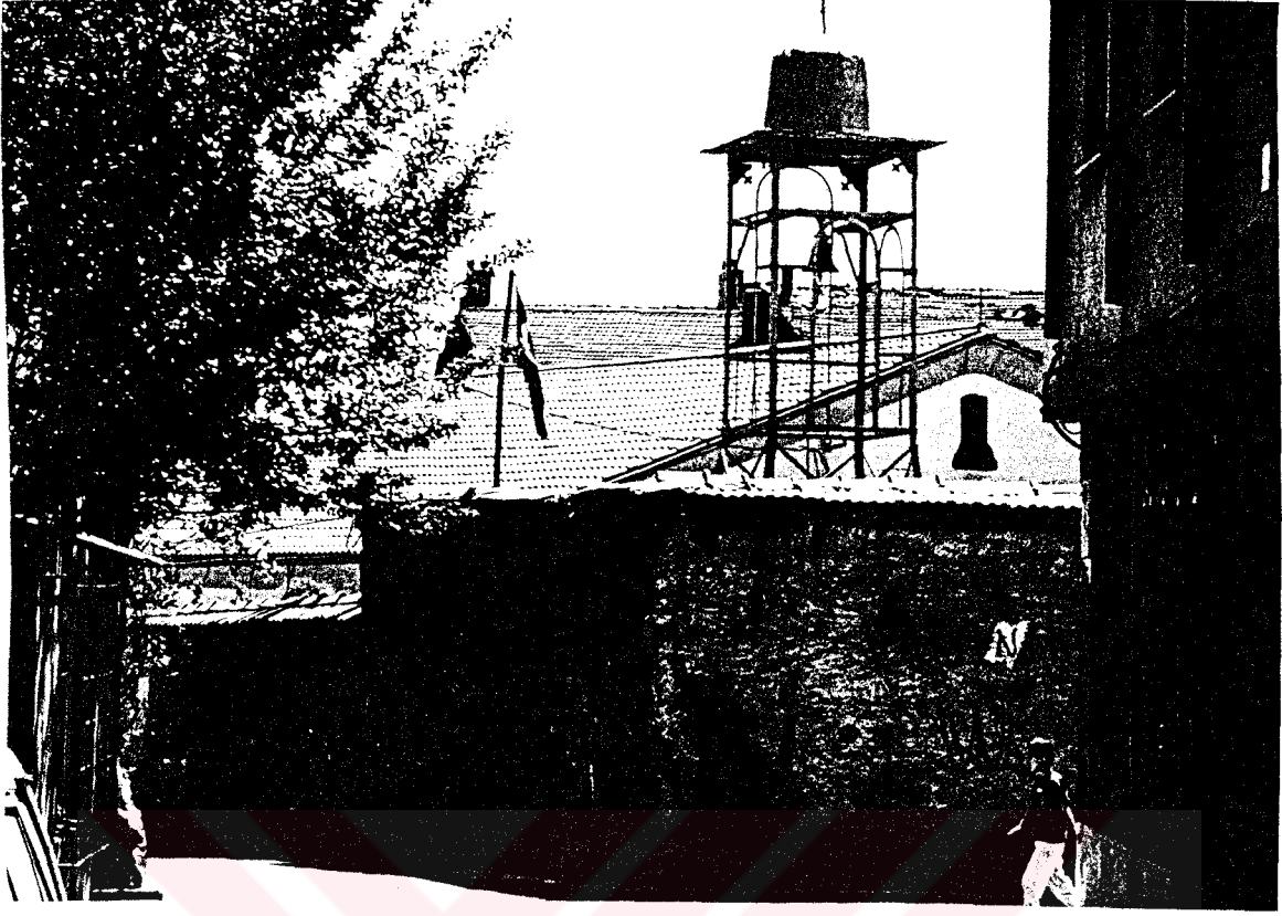
Fotoğraf 116. Panagia Kilisesi - genel görünüş.
