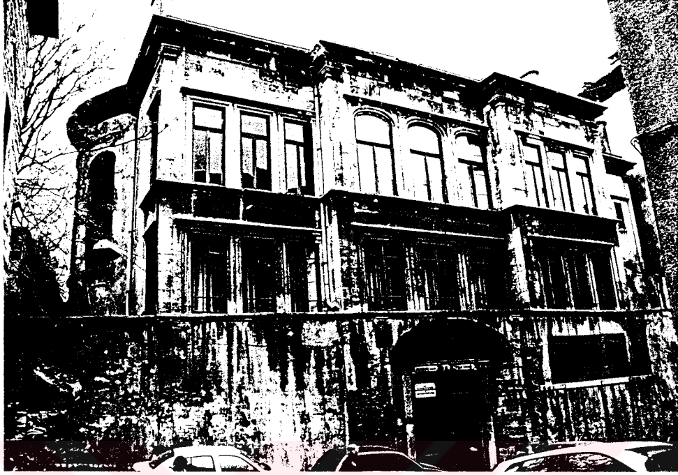
Fotoğraf 71. Suphi Paşa Konağı - genel görünüş.
