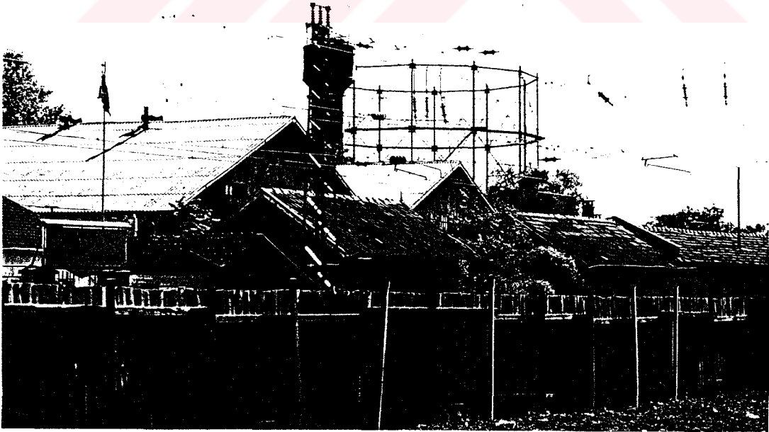
Fotoğraf 68. Yedikule Havagazı Fabrikası, Gazhane Havuzu - genel görünüş.
