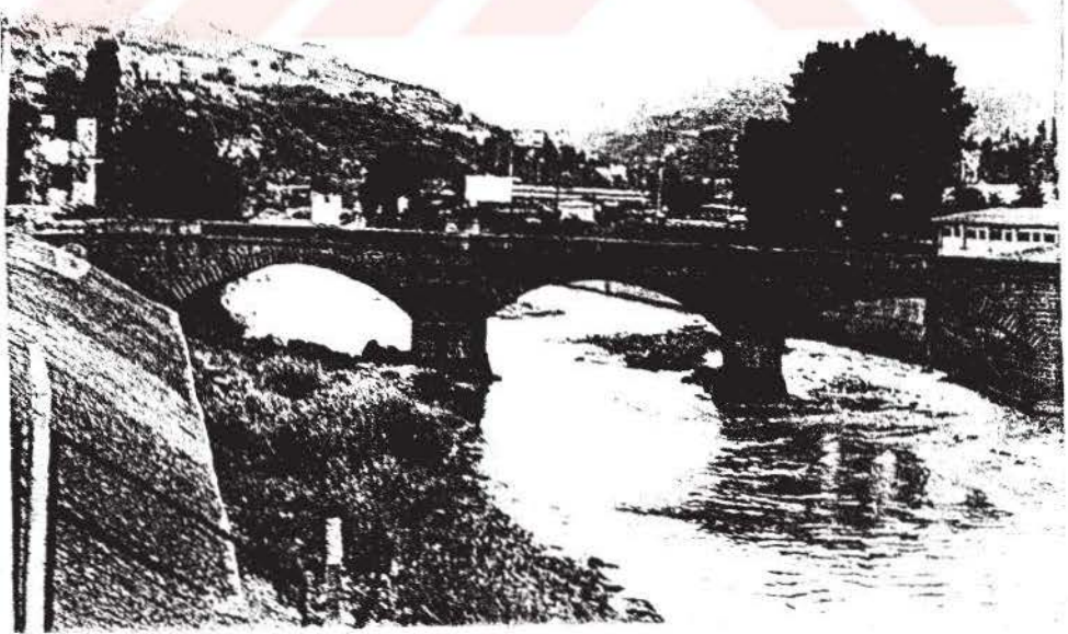
Protol5:Değirmen Dere ağız kısmından güneye bakış
