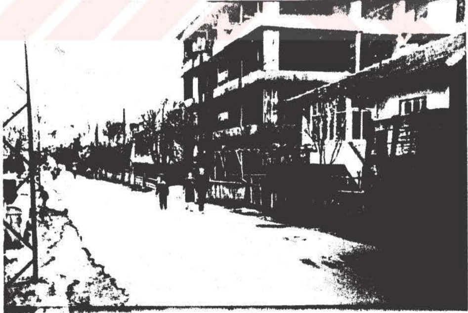
Fotoğraf 6 - Şehrin kuzeybatısındaki "eski köy" Borazanlar mahallesinde yükselen çok katlı betonarme inşaat.
