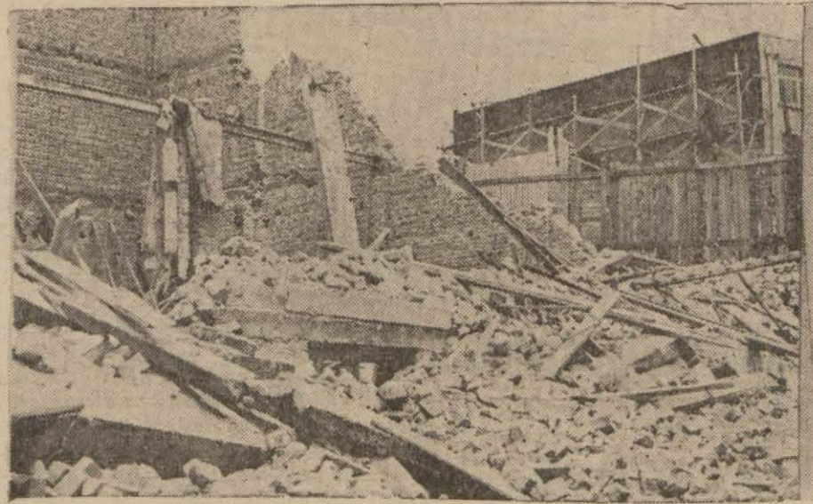
Yıkılan binanın hali
