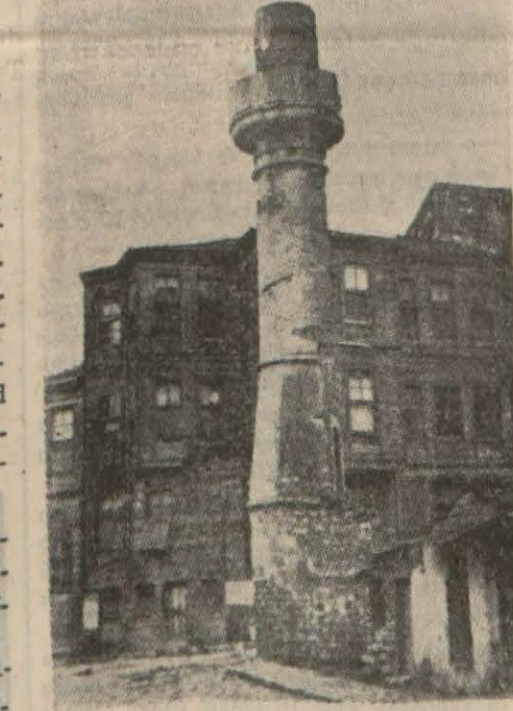
Camisi yandıktan sonra sipsivri meydanında kalan bu minare bir gün, yıkılacak ve bu, altında oynayan çocuklardan kimbilir kaçının canına mal olacaktır
