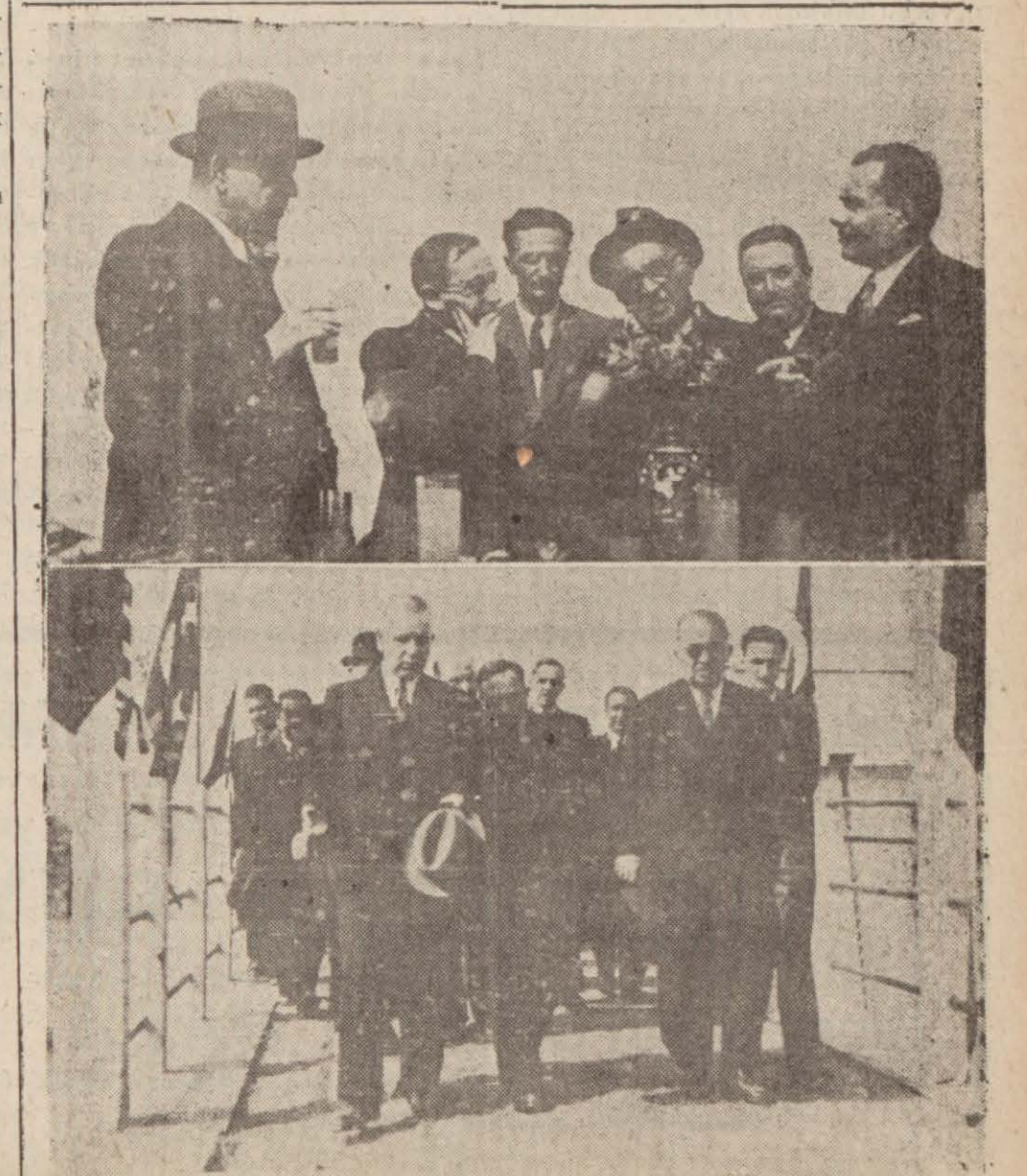
Dün Küçük Menderes nehrindeki tesisatta yapılan merasim intibalarından
