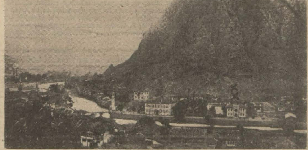
Amasyanın umumi görünüşü ve bodrum katlarını su kaplıyan hükûmet konağı (X) ile belediye dairesi (XX)
