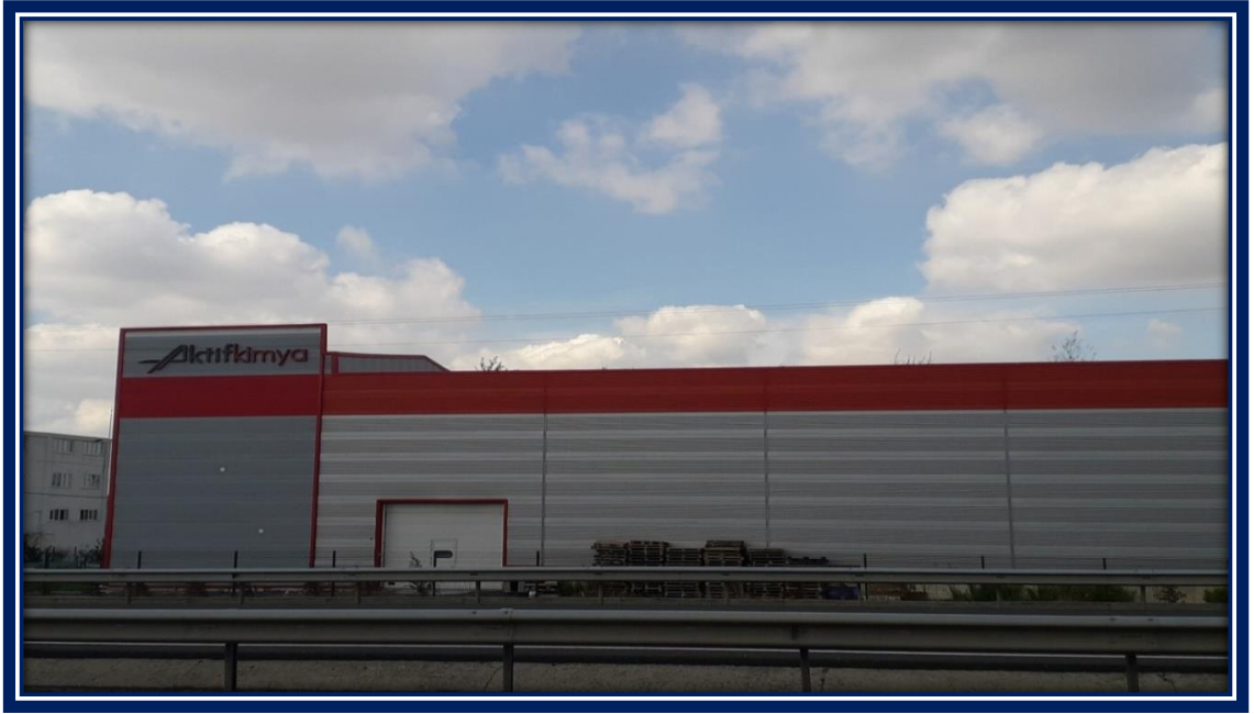
Fotoğraf 0-70: Çorlu- Çerkezköy yolunda faaliyet yürüten kimya sanayi tesislerinden bir örnek.
