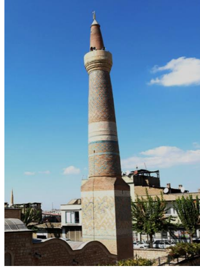
Foto 1.36. Siirt Ulu Camii minaresinin restorasyonun ardından görünümü.
