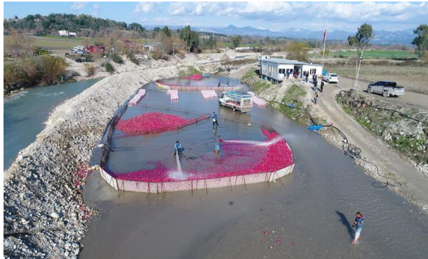
Foto 2.4. Savrın Çayı (Kadirli/Osmaniye) üzerinde set oluşturularak yapılan turp yıkama havuzları.
