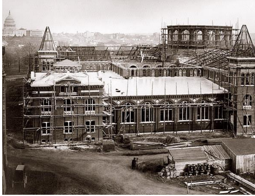
Resim 18: Sanat ve Endüstri Binası inşa aşaması.
