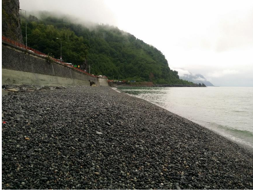
Şekil 3.21: 20. İstasyon-Sarp Sınır Kapısı.
