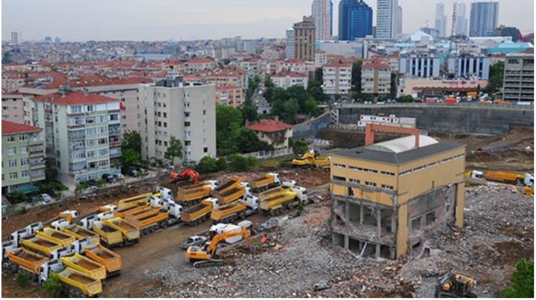
Fotoğraf 5: Mecidiyeköy Likör ve Kanyak Fabrikası'nın yıkılması
