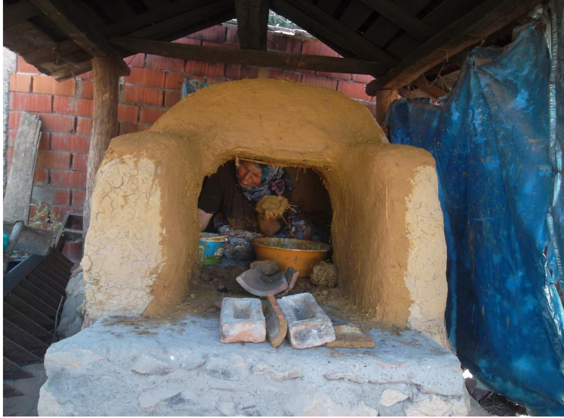
Fotoğraf 3: Fırının iç duvarlarının sıvanışı
