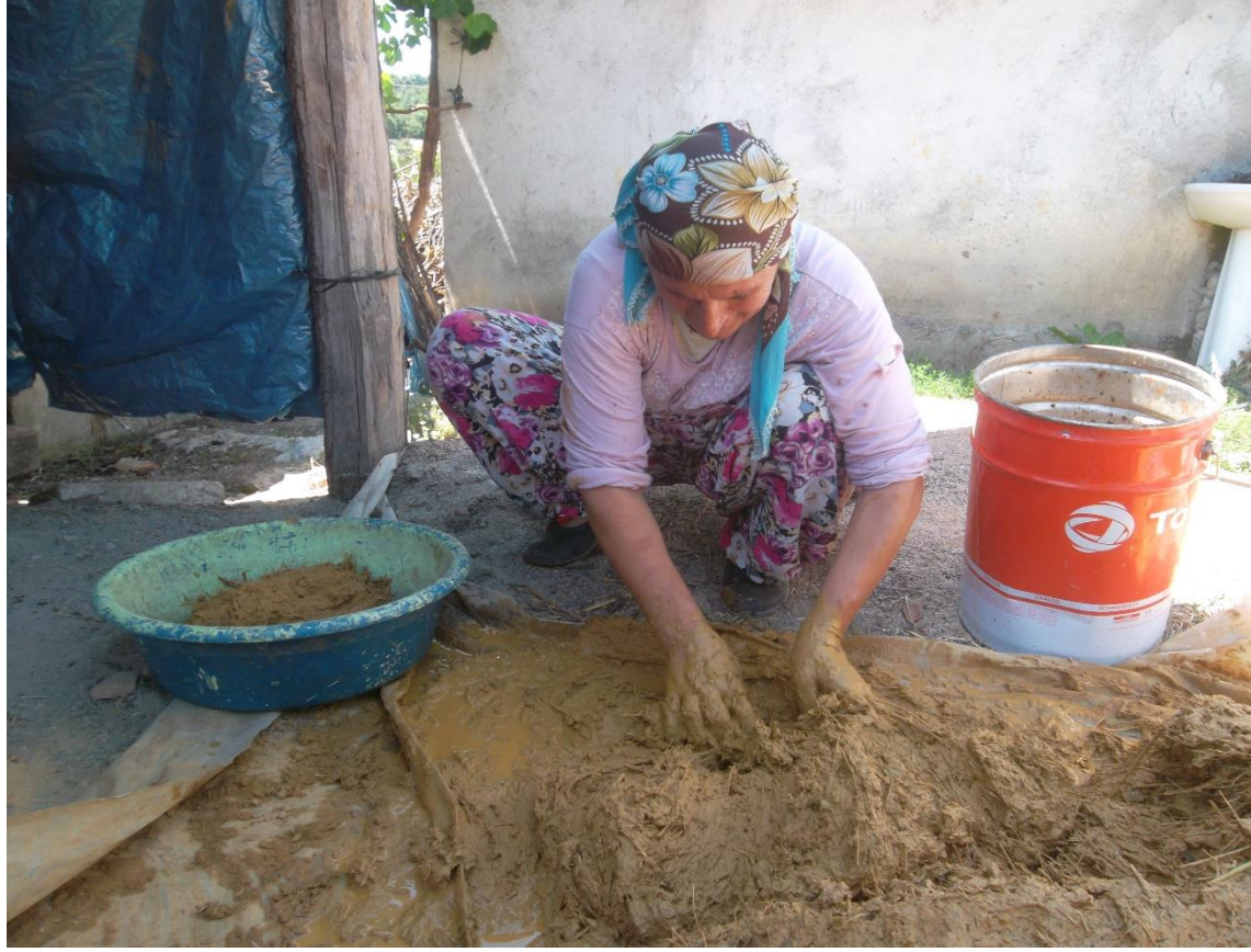
Fotoğraf 1: Harcın elle yoğurularak hazırlanışı
