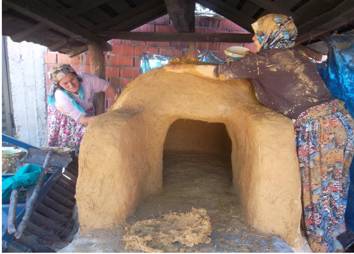
Fotoğraf 5: Fırının dış kısmın sıvanışı
