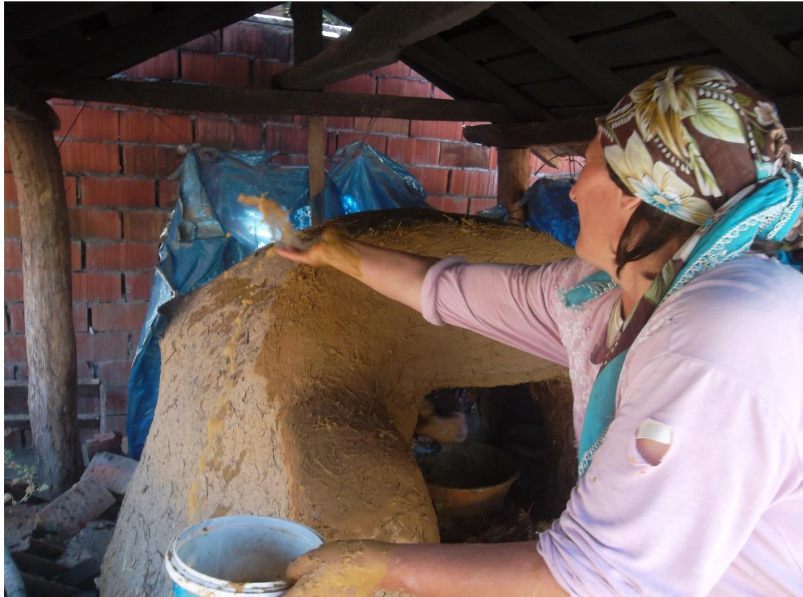
Fotoğraf 4: Fırının dış kısmının sıvanmadan önce ıslatılışı
