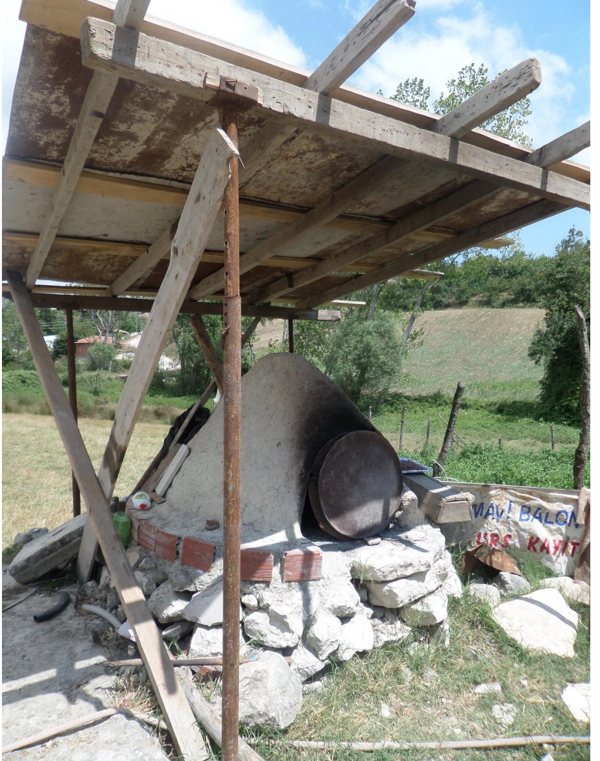
Fotoğraf 17: Bahçedeki Altı Taş ve Tuğla İle Örülü Üstü Kerpiç Sıvalı Fırın
