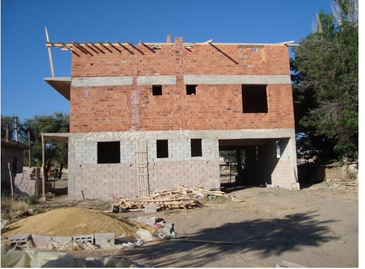
FOTOĞRAF 7: Yapılmakta olan betonerme ev
