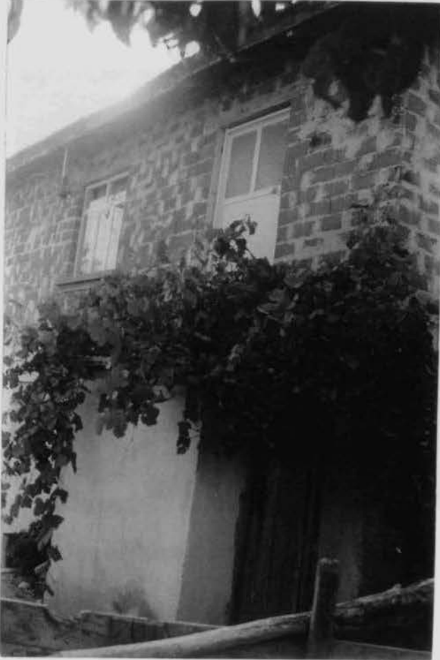
Fotoğraf – 26 Alt katında tuvaleti bulunan tuğla bir yapı örneği
