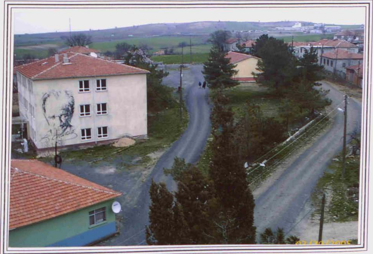
FOTOĞRAF-27- Kullanılmayan Üç Katlı Köy Okulunun Uzaktan Görünümü
