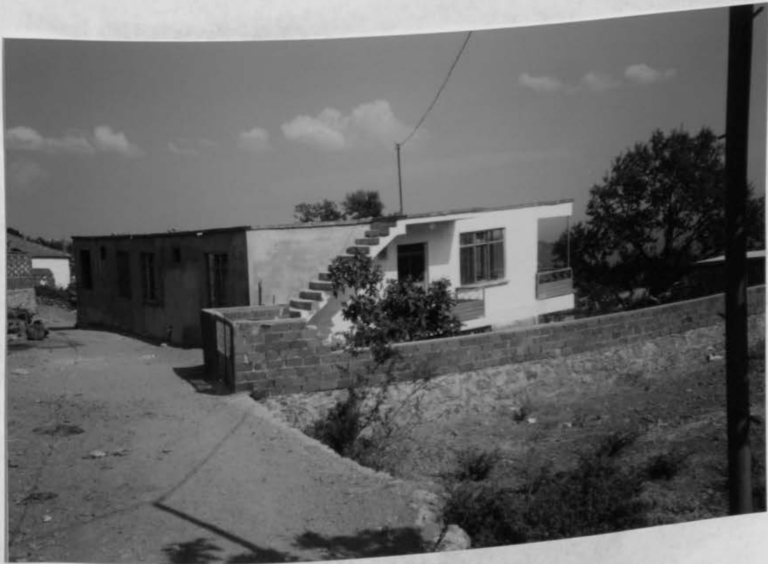
Resim No:28 Yeni yapılmakta olan bir ev
